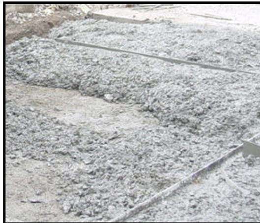
◦ **Curado del Concreto.** Esta labor se realiza con el fin de evitar fisuras de retracción, y obtener una buena resistencia del concreto, la cual se logra evitando la pérdida de agua de amasado por evaporación debido a la insolación y al viento.
