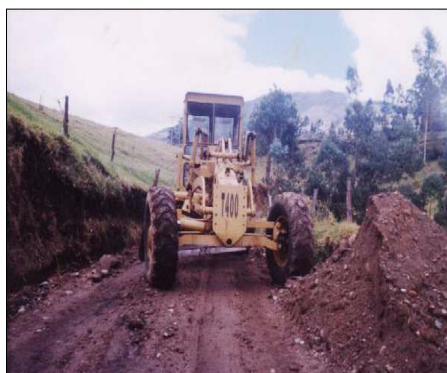
EXTENDIDO DE MATERIAL DE RECEBO CON MOTONIVELADORA
