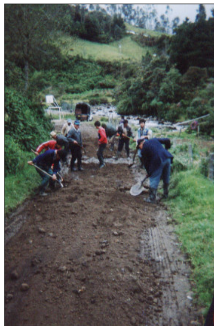
EXTENDIDO DEL MATERIAL MEDIANTE TRABAJO COMUNITARIO
