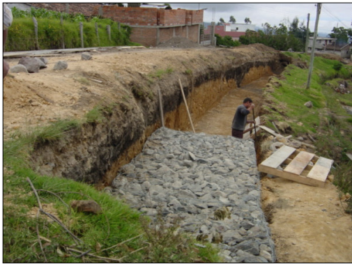
DETALLES CONSTRUCTIVOS – MURO EN GAVIONES
