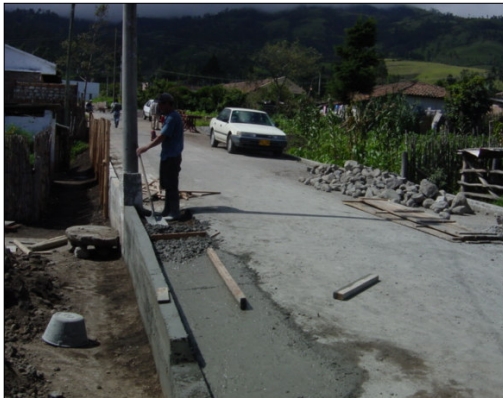
CONSTRUCCION DE CUNETAS EN V CON SARDINELES O BORDILLOS
