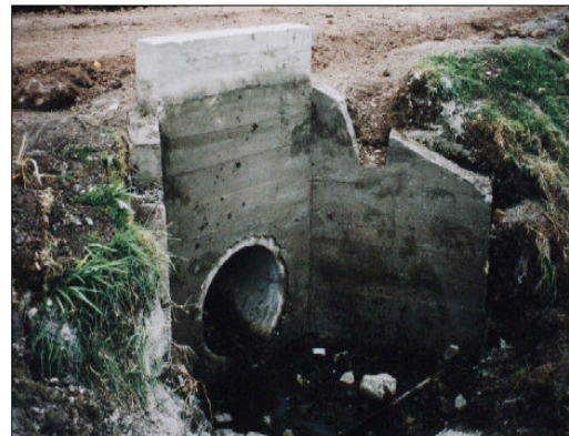
CONTRUCCION ALCANTARILLAS CON TUBERIA DE DIAMETRO 36"
