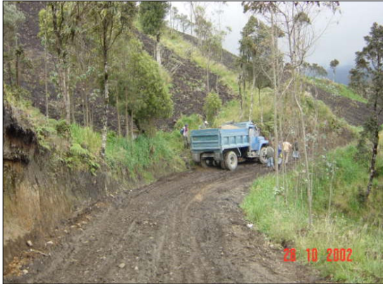
TRANSPORTE DE MATERIAL DE RECEBO DESDE LA MINA EL HUECO
