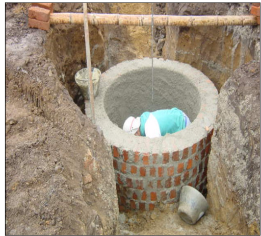
CONSTRUCCION DE CAMARAS
