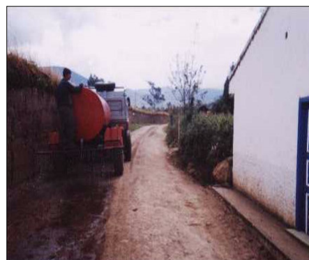
UTILIZACION DE TANQUE IRRIGADOR PARA HUMEDCER EL MATERIAL DE RECEBO
