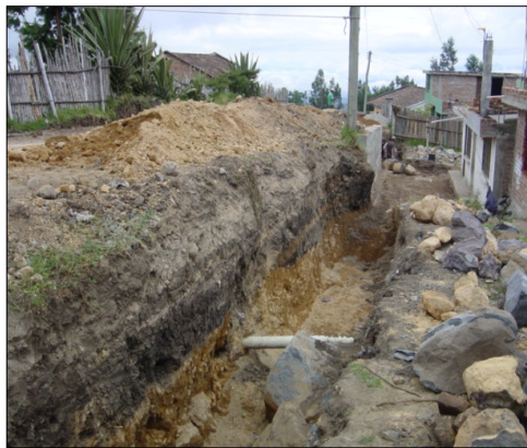
EXCAVACION PARA CONSTRUCCION DE MURO EN GAVIONES
