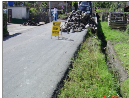
COLOCACION DE SEÑALES PREVENTIVAS
