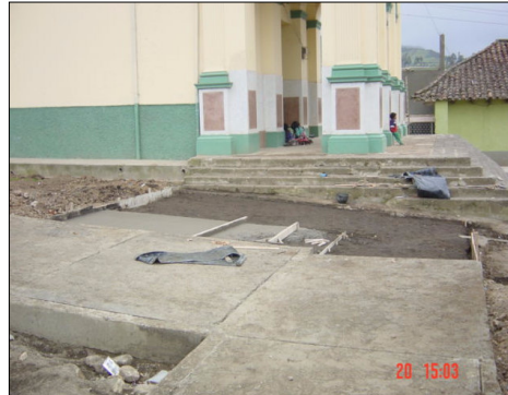
CONSTRUCCION DE EMPEDRADO ATRIO DE LA IGLESIA
