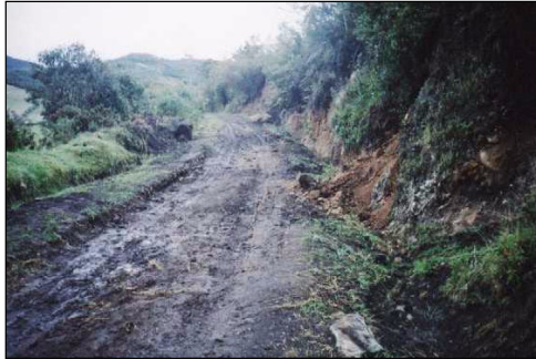
ESTADO INICIAL DE LA VIA
