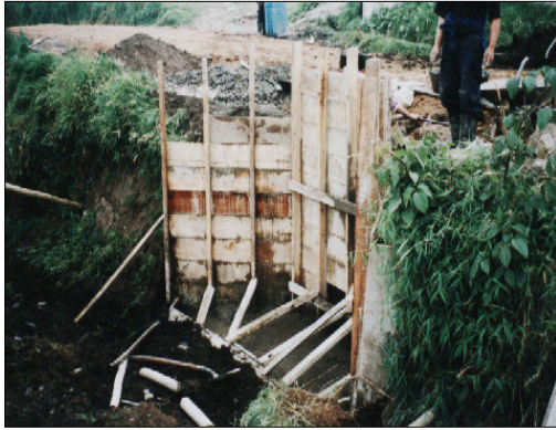
FUNDICION DE PANTALLA DE SALIDA
