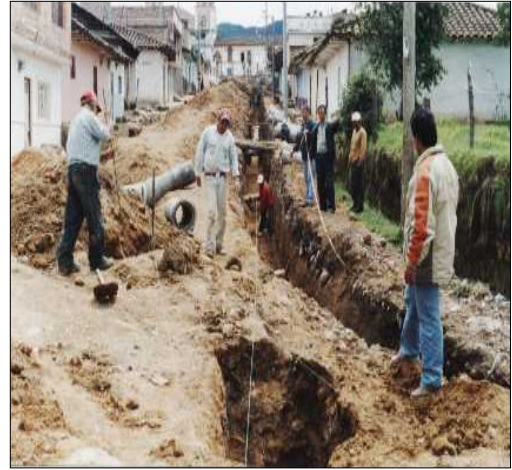
EXCAVACIONES PARA INSTALACION DE TUBERIA
