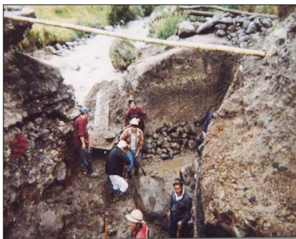
EXCAVACION PARA FUNDIR ZARPAS
