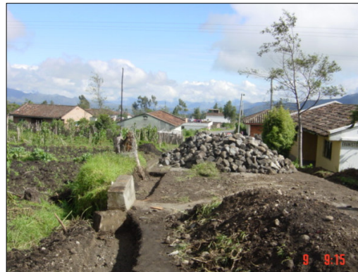
EXCAVACION PARA CONSTRUCCION DE CUNETAS
