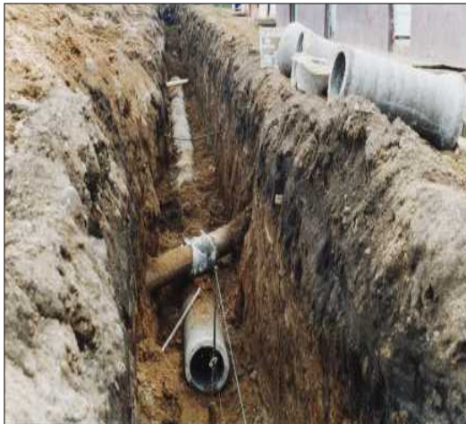
INSTALACION DE TUBERIA EN
