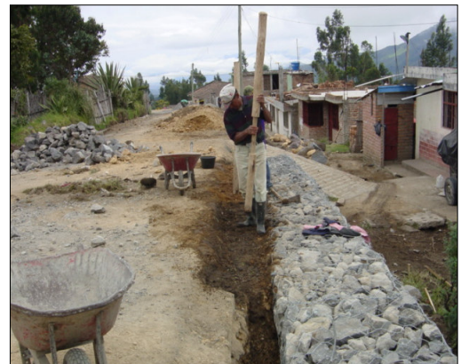
RELLENO Y COMPACTACION DE MURO EN GAVIONES
