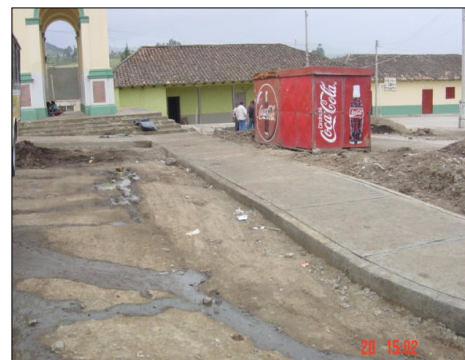
CONSTRUCCION DE ANDENES - SECTOR LATERAL DE LA IGLESIA
