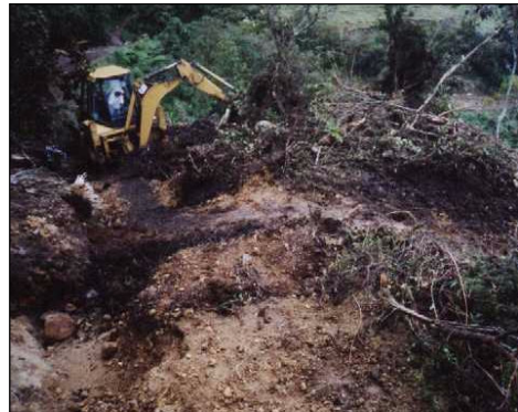
DESALOJO DE DERRUMBES CON RETROEXCAVADORA TRAMO SAN FRANCISCO BUESAQUILLO –EL CARMELO
