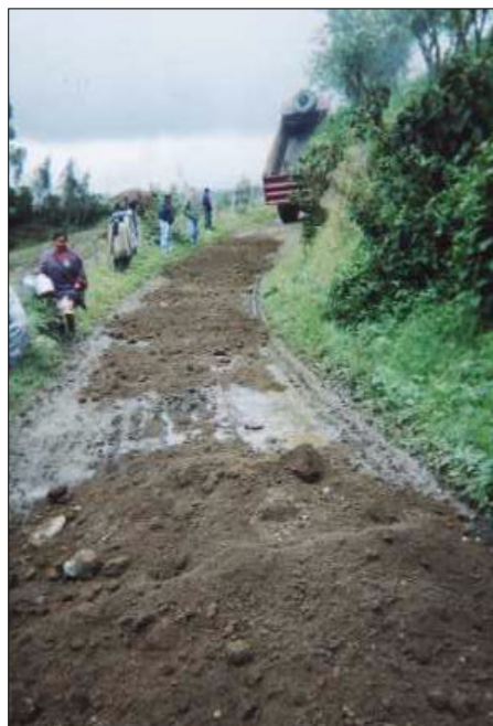
COLOCACION DE MATERIAL DE RECEBO POR VOLTEO DESDE EL MEDIO DE TRANSPORTE
