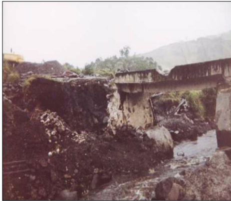
ESTADO INICIAL DEL PUENTE EXCAVACION INICIAL
