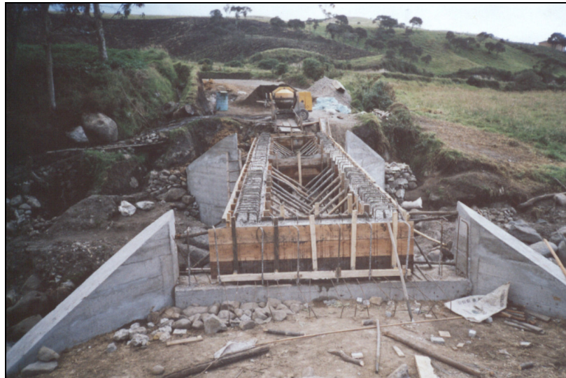
DETALLE DE CONSTRUCCION - ESTRIBOS TERMINADOS
