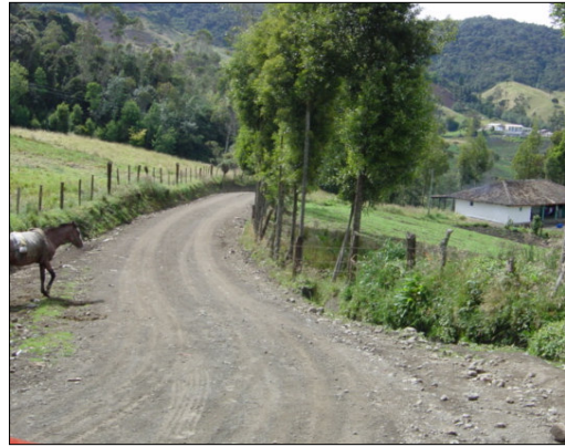
ESTADO FINAL DE LOS TRABAJOS DE AFIRMADO
