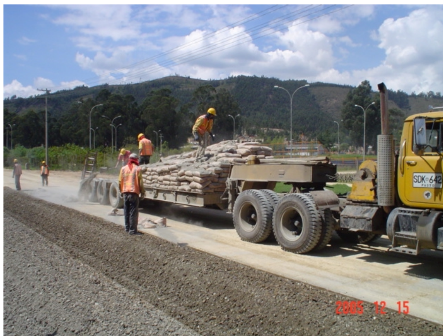
Figura 22. Aplicación del cemento
