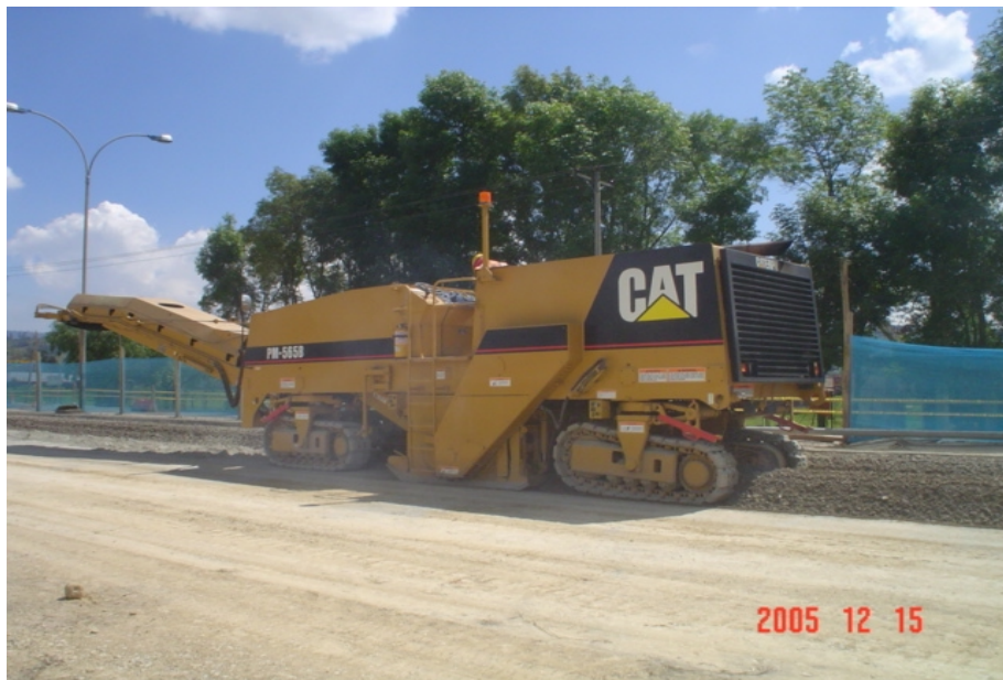
Figura 23. Mezcla de base estabilizada con cemento
