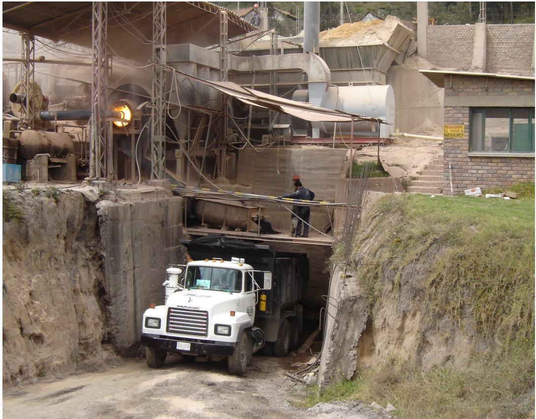
Figura 30. Descarga de mezcla asfáltica
