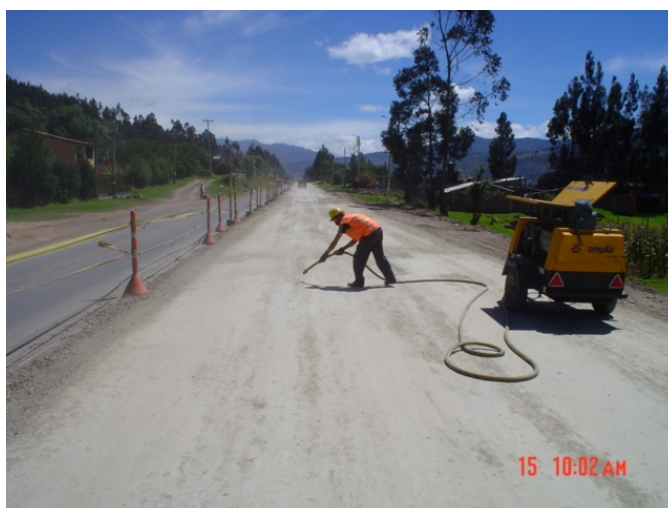
Figura 26. Preparación de la superficie existente para carpeta asfáltica
