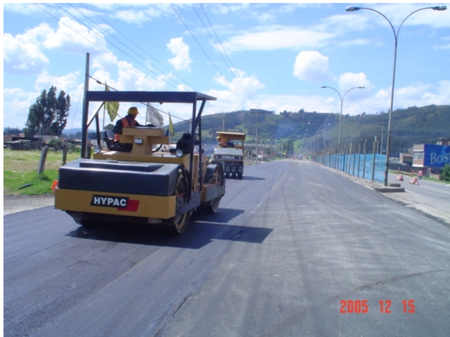
Figura 32. Compactación de mezcla asfáltica
