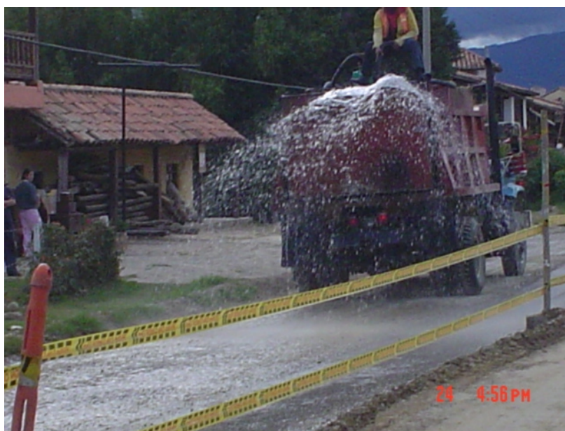
Figura 25. Curado de base estabilizada con cemento
