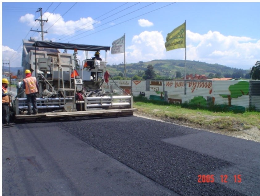
Figura 31. Extensión de mezcla asfáltica
