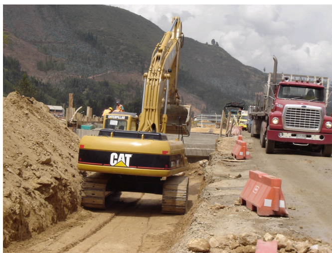
Figura 18 Conformación terraplén
