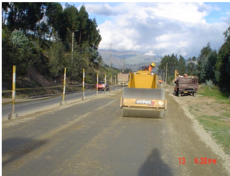
Figura 24. Compactación de base estabilizada con cemento
