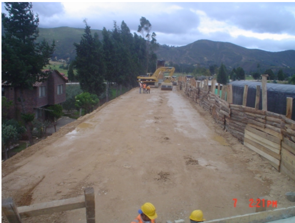
Figura 19. Corona de terraplén
