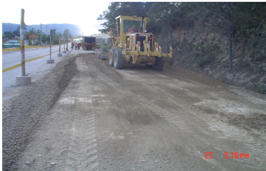
Figura 21. Preparación de la superficie existente
