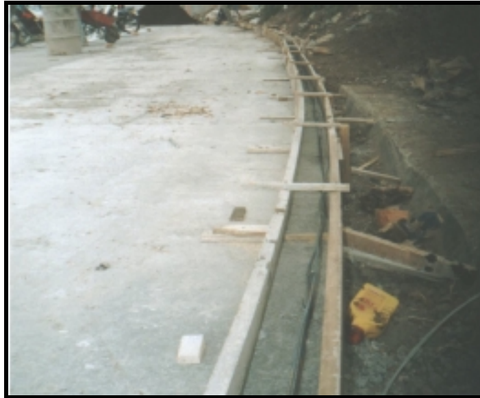
Figura 62.FUNDICIÓN SARDINEL
