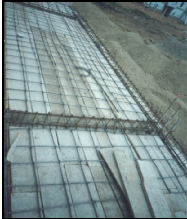
Anexo A . FUNDICIÓN LOSA CASETA
