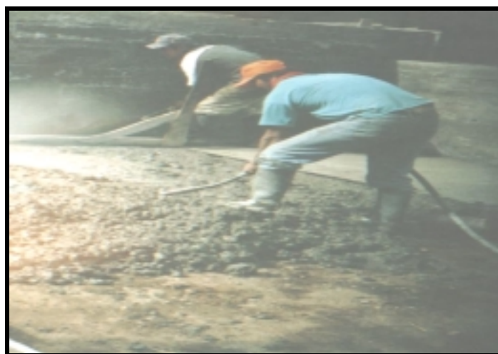
Figura 58. COMPACTACION DEL CONCRETO CON VIBRADOR DE AGUJA
