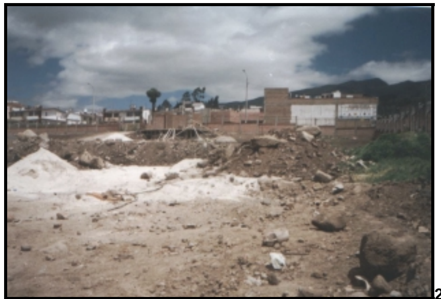
Figura 3. FOTOGRAFIA ESTADO INICIAL PARQUEADERO
