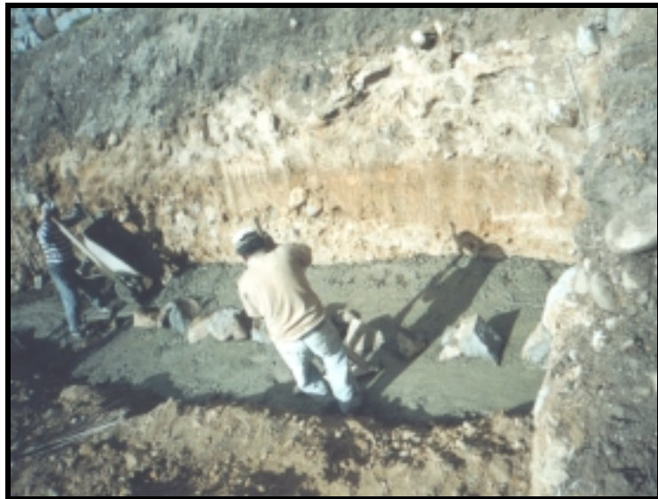
Figura 25. TENDIDO DE RAJON EN CAPAS DE 40 Cm
