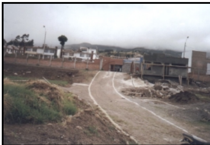
Figura 15. NIVELACIÓN Y DEMARCACIÓN DEL EJE DE LA VIA
