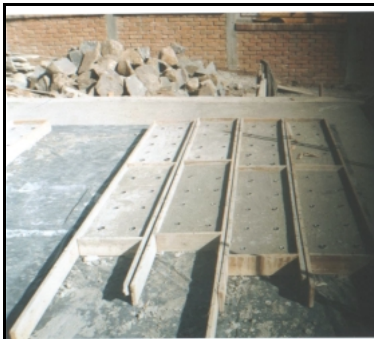
Figura 64. FUNDICIÓN TAPAS EN CONCRETO PARA CAÑUELAS CANCHA Y PARQUEADERO
