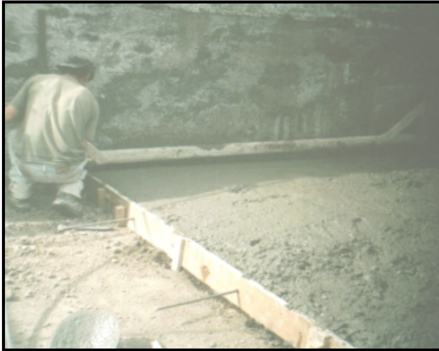
Figura 56. INSTALACION PASADORES DE ANCLAJE JUNTA LONGITUDINAL
