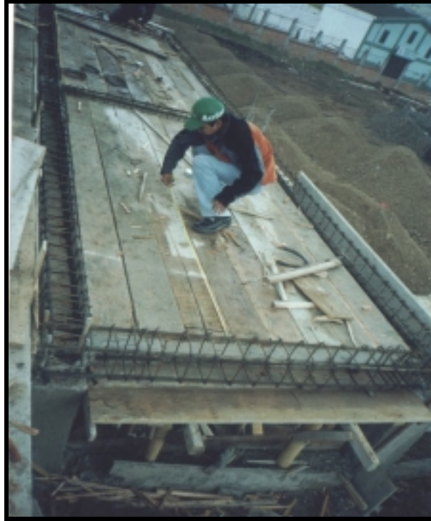
Anexo A . ARMADO REFUERZO LOSA MACISA CASETA
