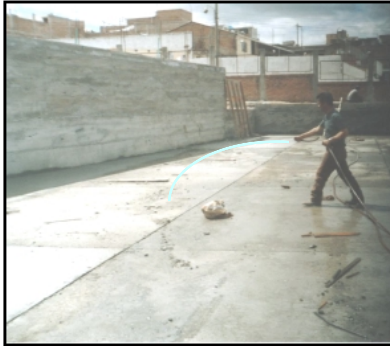
Figura 59. CURADO DEL CONCRETO
