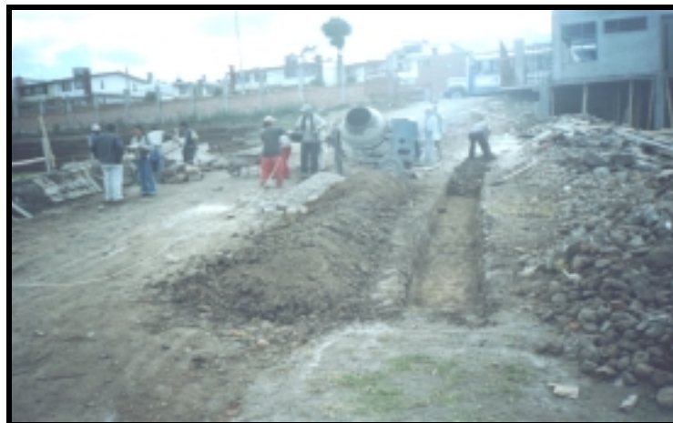
Figura 47. CONSTRUCCIÓN MUROS LATERALES EN LA VIA
