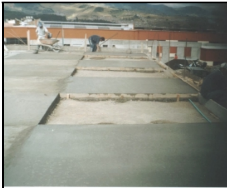
Figura 64. FUNDICIÓN TAPAS EN CONCRETO PARA CAÑUELAS CANCHA Y PARQUEADERO
