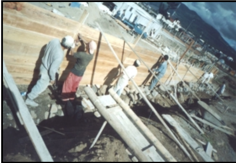
Figura 27. FORMALETA CUERPO DE MURO
