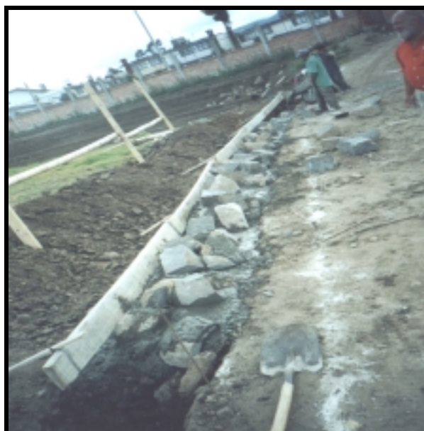
Figura 47. CONSTRUCCIÓN MUROS LATERALES EN LA VIA
