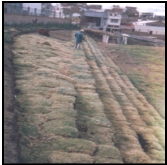
Anexo B. ADECUACIÓN GRADERÍA ESTADIO EN MATERIAL VEGETAL
