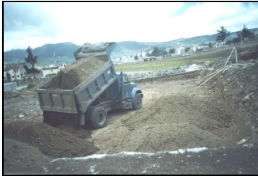
Figura 44.EXTENDIDO Y AIREACIÓN DEL MATERIAL DE BASE CANCHA
