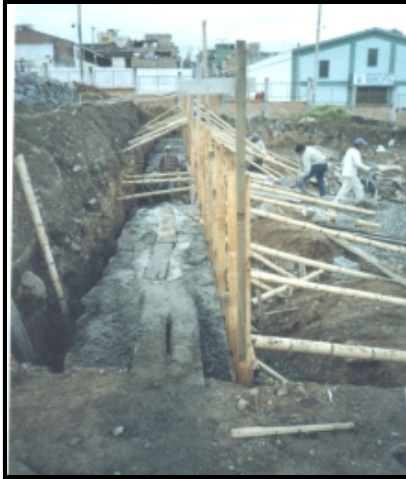
Figura 29. FUNDICION CORONA DE MURO
