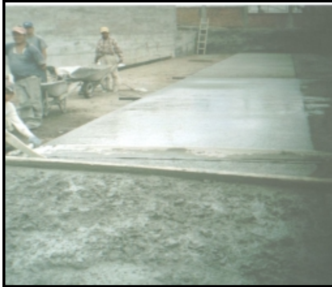
Figura 57. COLOCACION DEL CONCRETO
