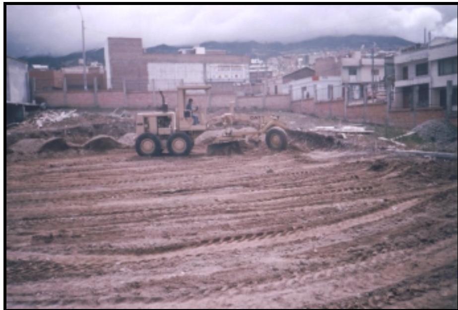
Figura 44.EXTENDIDO Y AIREACIÓN DEL MATERIAL DE BASE CANCHA
