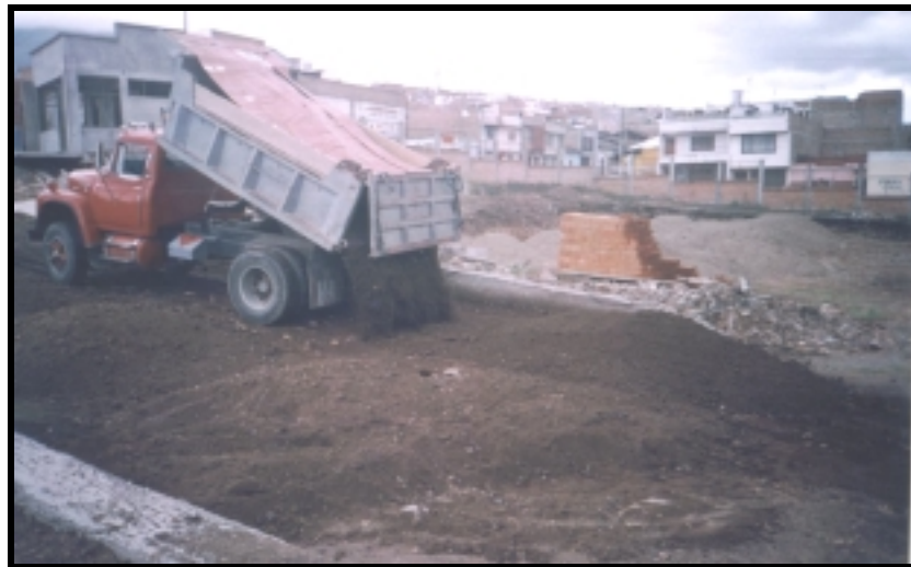
Figura 42. RECEPCIÓN DEL MATERIAL DE BASE VÍA
