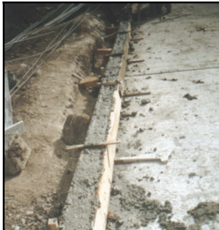
Figura 62.FUNDICIÓN SARDINEL
