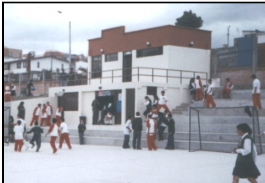
Anexo A . PANORAMICA CASETA TERMINADA
