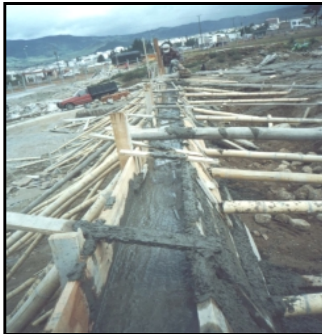
Figura 29. FUNDICION CORONA DE MURO
