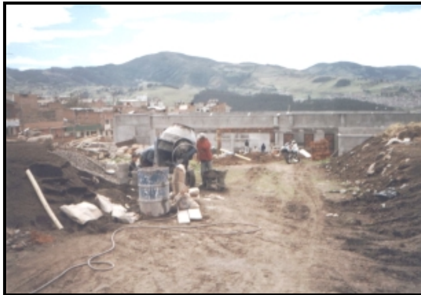
Figura 1. FOTOGRAFIA ESTADO INICIAL DE VIA
