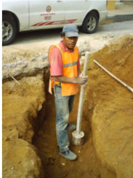
Para la conformación de la Subbase se acordona el material en la media calzada ya construida, el proceso de conformación se realiza manualmente y dejando 4 cm sobre el nivel de Subbase, estos centímetros de más se perderán en el proceso de compactación.
