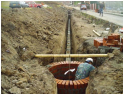
Durante la conexión de las cámaras de la calle 14 se procedió a tapar el alcantarillado sanitario de la carrera 37 mientras se construía una caja de inspección y su respectiva conexión a este, para así iniciar con la excavación de la zanja donde se ubicará el alcantarillado pluvial de esta vía.
