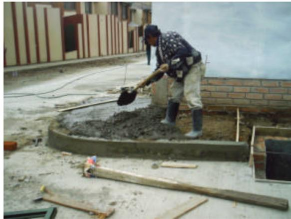
Durante la nivelación de subrasante de la carrera 37 se inicia el relleno del sistema sanitario de la calle 14 para continuar con la excavación para el alcantarillado pluvial. Se construyen las cámaras de alcantarillado pluvial y se instala tubería pluvial de 10", se tapa la tubería mientras se perfila la subrasante de este sector y se extiende el material para la subbase, se rellena las cámaras pluviales y se compacta.
