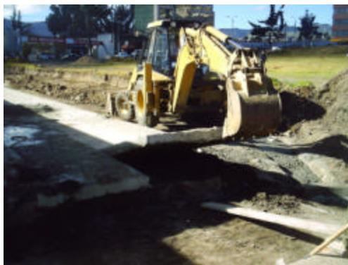
Una vez ejecutada la excavación de las zanjas se procedió con el perfilado y limpieza del fondo de la misma para posteriormente chequear las profundidades de excavación especificadas en el diseño, una vez cumplido este requisito y chequeado la tubería con estudios de laboratorio se autorizo la colocación de esta en sentido contrario al flujo de agua garantizando así que el peso de la tubería no desarrolle un desplazamiento y provoque fugas en el sistema.
