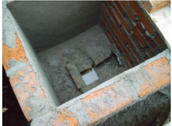
**Figura 62. Const. cámara Alcantarillado**
