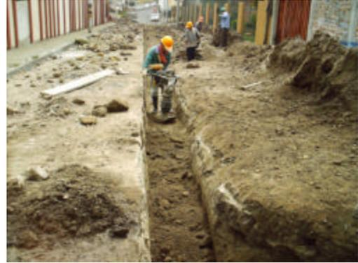
Durante la excavación de la carrera 37 se encontró la tubería de agua potable de 8" que sirvió de referencia para la localización del estado de redes de EMPOPASTO; hecha la excavación se colocó la tubería pluvial especificada en el diseño, se relleno la zanja y se procedió a perfilar la subrasante con el bombeo especificado.
