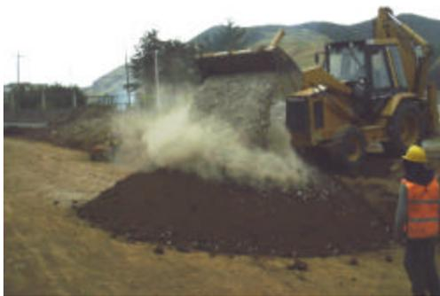
El proceso compactación se inicia dando una humedad óptima al material. Posteriormente se inicia el recorrido del rodillo para sellar la superficie mediante pasadas sucesivas y finalmente se aplica vibración al material. Terminada la compactación se ejecutan los ensayos de densidad de campo, para verificar las especificaciones establecidas para el caso (compactación superior al 95% del proctor). Con nivel de precisión se chequearon los niveles obtenidos, encontrando
