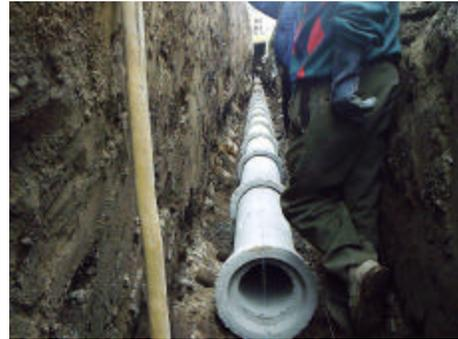
La tubería fue guiada con dos hilos, uno colocado en la parte superior de la línea de tubería para controlar la pendiente y el otro lateralmente para garantizar su alineamiento a lo largo del tramo.
