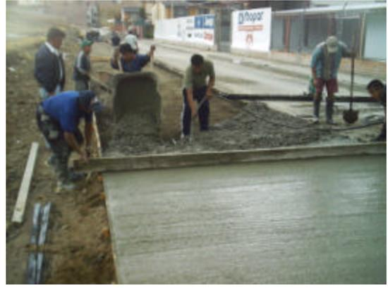
**Figura 36. Vibrado con Regla**
