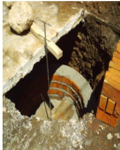
En el proceso de nivelación de subrasante se utilizo hilos horizontales y diagonales como guías para garantizar los espesores especificados en el diseño.
