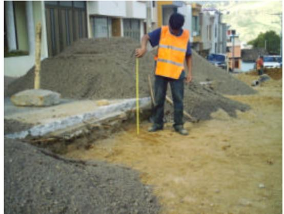
Simultáneo a estos trabajos se da inicio a la demolición de las tapas de las cámaras de alcantarillado y a la construcción del sumidero proyectado en la abcisa k0+030. Ya realizada la demolición de tapas se da paso a la demolición de la junta machihembrada existente en el pavimento viejo del resto de la calzada.
