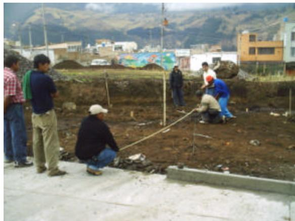
Una vez localizados los andenes se procede con la nivelación de subrasante para la conformación de la subbase que soportara las placas de concreto que formaran los andenes, luego se coloca la formaleta y se funde.
