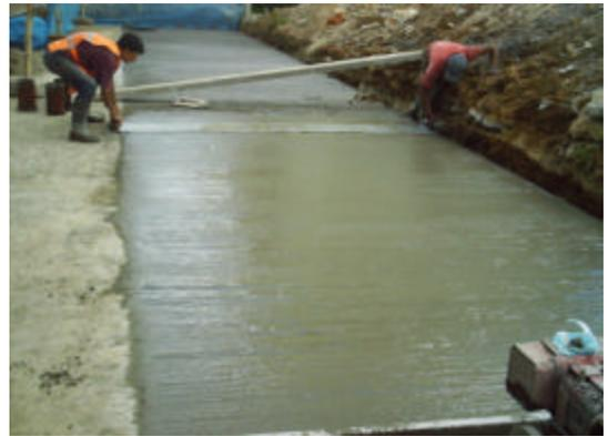
Para la construcción del sardinel se alinea con el sardinel del pavimento existente y se obliga el arranque en los primeros 10 mt debido desfase con la placa existente, luego se formaletea y se funde.
