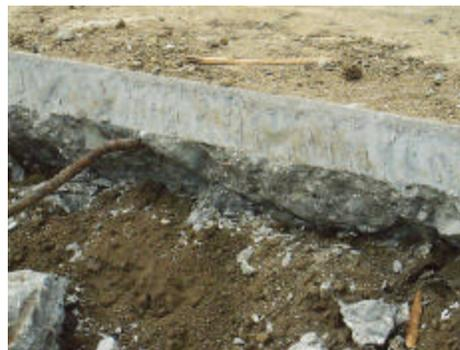
Cumplidas la conexiones de la cámara de alcantarillado en k0+00 y Sumidero se procede a rellenar las zanjas para iniciar con la conformación de la subbase. Los rellenos realizados culminada la cámara se efectuaron con mezcla suelo cemento en relación 1:4 debido a que era imposible dar una buena compactación en los alrededores.
