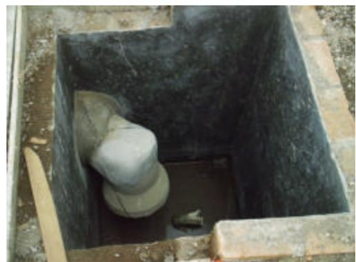
En la conexión de estos a la cámara de inspección, debido a la altura que presenta la cota dave en la salida del sumidero se ve la necesidad de proteger dicha conexión con una armadura en concreto que se denomina blindaje, conformada por un refuerzo en hierro ( $\varnothing$  3/8" L=2.12m y L=1.41m) y un concreto de alta resistencia (3500 psi), formando una viga canal invertida.
