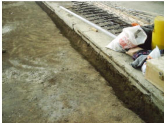
Luego se coloca la formaleta a 3.50 metros del eje de la vía y empalmado con pavimento nuevo de la paralela vía panamericana sentido Cali-Ipiales y terminando en el empalme con los paños del pavimento que conecta a Las Margaritas.
