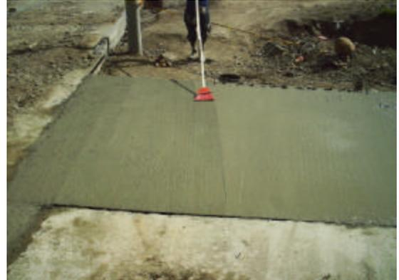
Terminada la fundición se procede a la construcción de los sardineles, para ello se colocan tablas de la altura especificada del sardinel en este caso de 15 cm de altura con una separación en la corona de 10 cm.
