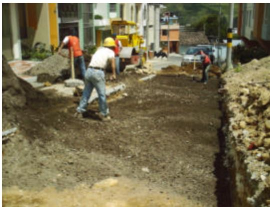
La compactación se realiza con un vibrocompactador que estático transmite una carga de 7 toneladas, las primeras pasadas de esta maquina las realiza sin vibración para permitir que las partículas del material de subbase se acomoden. Una vez precompactada la subbase se proporciona el vibrado para que esta capa alcance la densidad requerida según el diseño.
