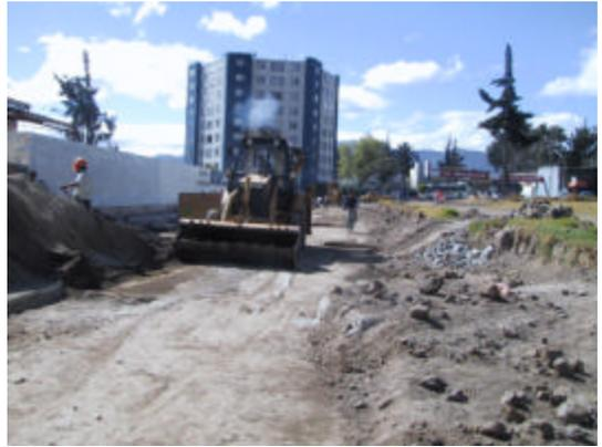
**Figura 22. Nivelación Subbase**
