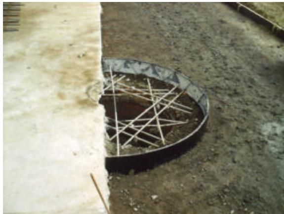
Posteriormente se construye la placa de rodadura de la media calzada de barrio SAN JUAN DE DIOS con un espesor de 16 cm, un ancho de 3 mt y una longitud de 75.1 mt empalmada al pavimento ya existente de la calle 15 con una viga “junta de expansión”, además se fundió la parte demolida de la acometida de acueducto. El proceso constructivo de la placa de pavimento es similar a la utilizada en la pavimentación de Prados del Oeste.
