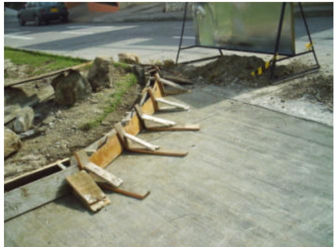
Las tapas de las cámaras de alcantarillado como la del sumidero fueron fundidas después de la fundición de la placa. A los dos días de fundición y una vez adquirida resistencia el concreto se procede a pasar las juntas del pavimento existente hacia el recién fundido para que los esfuerzos transmitidos por este no
