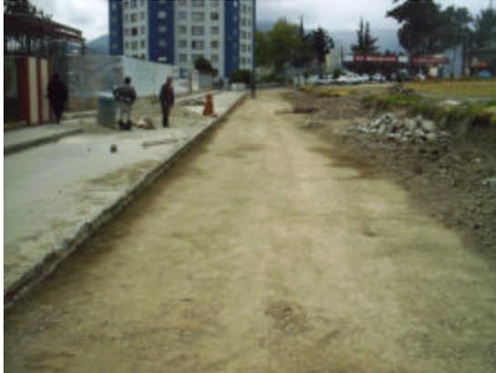
Para la pavimentación de la calle 14 se procedió a la excavación de una cajilla para la junta de expansión que se ubicara sobre el eje de la vía con una dimensión de 20x 25 cm con una longitud de 169.9 metros.
