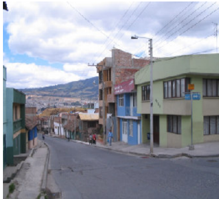
Figura 46. Aspecto general de la intersección Carrera 24 con Calle 28
