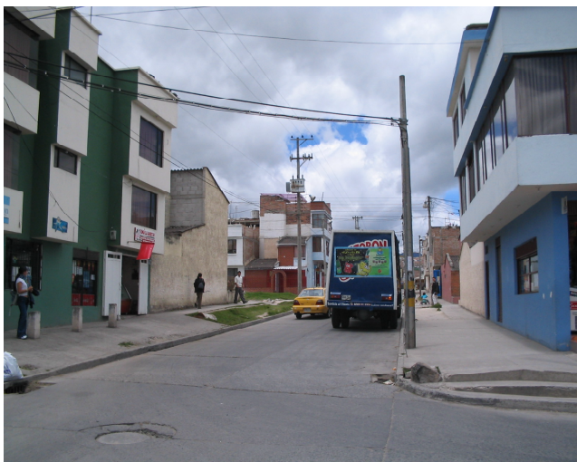
Figura 60. Aspecto general de la intersección Carrera 9 E con Calle 21D
