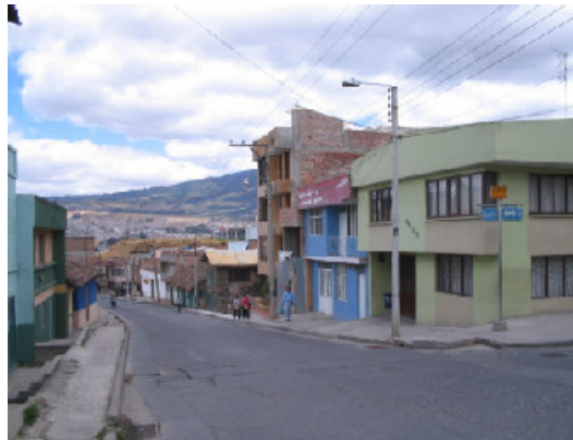
Figura 52. Aspecto general de la intersección Carrera 24 con Calle 28
