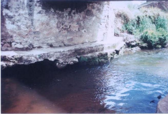
Figura 89 Elaboración de muro separador de caudales
