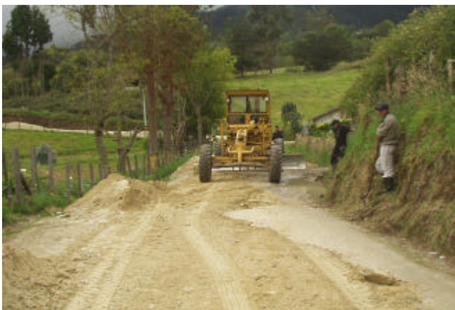
Figura 71. Tendido de material en la vía
