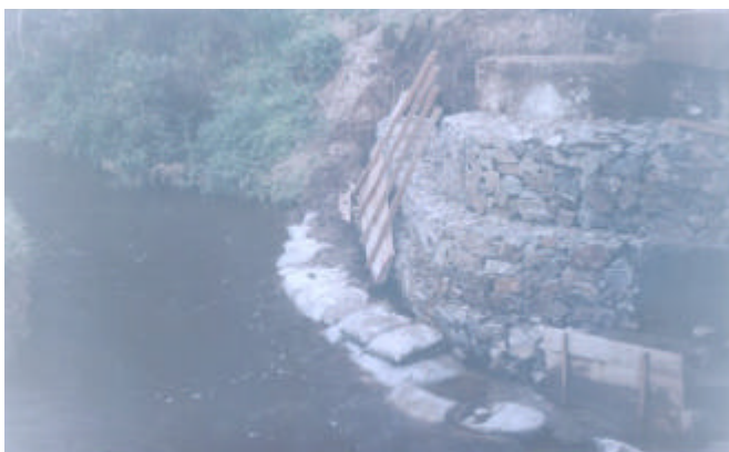
Figura 97. Construcción muro de gaviones
