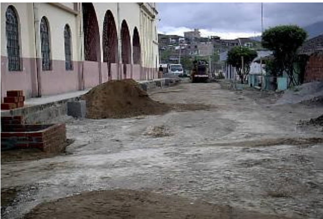
Figura 44. Recebo para base del pavimento
