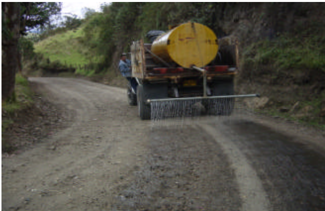
Figura 63. Compactación del material
