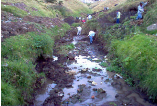
Figura 6. Excavación para desvío de la quebrada Guachucal
