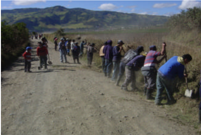
Figura 113. Tendido de material realizado por la comunidad
