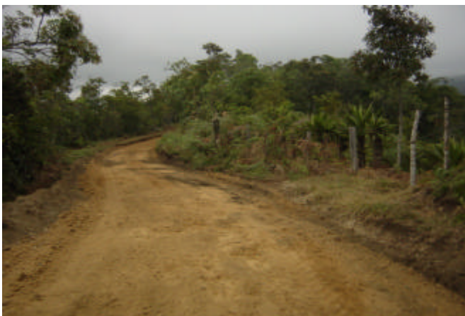
Figura 85. Recebo extendido en la vía
