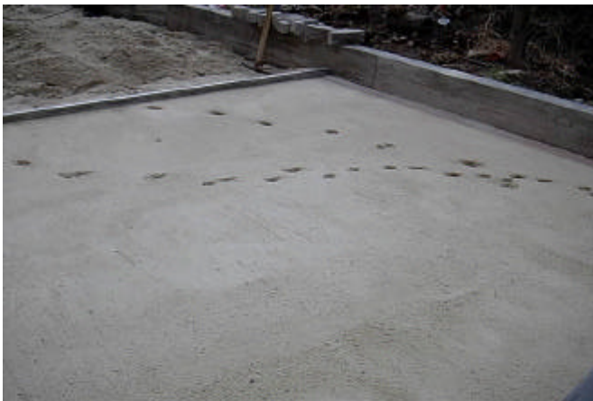
Figura 53. Instalación de adoquin
