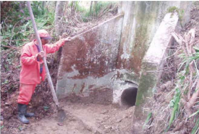
Figura 31. Limpieza de descole de alcantarillas.
