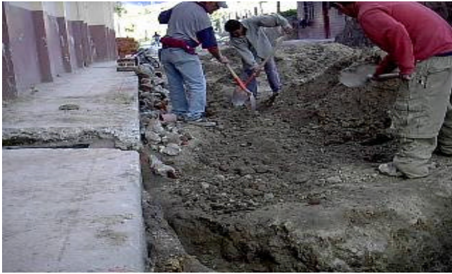
Figura 37. Caja de inspección de bajante templo.
