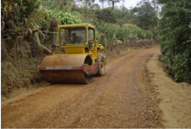
Figura 86. Compactación de material en la vía
