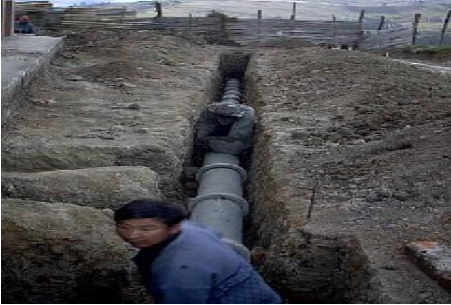
Figura 43. Excavación para sumidero
