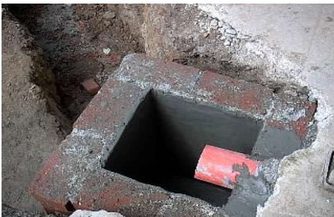
Figura 38. Caja de inspección bajante templo
