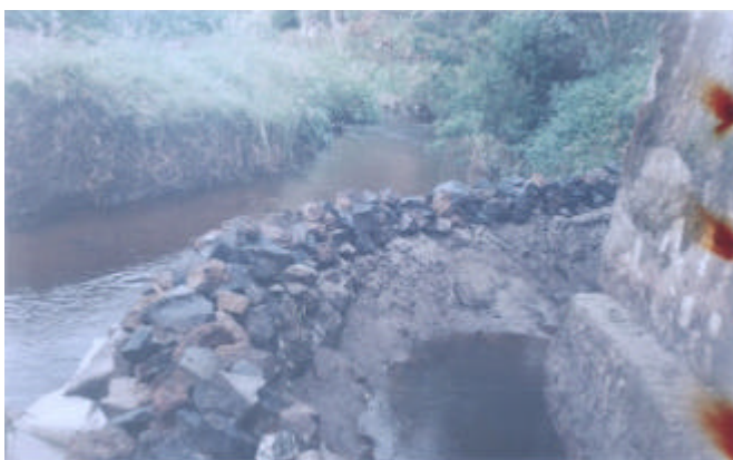
Figura 97. Construcción muro de gaviones
