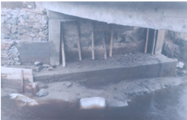
Figura 99. Estado final de zarpa, columnas y viga
