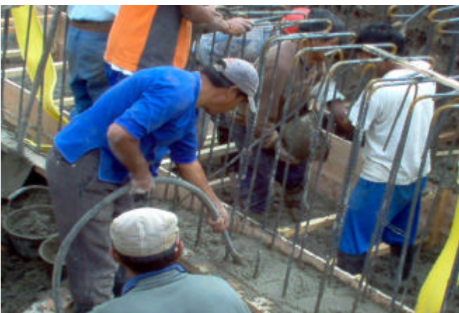
Figura 13. Vibrado del concreto
