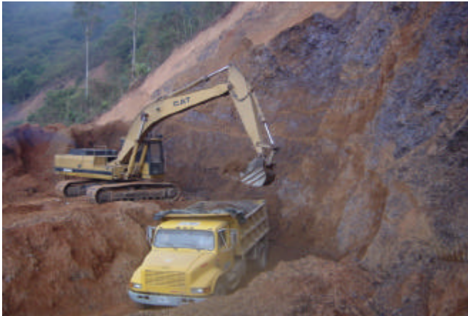
Figura 60. Acordonamiento de material a un costado de la vía
