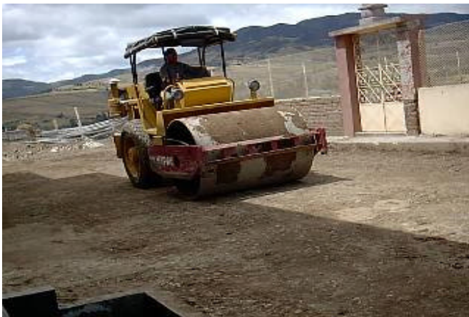
Figura 47. Humedecimiento del recebo para compactación
