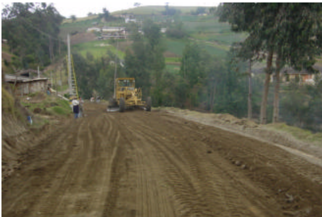
Figura 111. Tendido de material con moto-niveladora
