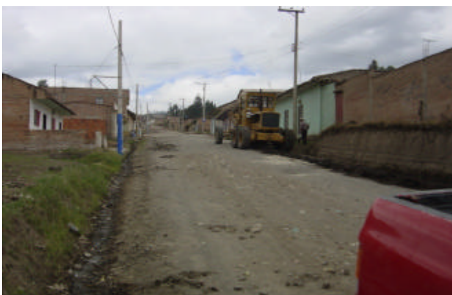
Figura 114. Perfilado de cunetas
