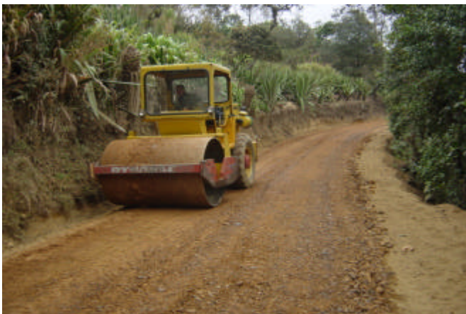
Figura 63. Compactación del material
