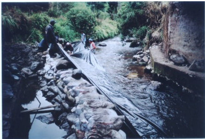
Figura 89 Elaboración de muro separador de caudales
