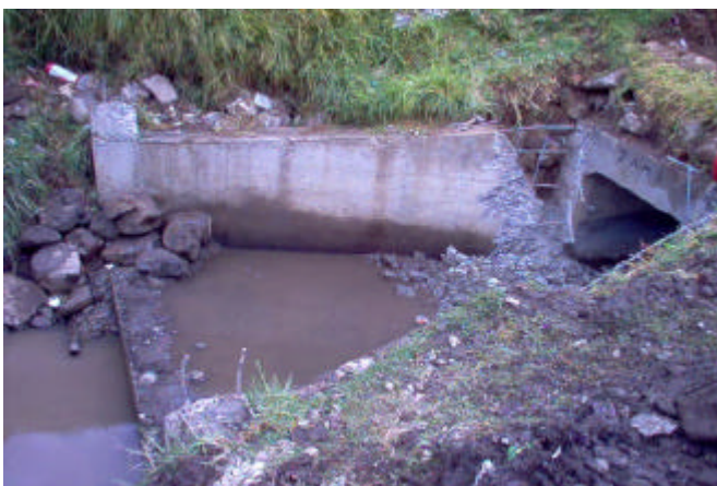
Figura 7. Demolición de la estructura del antigua box culvert.
