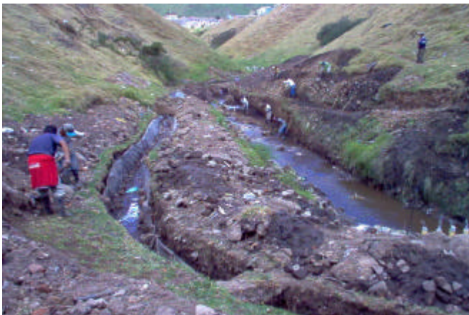
Figura 7. Demolición de la estructura del antigua box culvert.
