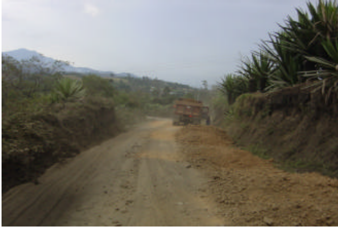
Figura 84. Excavación para la construcción de alcantarilla
