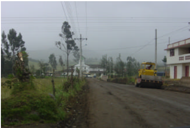
Figura 102. Compactación de material
