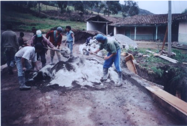
Figura 92 Fundición de zarpa
