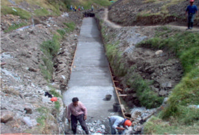
Figura 12. Refuerzo del box culvert.
