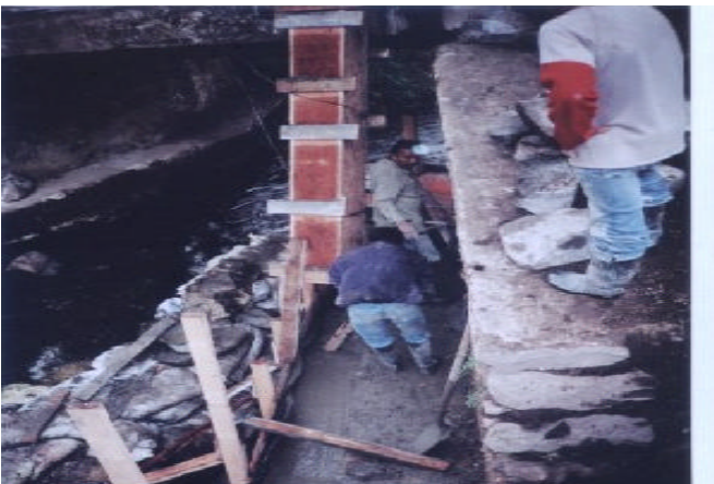
Figura 92 Fundición de zarpa
