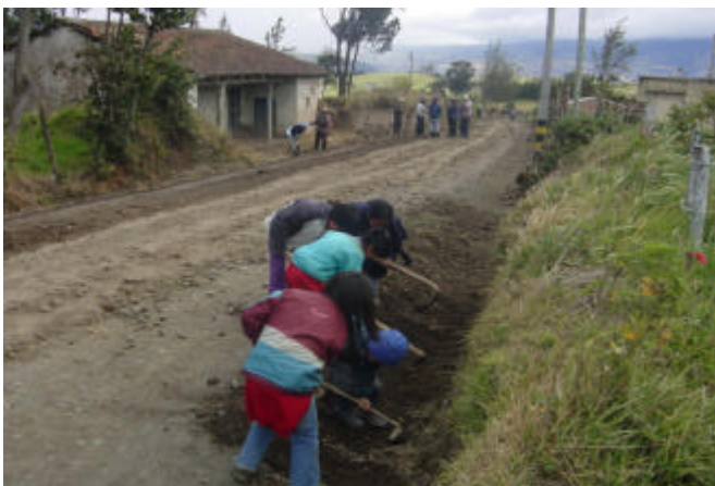
Figura 105. Cuneteo por parte de la comunidad
