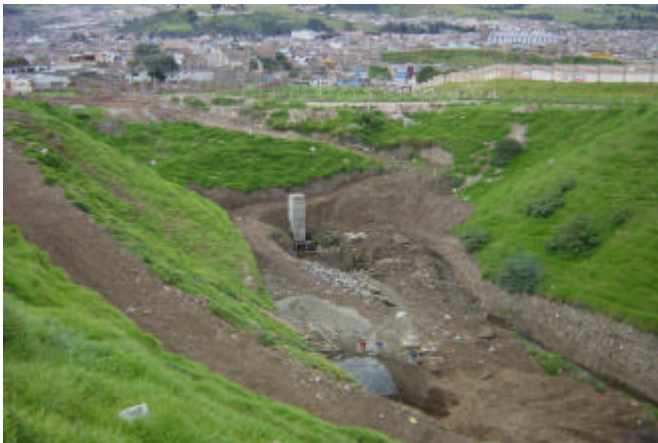
Figura 15. Vista final cámara de inspección box culvert.
