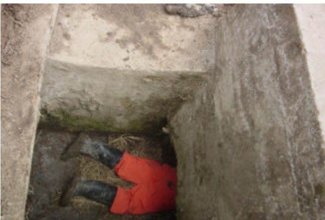
Figura 20. Limpieza de alcantarillas
