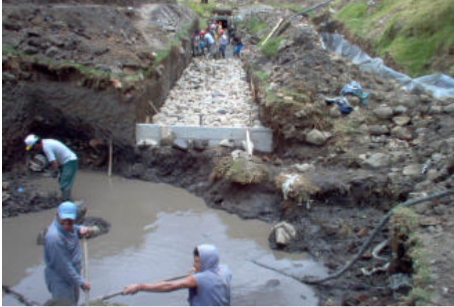
Figura 9. Vaciado de concreto para la base y solado del box culvert.
