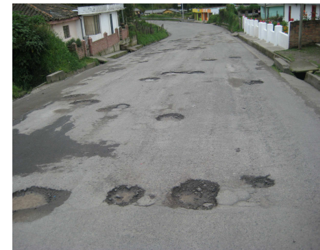
Imagen 3. Piel de cocodrilo PR 85+0650 - Descascaramiento PR 87+0125
