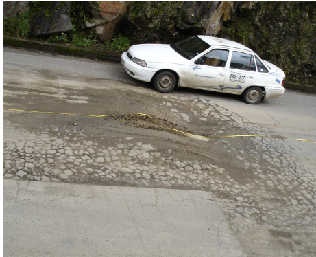
Imagen 2. Piel de cocodrilo PR 82+0100 - Descascaramiento PR 83+0365
