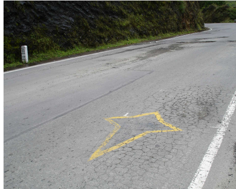
Imagen 2. Piel de cocodrilo PR 82+0100 - Descascaramiento PR 83+0365
