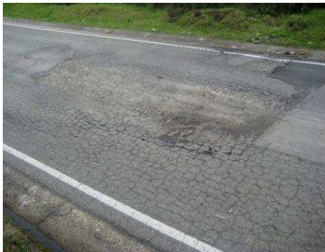
Imagen 3. Piel de cocodrilo PR 85+0650 - Descascaramiento PR 87+0125
