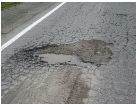
Imagen 3. Piel de cocodrilo PR 85+0650 - Descascaramiento PR 87+0125
