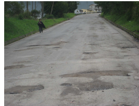
Imagen 3. Piel de cocodrilo PR 85+0650 - Descascaramiento PR 87+0125
