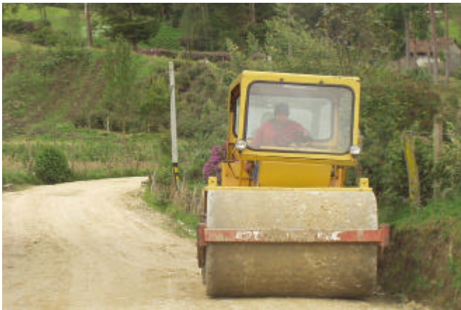
Figura 27. Vibrocompactador realizando tareas de compactación en la vía
