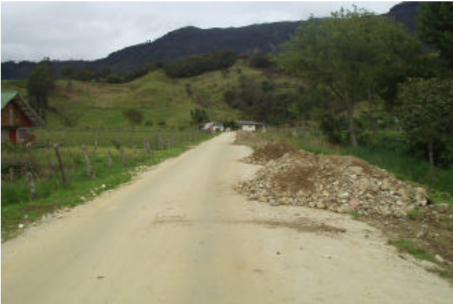
Figura 68. Acordonamiento de material en la vía
