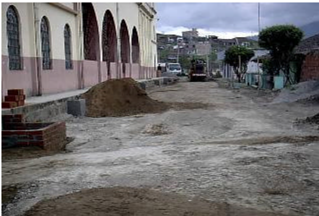
Figura 44. Recebo para base del pavimento
