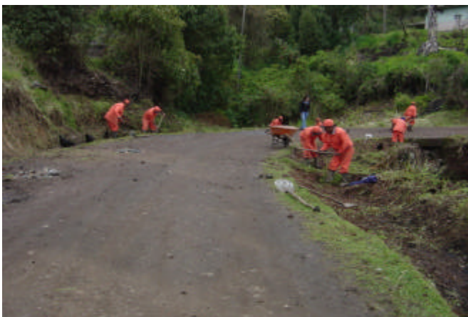
Figura 23. Cueneteo de la vía realizado por los microempresarios
