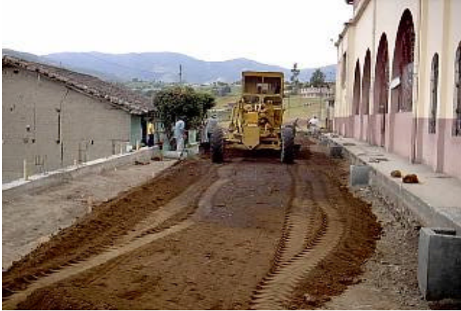
Figura 46. Compactación de recebo
