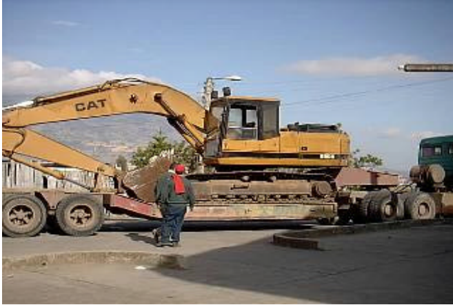
Figura 40. Cargue de material de la obra
