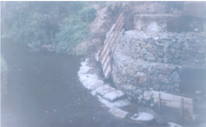
Figura 97. Construcción muro de gaviones
