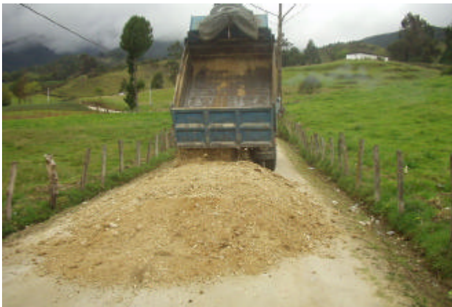
Figura 25. Material de la mina siendo regado en la vía
