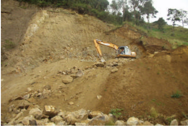
Figura 25. Material de la mina siendo regado en la vía
