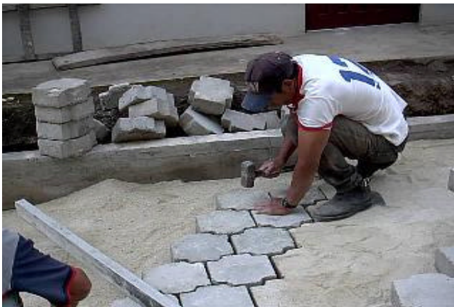
Figura 53. Instalación de adoquin
