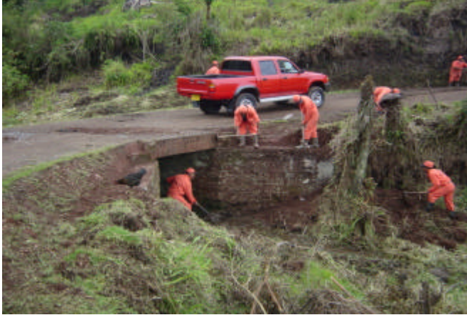
Figura 22. Limpieza de ponton a cargo de los microempresarios
