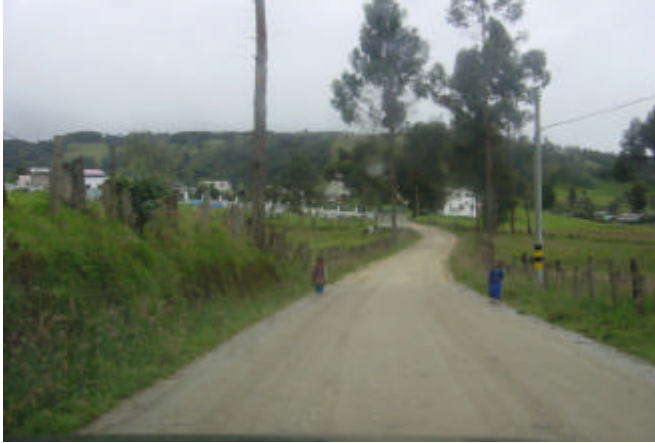
Figura 80. Estado final vía
