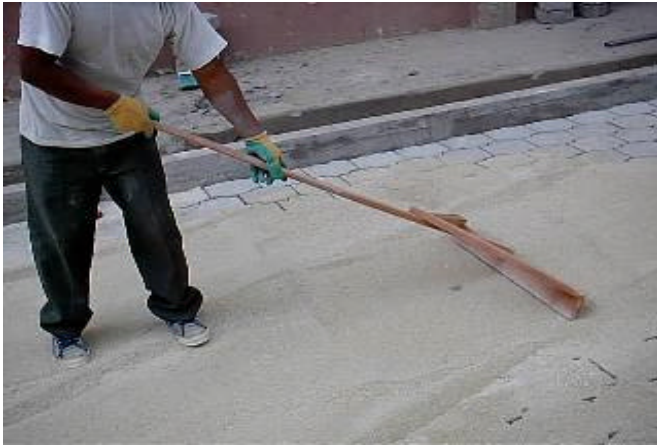
Figura 55. Cheque de niveles para empalme con pavimento existen
