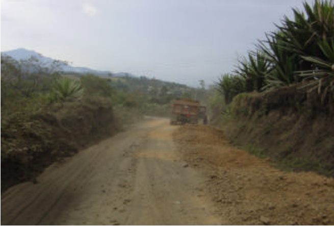
Figura 84. Excavación para la construcción de alcantarilla
