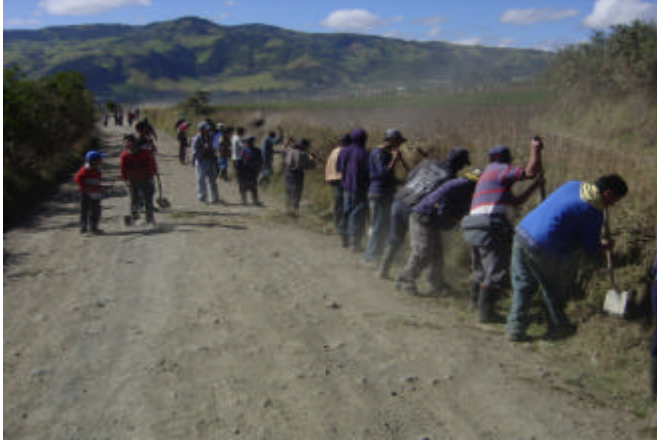
Figura 113. Tendido de material realizado por la comunidad
