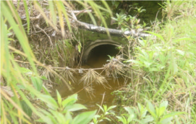
Figura 34. Descole en mal estado falto de limpieza.
