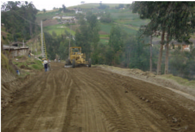
Figura 79. Tendido de material
