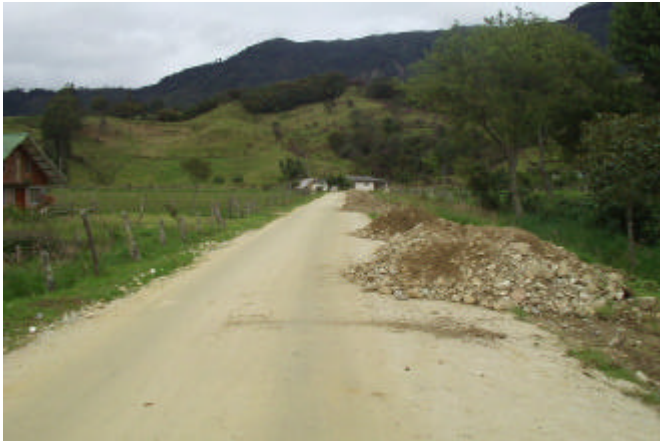
Figura 29. Acordonamiento de material
