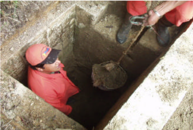
Figura 31. Limpieza de descole de alcantarillas.
