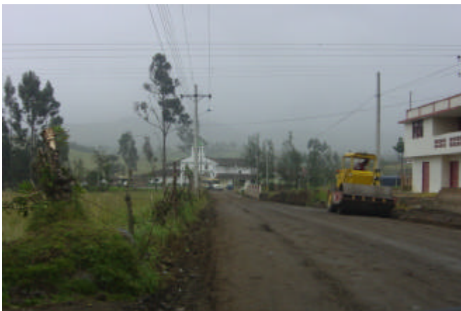
Figura 102. Compactación de material
