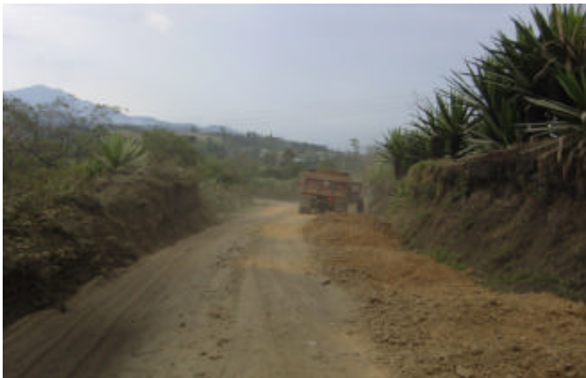
Figura 60. Acordonamiento de material a un costado de la vía
