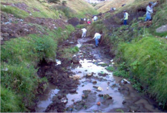
Figura 6. Excavación para desvío de la quebrada Guachucal
