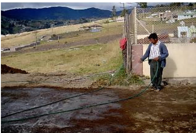
Figura 47. Humedecimiento del recebo para compactación
