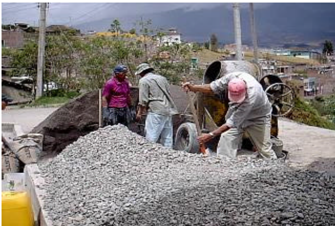
Figura 50. Materiales para la elaboración del concreto de los sardineles
