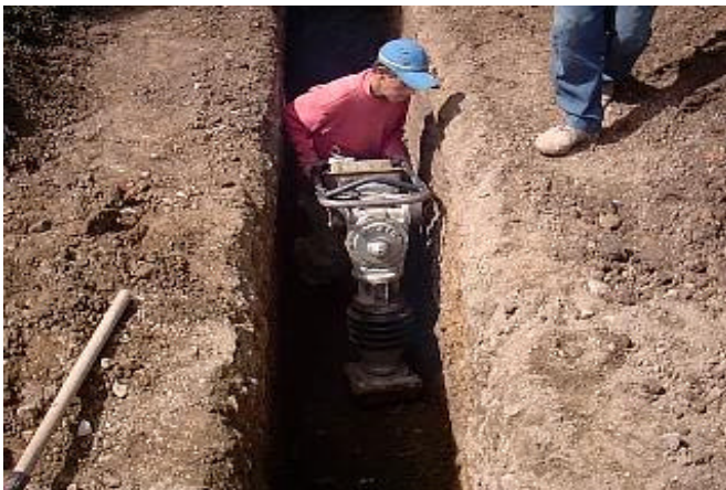
Figura 41. Compactación con saltarin en las zanjas de las acometidas
