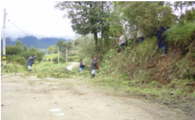
Figura 105. Cuneteo por parte de la comunidad
