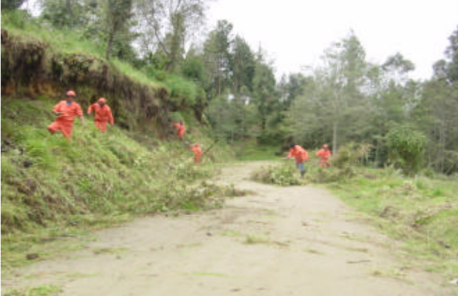
Figura 33. Cuneteo realizado en la via por los microempresarios
