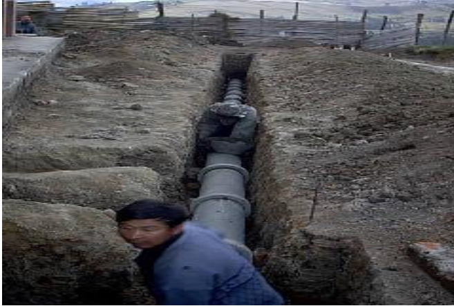
Figura 43. Excavación para sumidero
