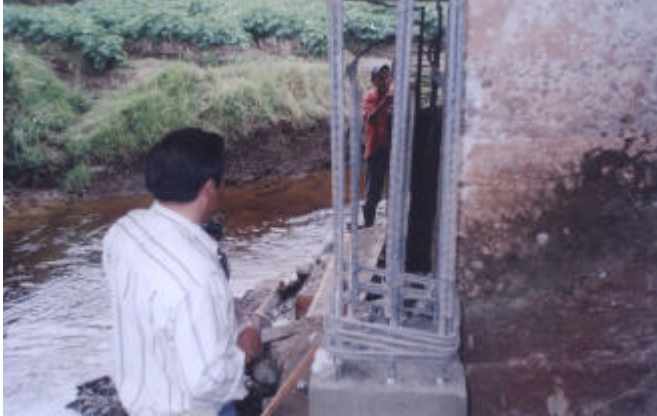
Figura 99. Estado final de zarpa, columnas y viga
