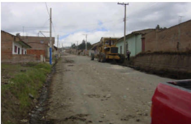
Figura 114. Perfilado de cunetas
