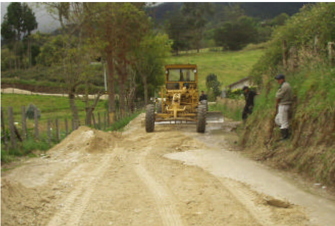
Figura 71. Tendido de material en la vía
