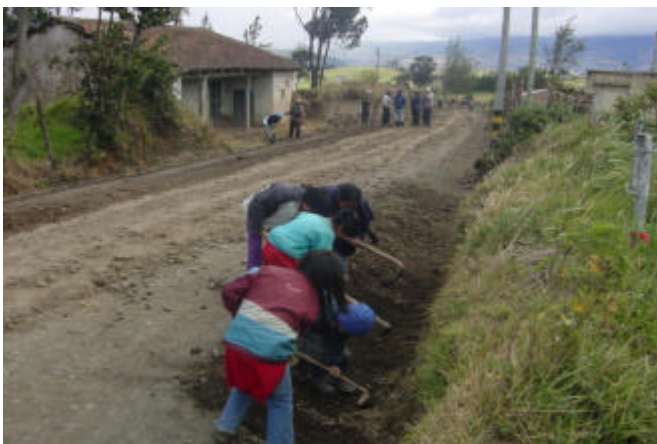
Figura 105. Cuneteo por parte de la comunidad
