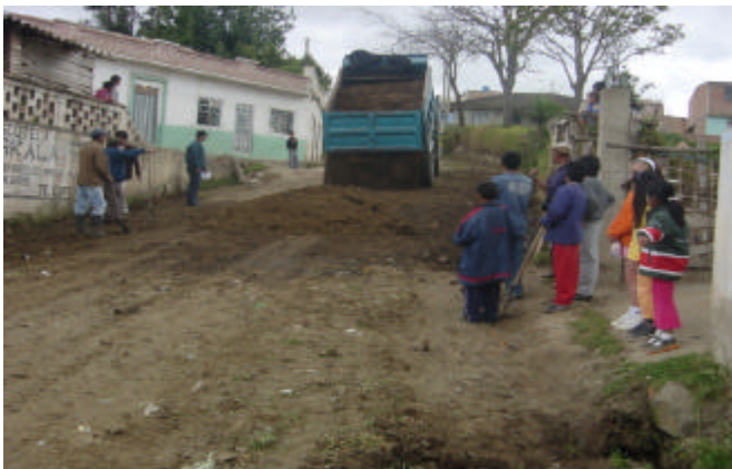
Figura 109. Riego de material en la vía
