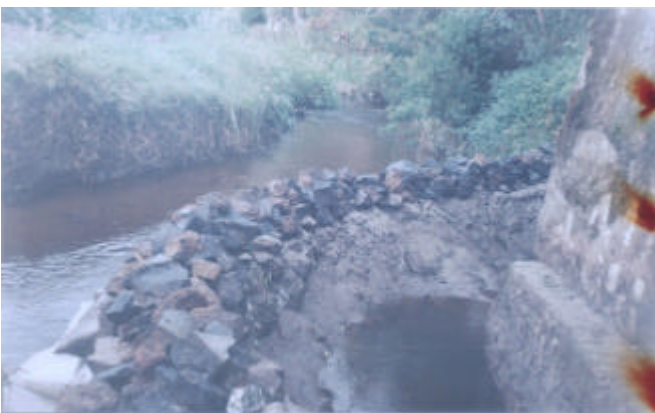
Figura 97. Construcción muro de gaviones
