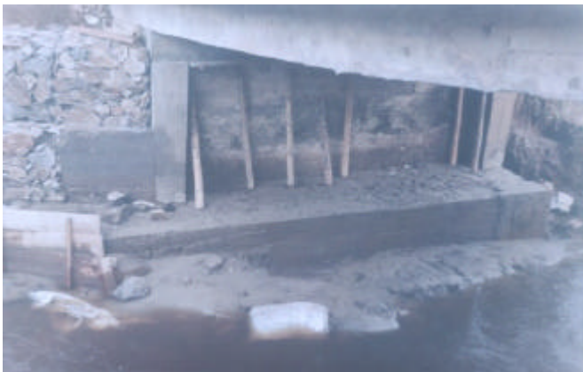
Figura 99. Estado final de zarpa, columnas y viga
