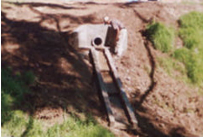
Figura 77. Descole de alcantarilla
