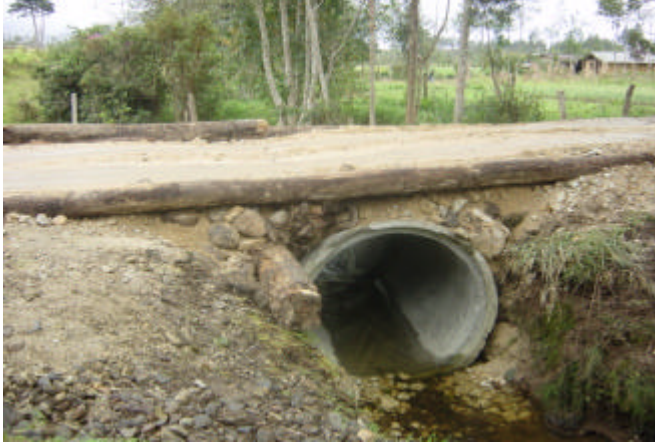
Figura 35. Ponton de madera con tubo de 36 “ vía Mojondinoy.
