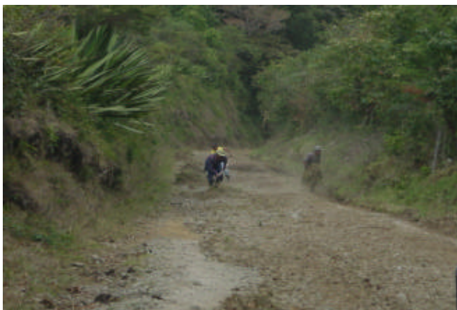
Figura 100. labores de limpieza a cargo de la comunidad del sector
