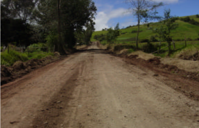
Figura 19. Transporte de recebo para regar en la vía
