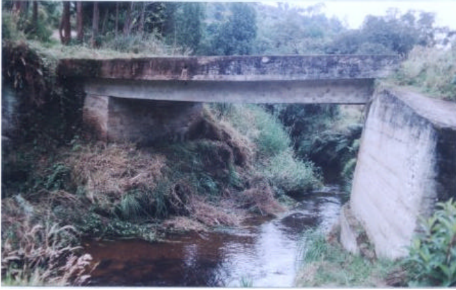
Figura 96. Desvió del cause del río
