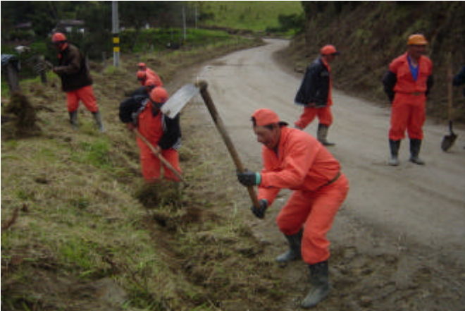
Figura 34. Descole en mal estado falto de limpieza.
