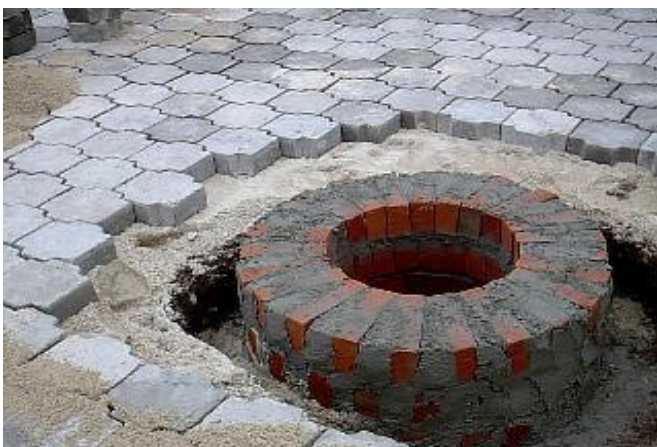
Figura 56 Cámara de inspección de alcantarillado
