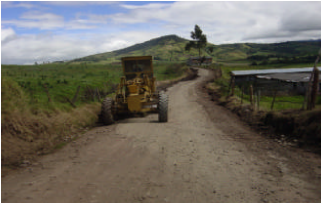
Figura 17. Colaboración de maquinaria de la S.O.P.M. para actividades de perfilado de la vía
