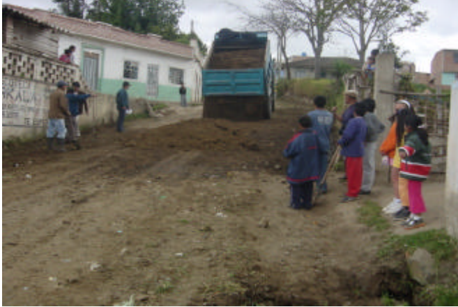
Figura 79. Tendido de material
