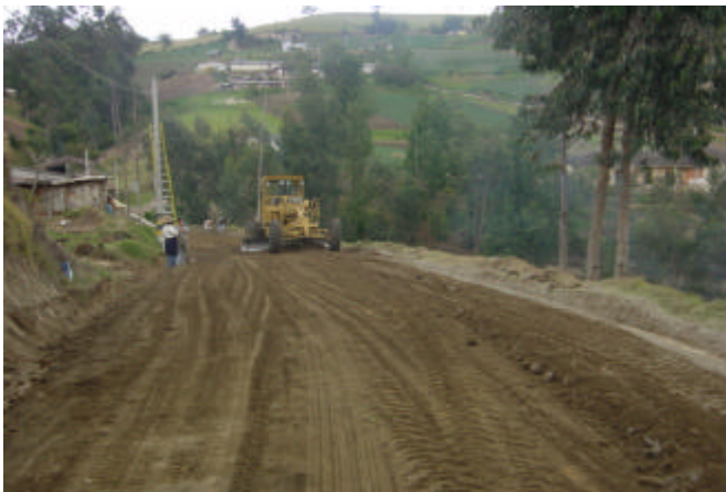
Figura 111. Tendido de material con moto-niveladora
