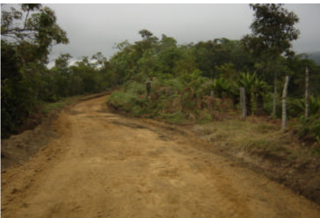
Figura 85. Recebo extendido en la vía
