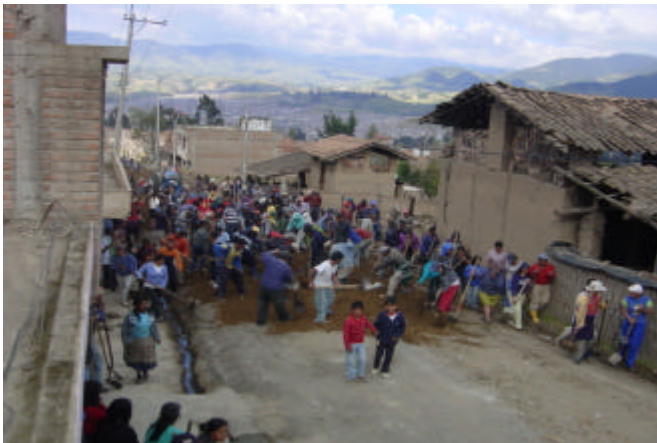
Figura 114. Perfilado de cunetas
