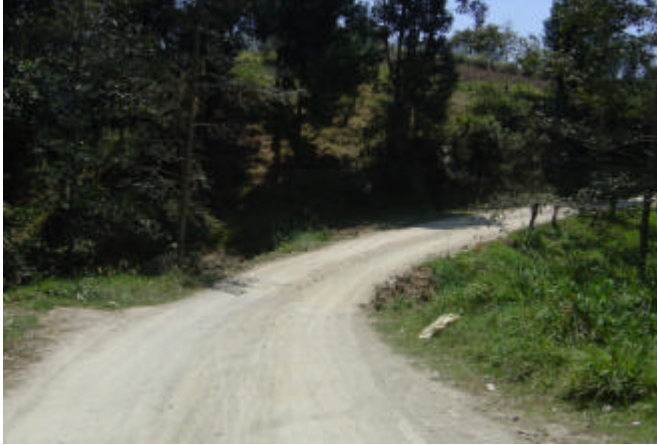
Figura 64. Estado final de la vía
