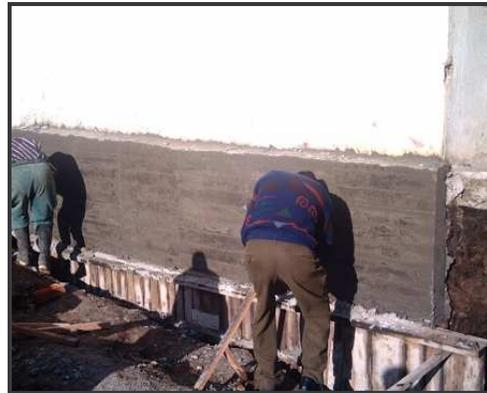
**Figura 91.** Repello de muro
