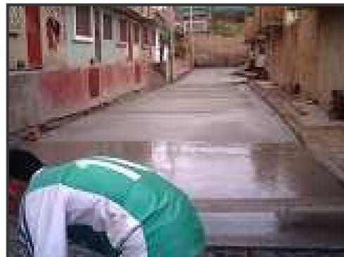
**Figura 56. Acabado de la losa**
