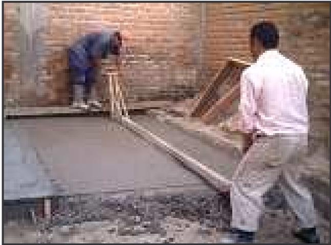
*Con el fin de eliminar las imperfecciones dejadas durante la vibración, se nivela haciendo uso de la llana metálica pesada a la que le sigue una llana liviana, con el fin de eliminar los poros abiertos que hayan quedado (Figura 28).*
