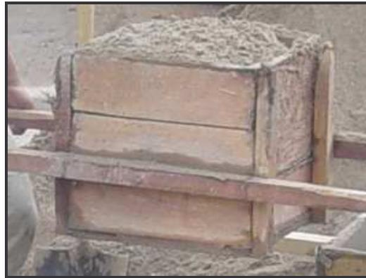
**8.3.1.4 Colocación del Concreto.** Inmediatamente antes de descargar el concreto, la parte superior de la capa de apoyo (base) se riega con agua, en cantidad suficiente para evitar que pueda absorber agua del concreto e induzca a fisuras (ver Figura 25).
