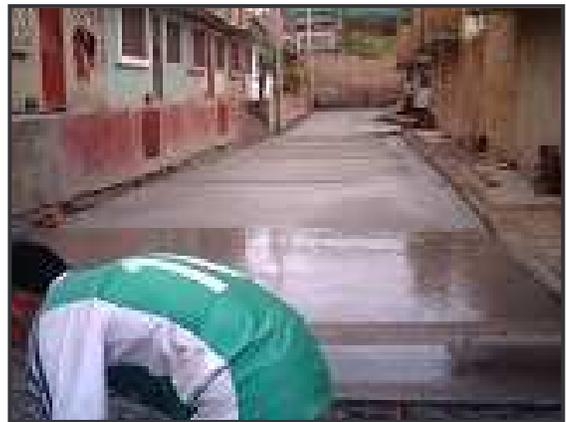
**8.3.1.4.3 Curado del Concreto.** Esta labor se realiza con el fin de evitar fisuras de retracción, y obtener una buena resistencia del concreto, la cual se logra evitando la pérdida de agua de amasado por evaporación debido a la insolación y al viento (*Figura30*).
