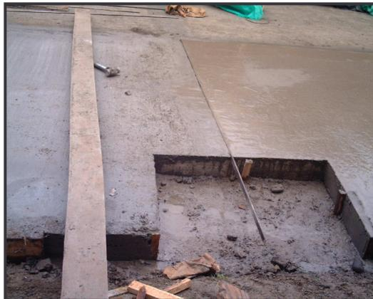
**Figura 32. Elaboración de juntas sobre concreto semi – endurecido, usando cortadora de disco de diamante**
