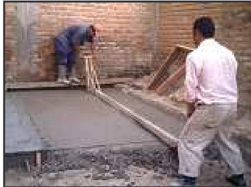
*Con el fin de eliminar las imperfecciones dejadas durante la vibración, se nivela haciendo uso de la llana metálica pesada a la que le sigue una llana liviana, con el fin de eliminar los poros abiertos que hayan quedado (Figura 52).*
