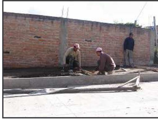
**Figura 71.** Vibración en andenes
