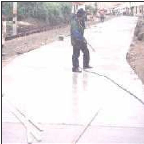
**8.3.1.4.4 Elaboración o Aserrado de Juntas.** La elaboración de juntas se puede llevar a cabo de dos maneras: La primera, estando el concreto fresco (estado plástico), y la segunda estando semi-endurecido.
