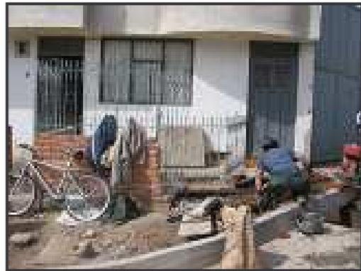
**Figura 85.** Construcción cerramiento en ladrillo visto
