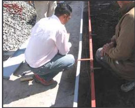
**Figura 61.** Bordillos en curva con tablilla (material mas flexible)
