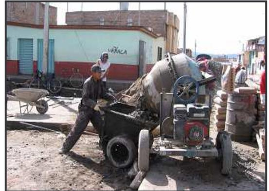
La colocación de los materiales en la mezcladora, se hace en el siguiente orden primero se introduce el agua, seguido del cemento, luego en forma intercalada, el triturado y la arena, siempre con la mezcladora en movimiento. El tiempo que permanece girando la máquina o sea el tiempo de mezcla, esta entre dos o tres minutos.
