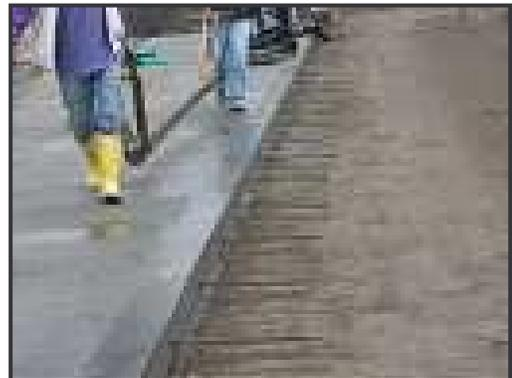
**Figura 51.** Instalación de pasadores de transferencia de carga en las juntas transversales – acero liso.
