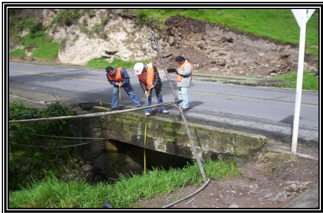
Figura 19. Inspección del Pontón localizado en el PR 22 + 0160
