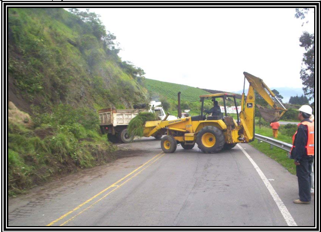
Figura 24. Despeje de derrumbe en el PR 75+0310
