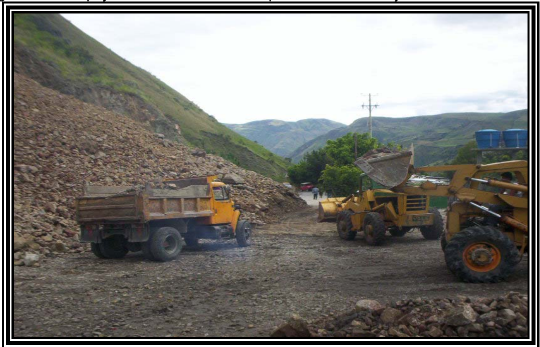
Figura 31. Despeje de derrumbe con maquinaria en El Borojó
