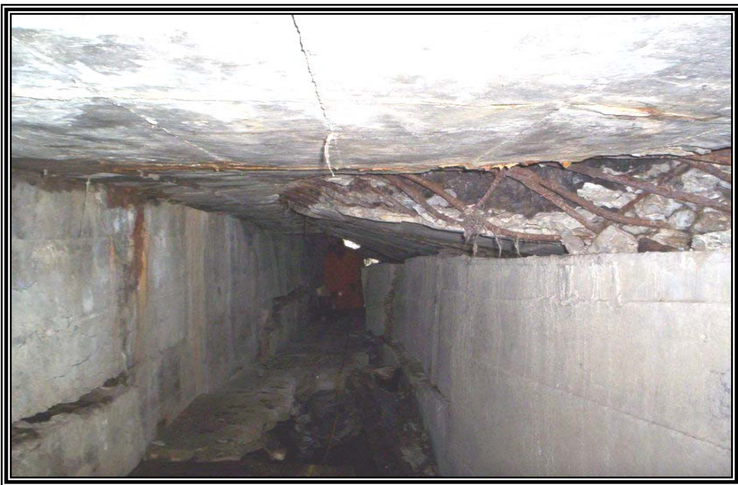
Figura 20. Box – culverts localizado en el PR 2+0540
