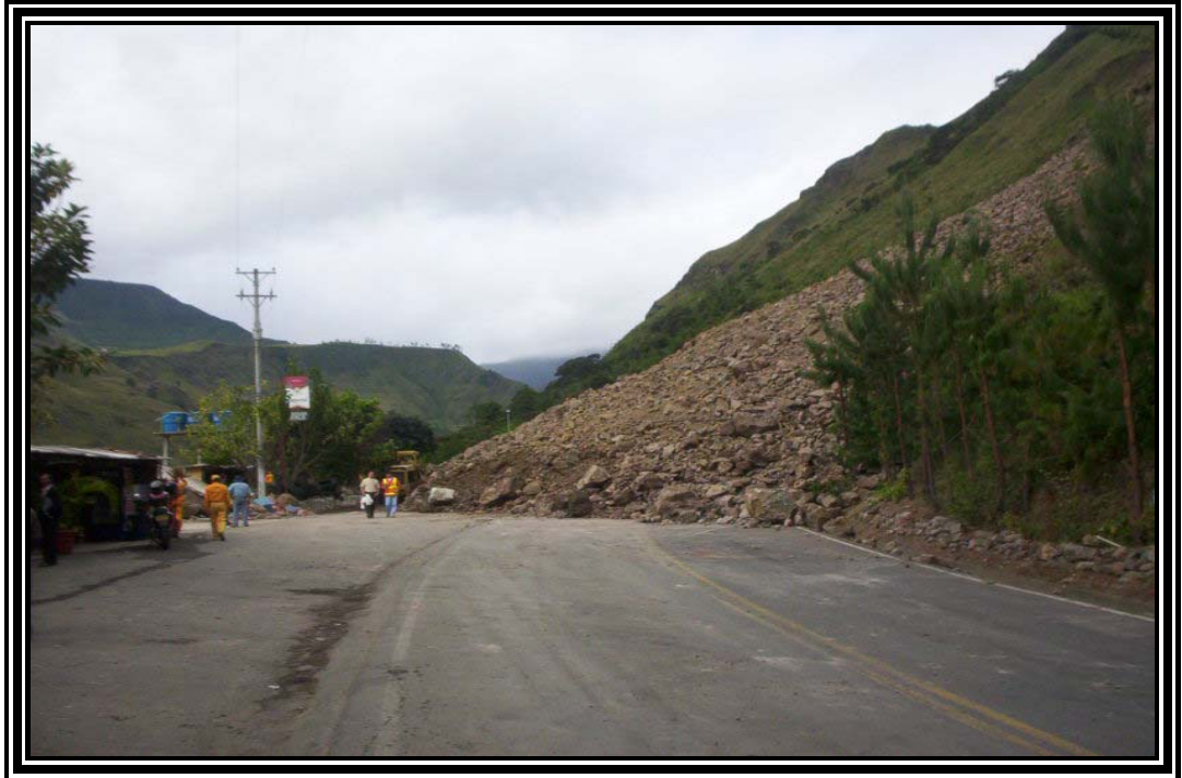
Figura 30. Restricción total de la vía en El Borojó
