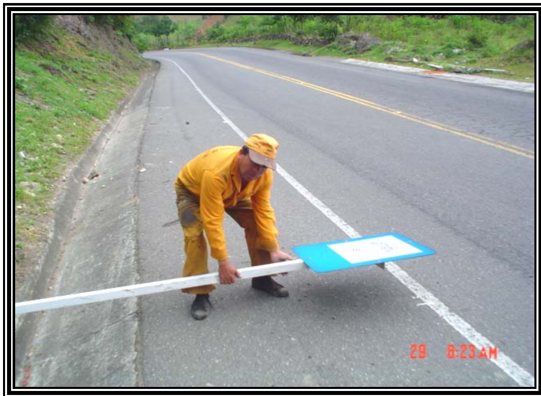
Figura 27. Arreglo de señal caída
