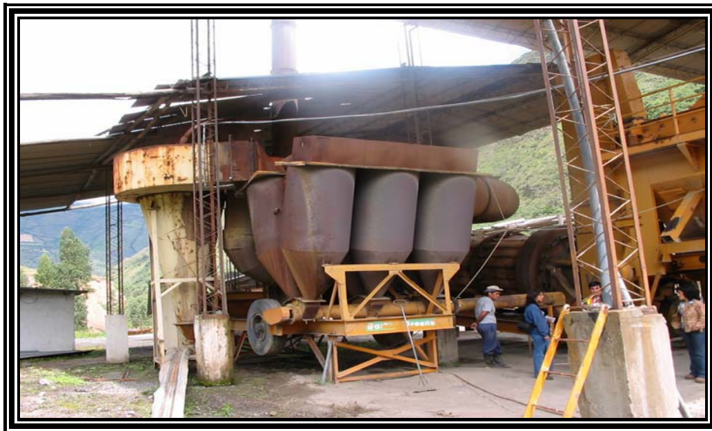
Figura 18. Planta de asfalto de Pilcuán
