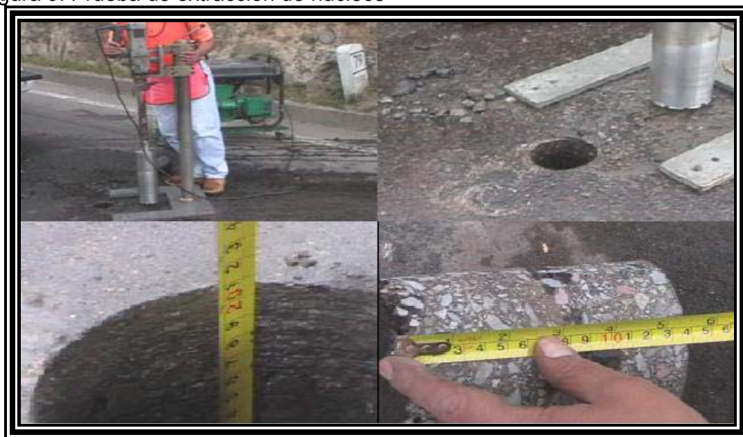
Figura 9. Prueba de extracción de núcleos
