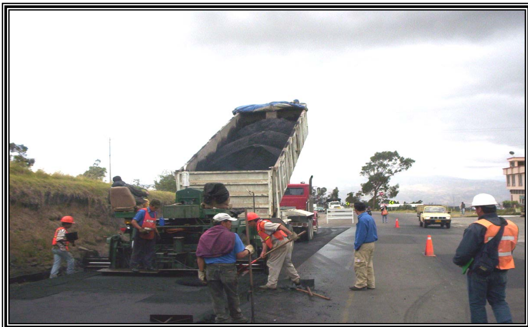
Figura 44. Colocación de la mezcla densa en caliente MDC-2 con Finisher, maquina que tiene la propiedad de extender el material de una manera uniforme.
