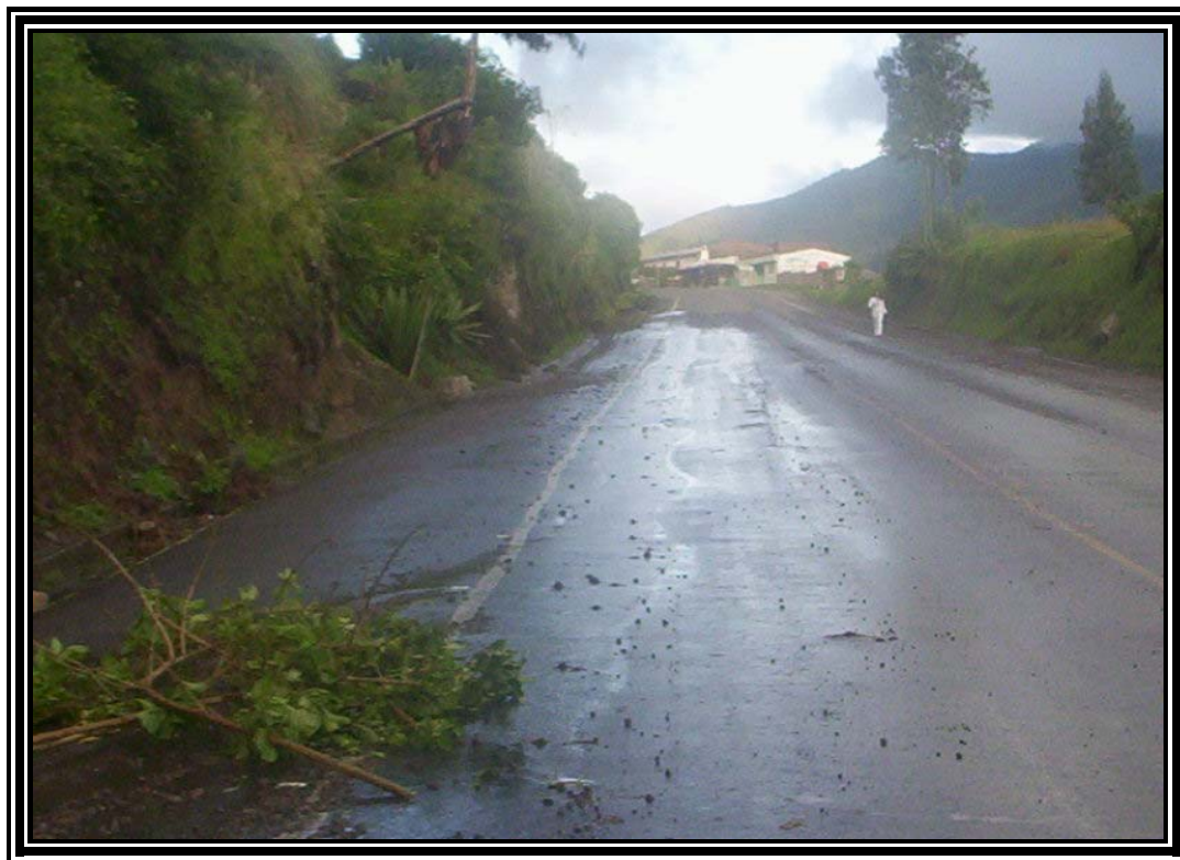
Figura 29. Despeje de derrumbe en el PR59+0800
