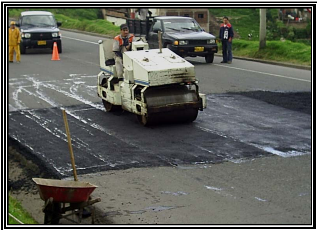
Figura 32. Compactación de la vía en el PR 2+0500
