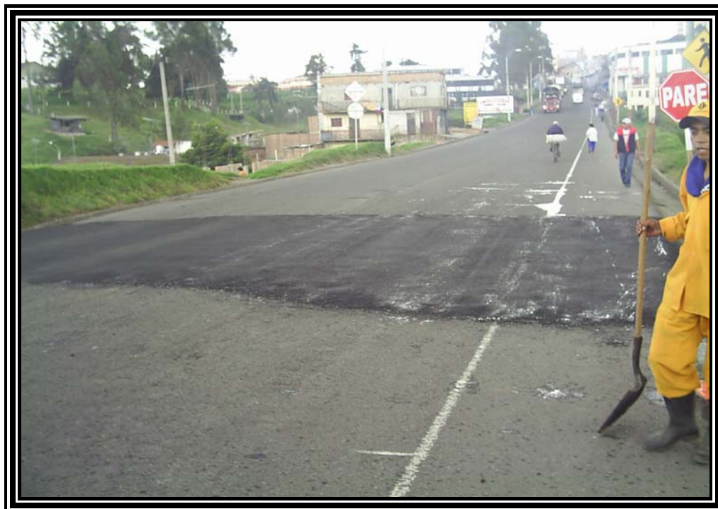
Figura 33. Tramo de la vía terminada
