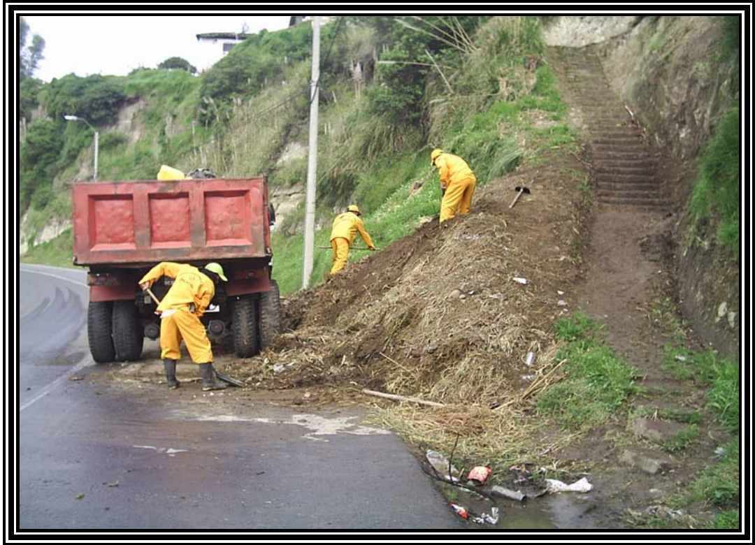
Figura 28. Despeje de derrumbe en el PR43+0700
