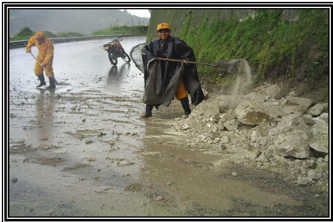
Figura 26. Limpieza de calzada y bermas
