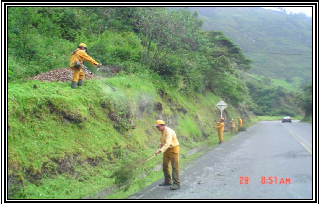
Figura 25. Rocería y desmonte manual
