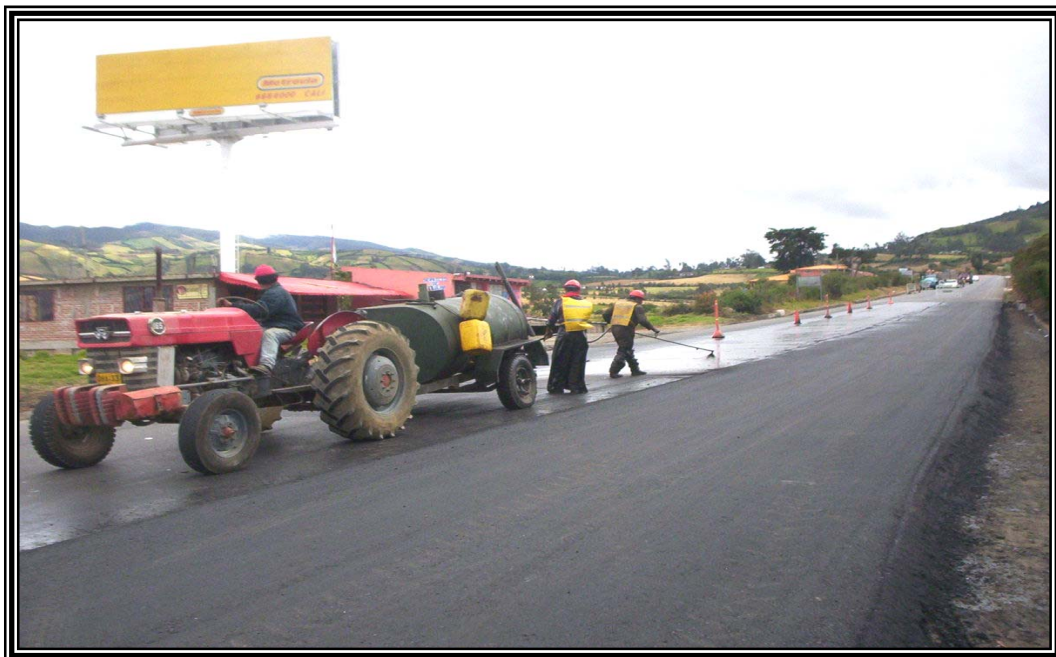
Figura 43. Riego de emulsión asfáltica con carro tanque irrigador
