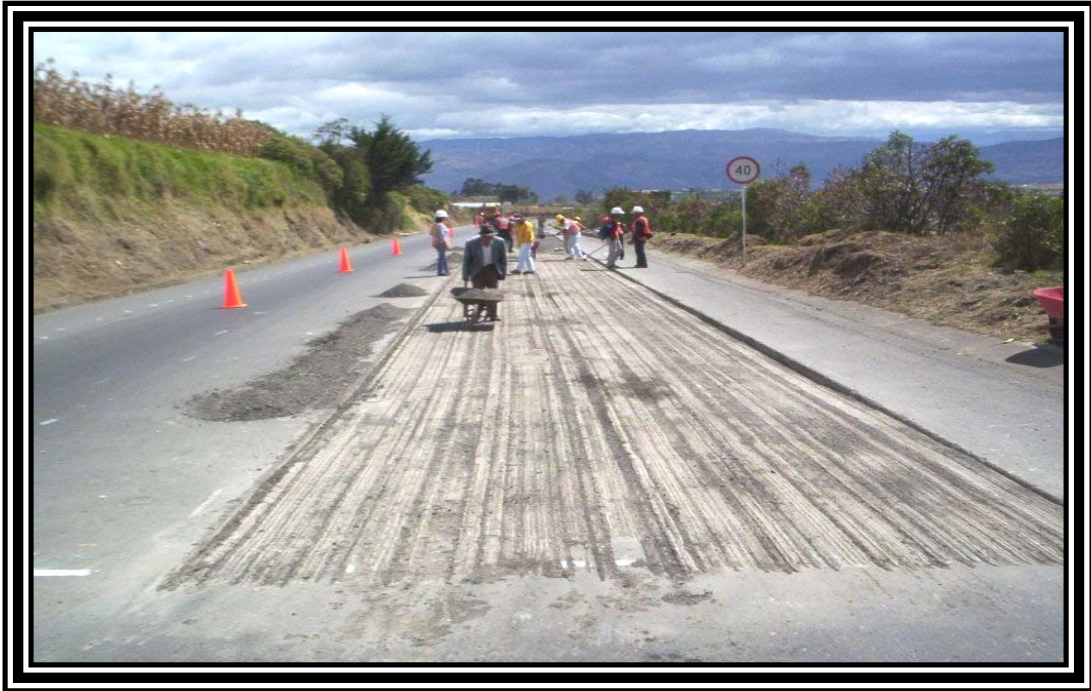
Figura 40. Retiro del material sobrante fresado
