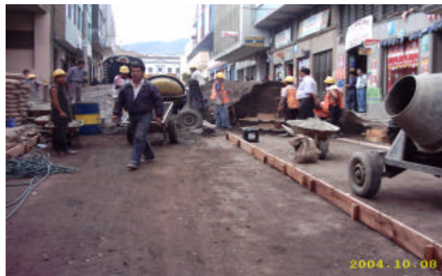
Figura 47. Extendido mezcla vibración mecánica
