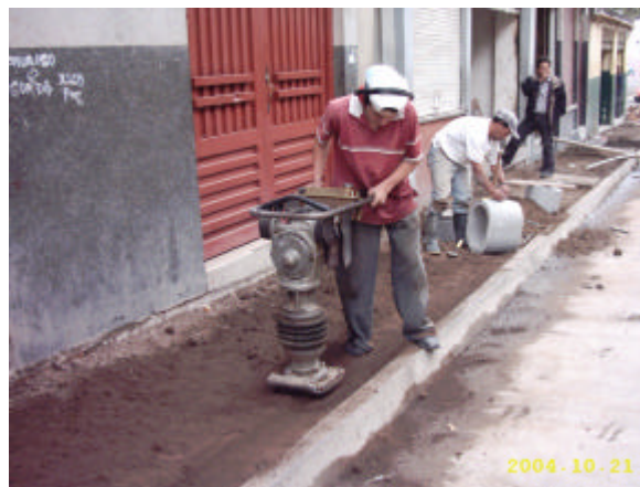
Figura 51. Conformación base en recebo andenes
