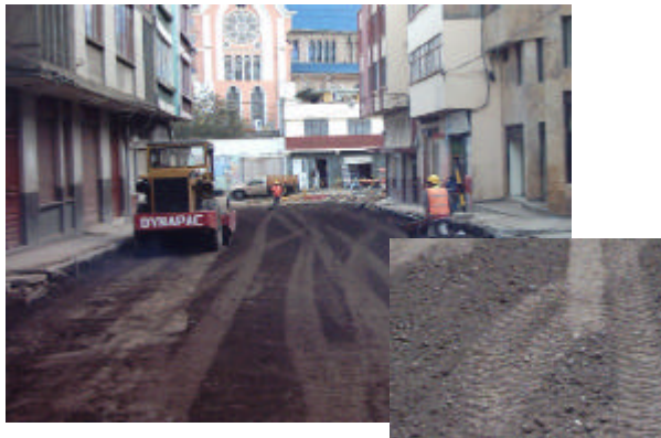
Figura 44. Conformación base granular
