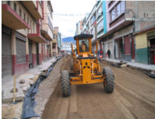
Figura 44. Conformación base granular
