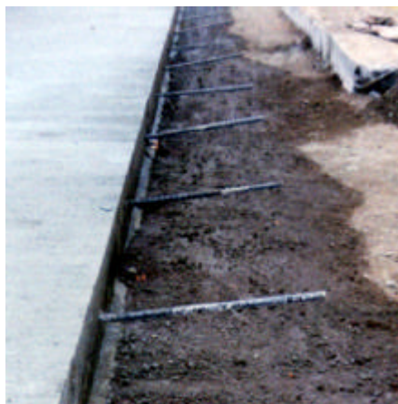
Figura 9. Refuerzo longitudinal varillas corrugadas 1/2" L= 0.8m @ 0.8m.
