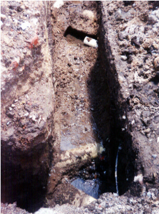
Figura 33. Nivel freático sobre el nivel de tuberías.
