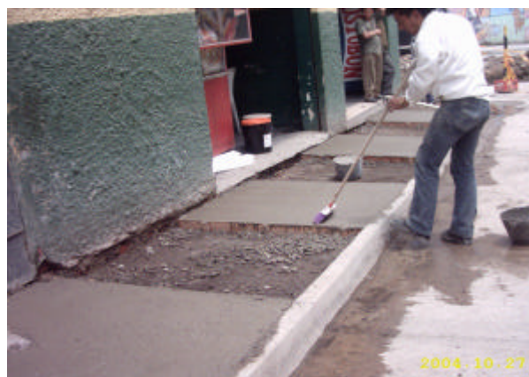
Figura 52. Acabado final del concreto, andenes.
