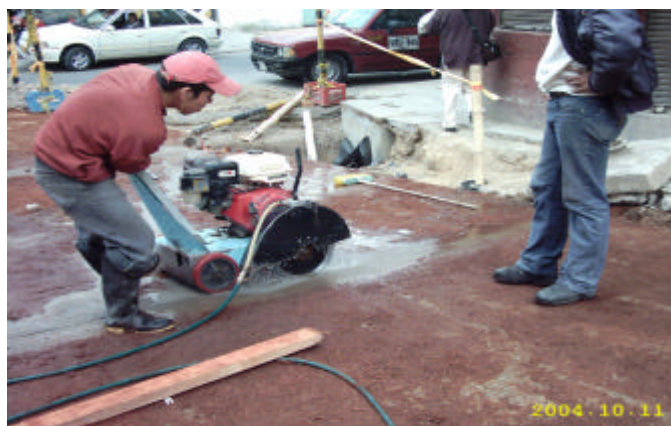
Figura 50. Corte de junta de dilatación, disco E = 8 mm, PROF = 45mm.
