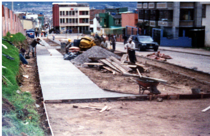
Figura 58. Concreto para andenes, 2500psi.
