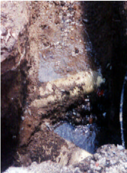
Figura 33. Nivel freático sobre el nivel de tuberías.
