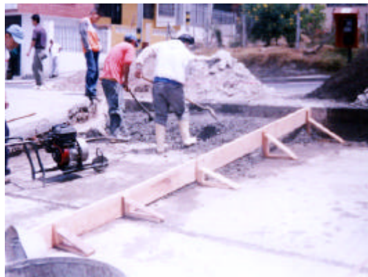
Figura 24. Fase uno realce cámara
