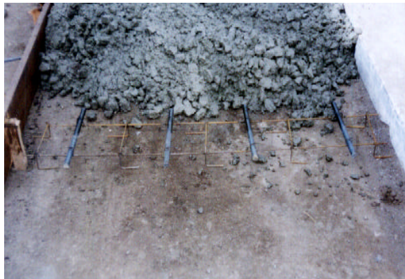
Figura 9. Refuerzo longitudinal varillas corrugadas 1/2" L= 0.8m @ 0.8m.
