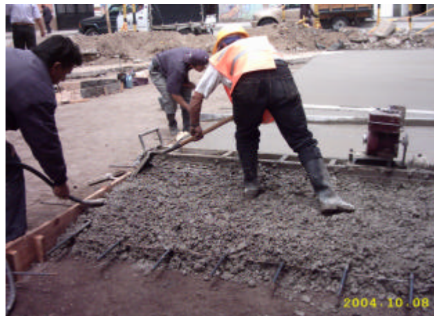
Figura 47. Extendido mezcla vibración mecánica
