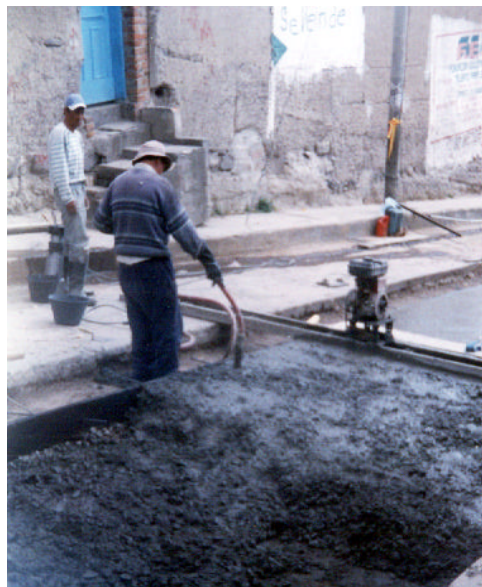
Figura 20. Vibración de mezcla regla vibratoria y vibrador eléctrico
