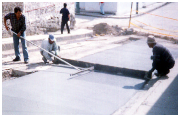
Figura 22. Cepillado del concreto
