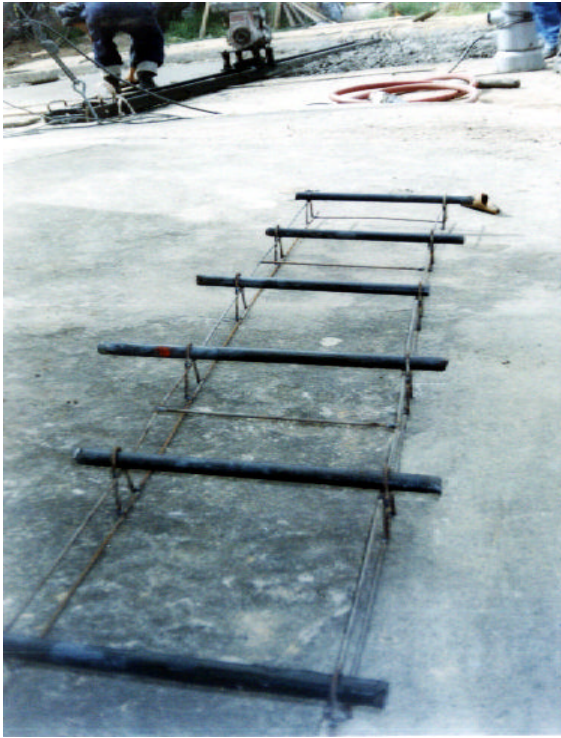
Figura 14. Refuerzo longitudinal varilla corrugada ½" L = 0.80m @ .80m
