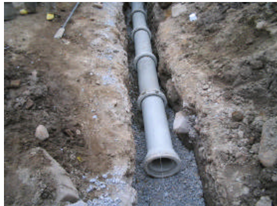
Figura 54. Tubería sumidero, concreto d = 10
