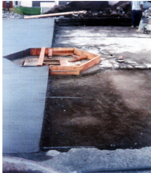
Figura 24. Fase uno realce cámara
