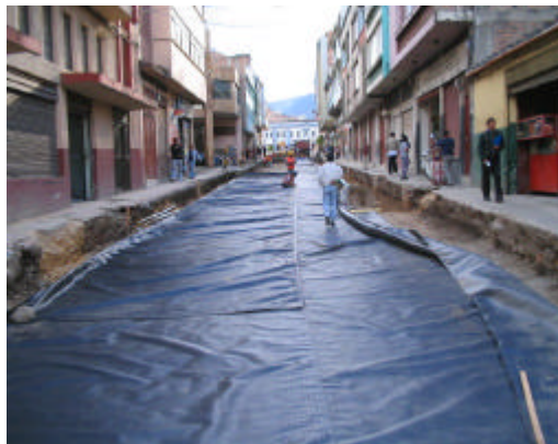
Figura 42. Mejoramiento subrasante con geotextil
