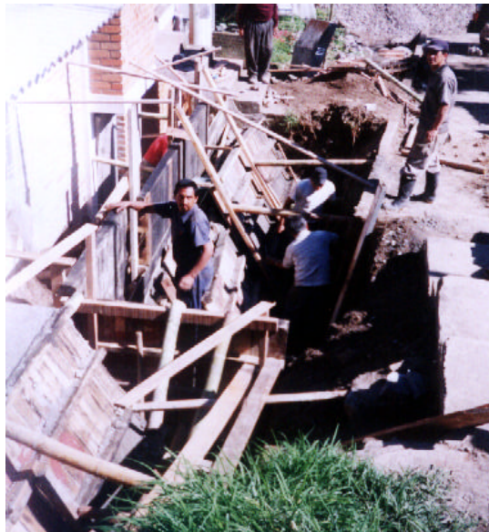
Figura 61. Muro de contención. L=13.30 m.
