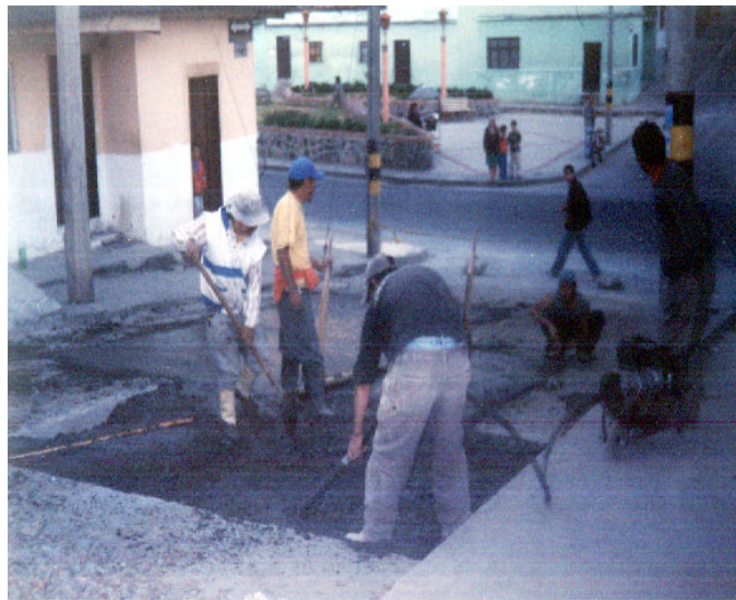
Figura 28. Fase dos formación placa, vibrador mecánico
