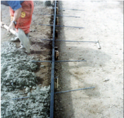
Figura 14. Refuerzo longitudinal varilla corrugada ½" L = 0.80m @ .80m
