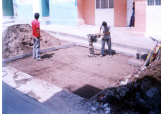
Figura 26. Fase tres base, compactación con saltarín
