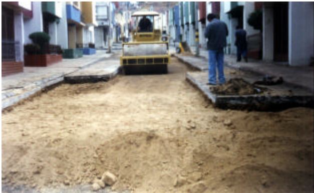
Figura 3. Compactación mecánica sub base
