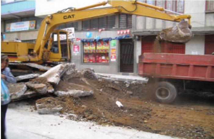
Figura 40. Perfilado subrasante
