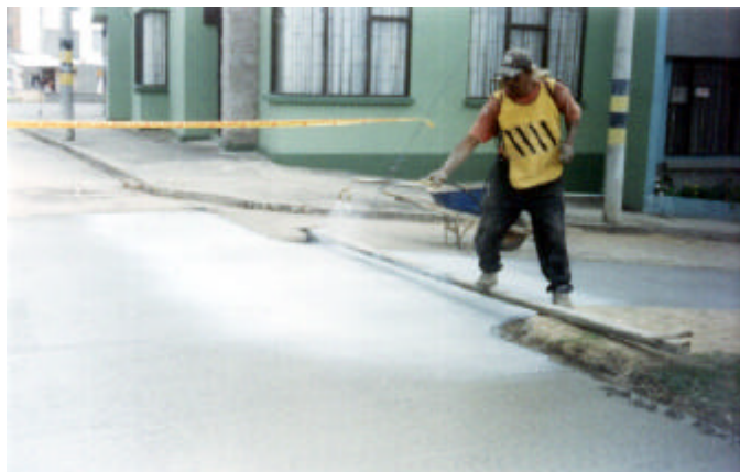
Figura 16. Curado de concreto con antisol
