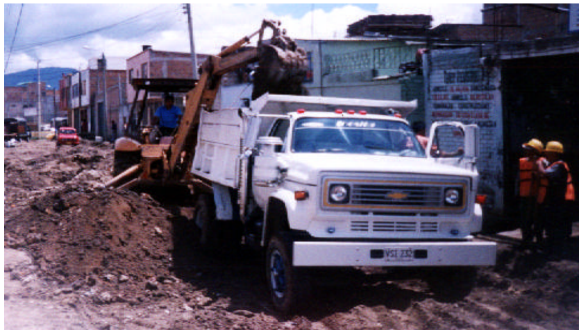
Figura 36. Evacuación de escombros, con retroexcavadora.
