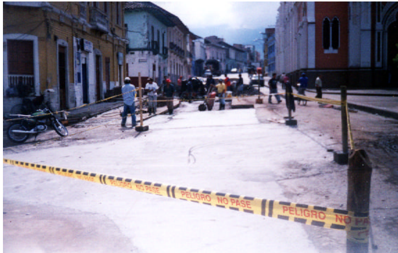
Figura 68. Placa con acelerante 7 días, curado con agua.
