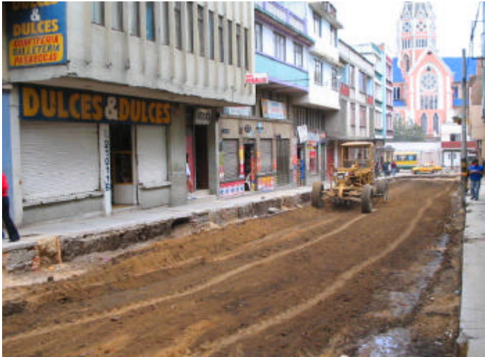
Figura 40. Perfilado subrasante
