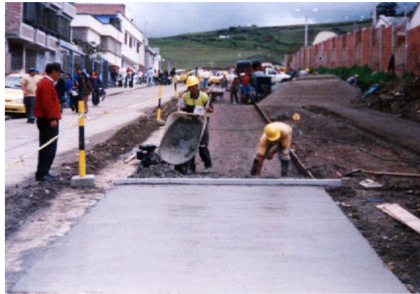
Figura 58. Concreto para andenes, 2500psi.
