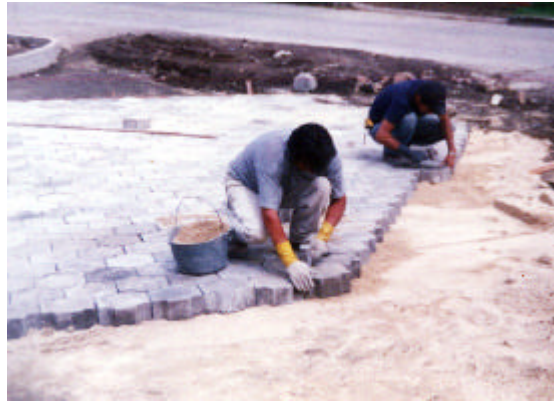
Figura 63. Proceso de escobrado
