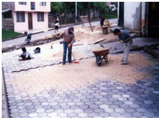
Figura 63. Proceso de escobrado
