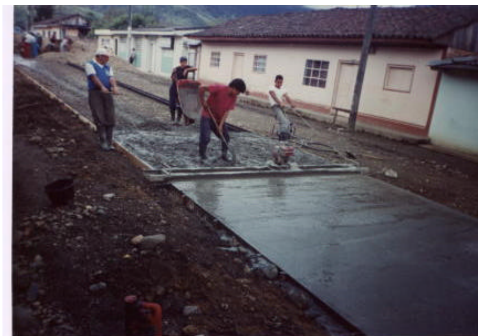
Figura 7. Vibrado del concreto
