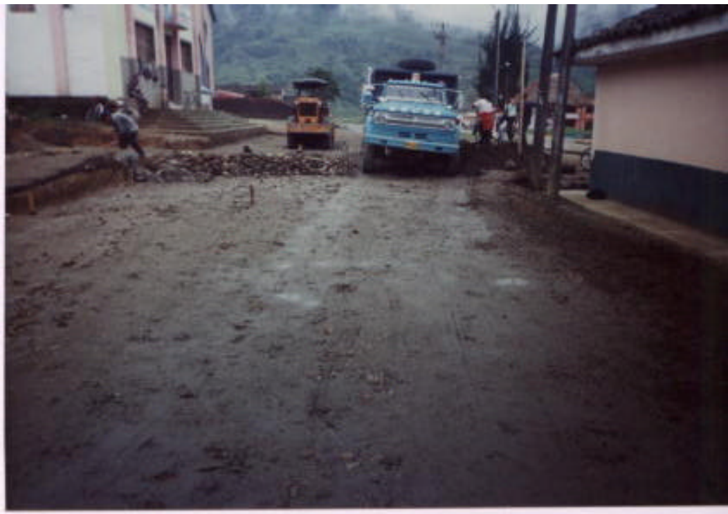
Figura 2. Maquinaria de trabajo para compactación de subrasante y subbase
