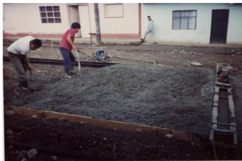
Figura 7. Vibrado del concreto
