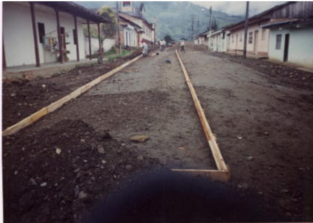
Figura 3. Colocación de formaletas
