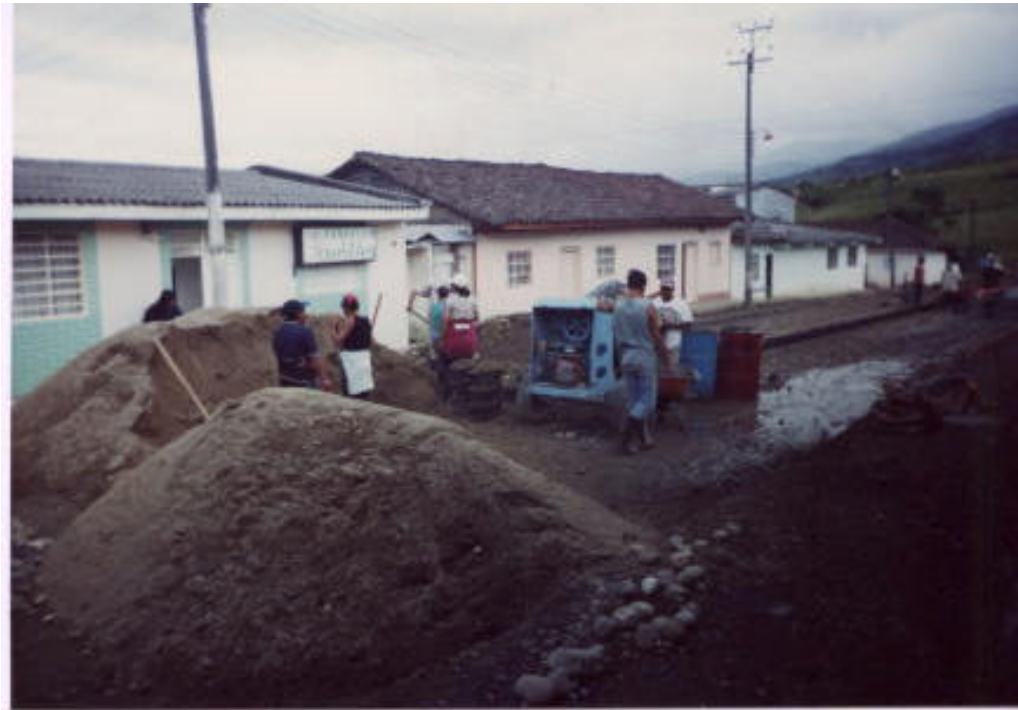
Figura 5. Acopio y dosificación de materiales
