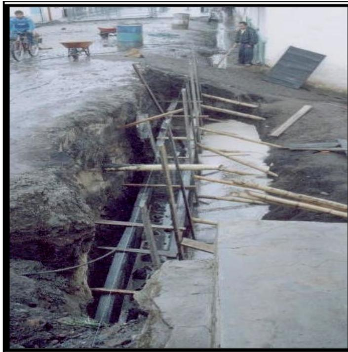
**Figura 7: Armado de formaleta para muro**
