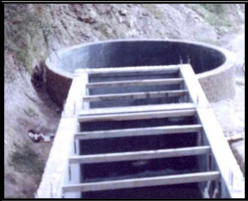
**Figura 33: Pozo séptico pantalla**
