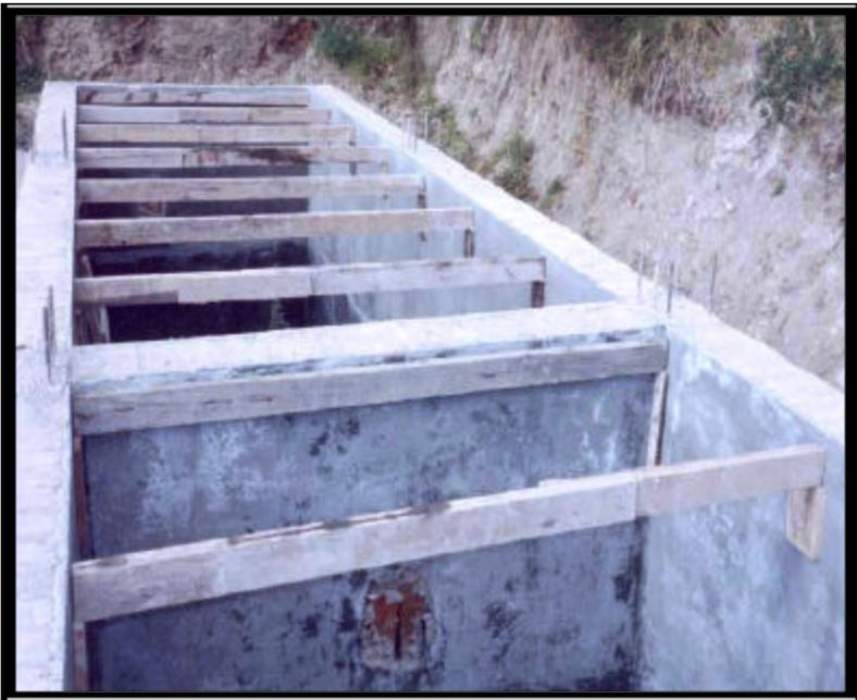
**Figura 34: Pozo séptico terminado**
