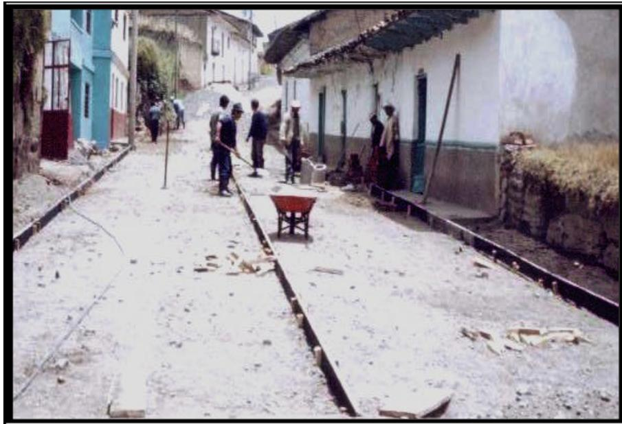
**Figura 16: Fundición de pavimento**
