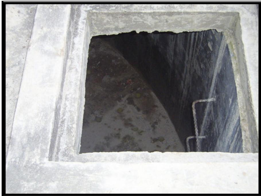
**Figura 38: Desagües pozo séptico**
