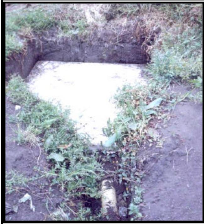
**Figura 29: Campo de infiltración**
