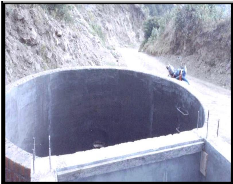
**Figura 36: Filtro granular terminado**
