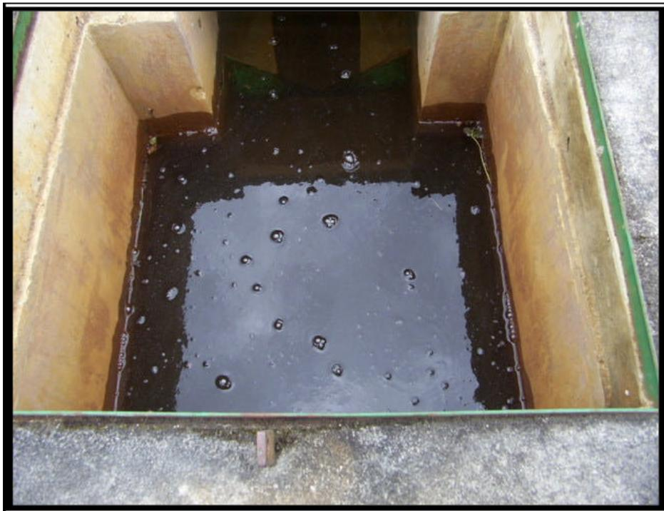
Figura 47: Cámara de distribución de caudales
