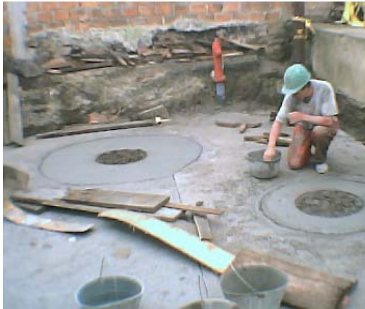
Foto 26. Terminado de cámaras
