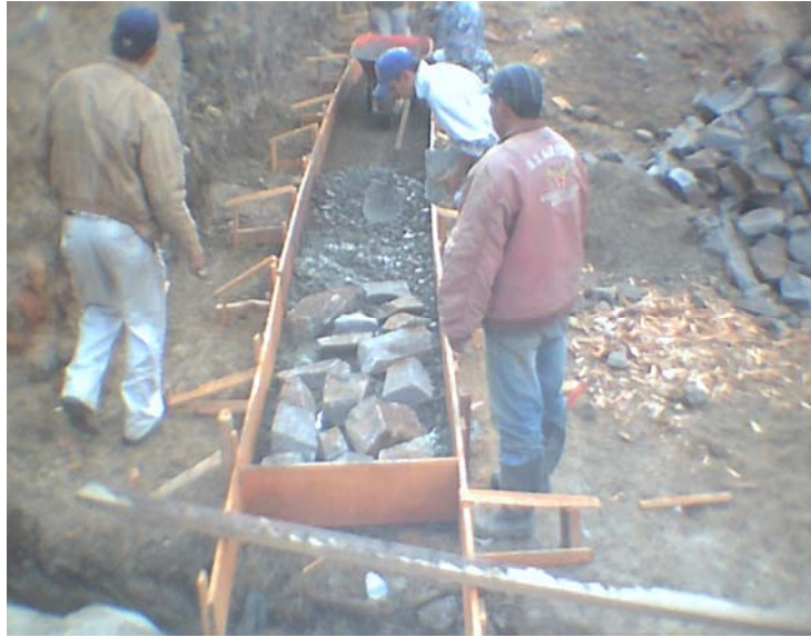
Foto 55. Encofrado base del muro (Zarpa)
