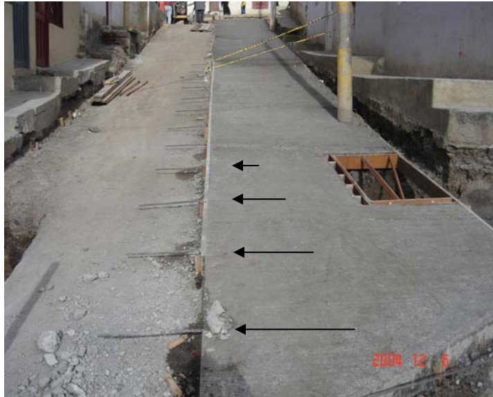
Foto 20. Distribución refuerzo longitudinal
