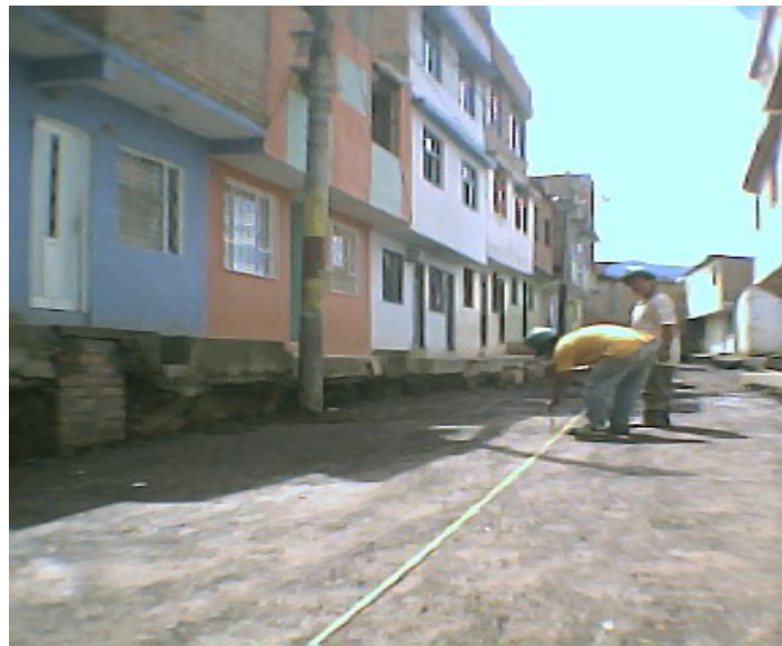
Foto 13. Localización de ejes para el pavimento
