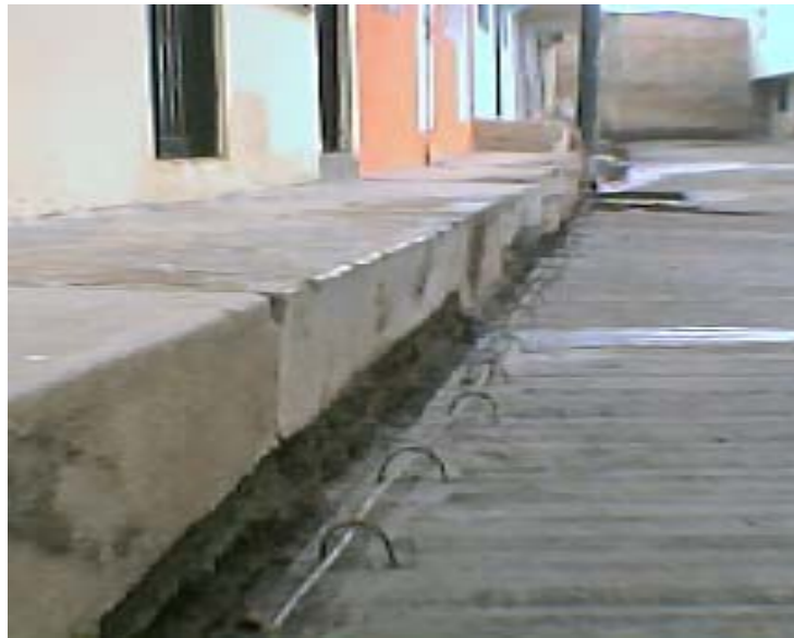
Foto 23. Refuerzo longitudinal y transversal en sardinel
