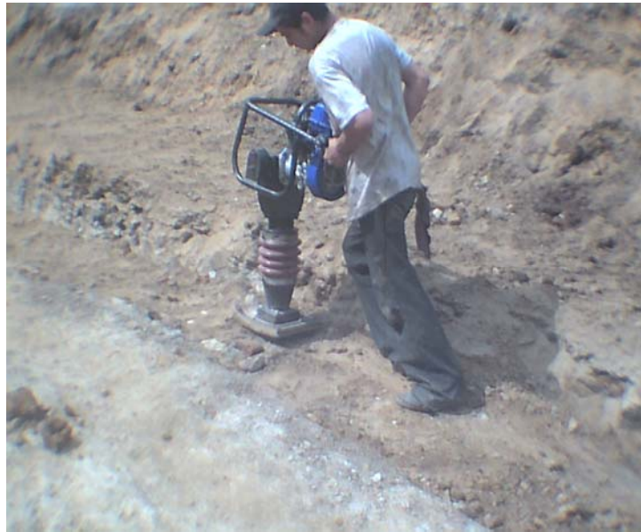
Foto 53. Compactación de impacto sobre tubería
