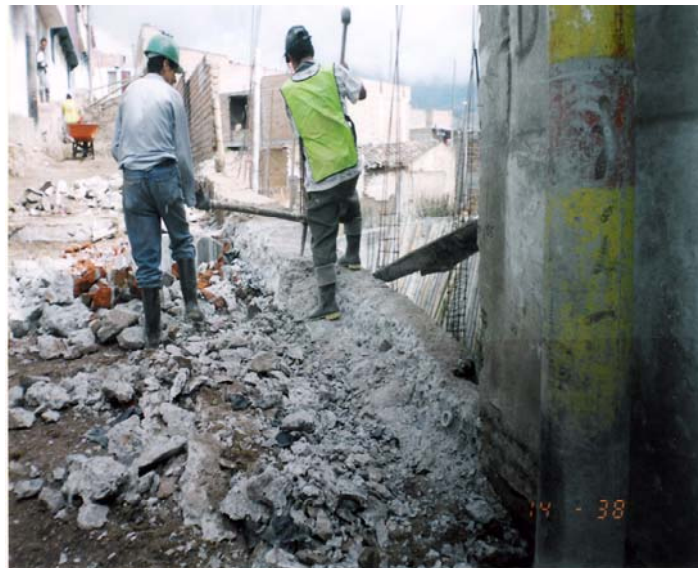
Foto 5. Demolición concreto rígido
