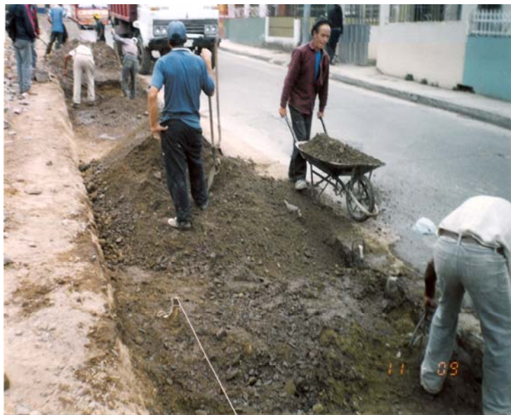
Foto 34. Nivelación y esparcido de Base
