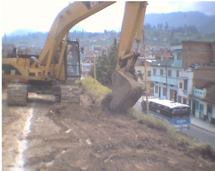
Foto 56. Descapote a máquina
