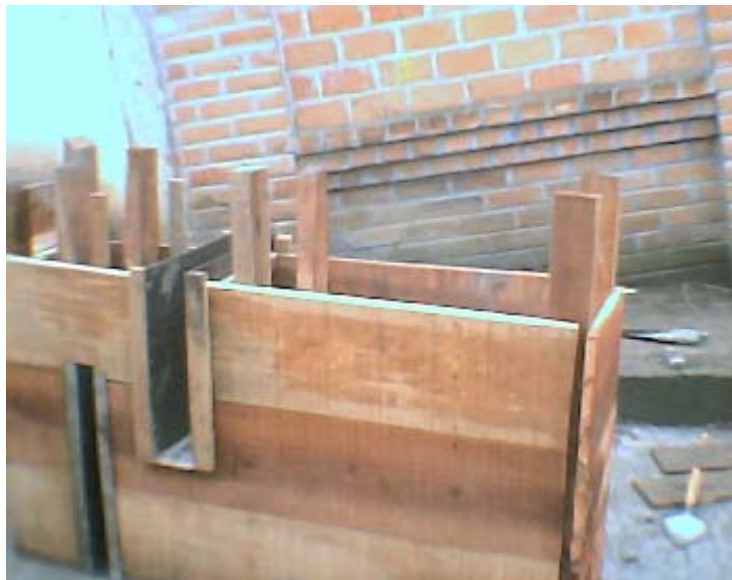
Foto 27. Encofrado sumidero de calzada
