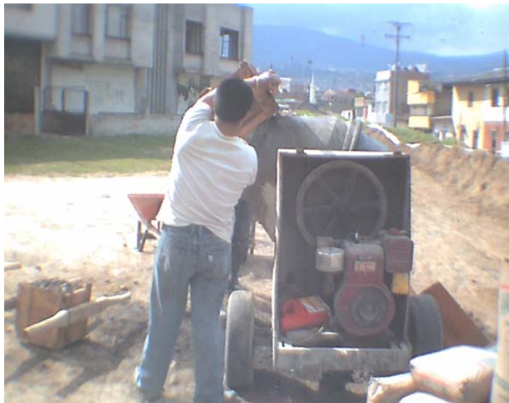
Foto 54. Dosificación para concreto
