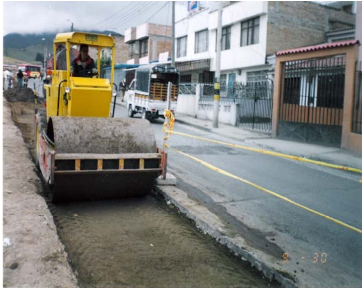
Foto 33. Vibrocompactación subbase
