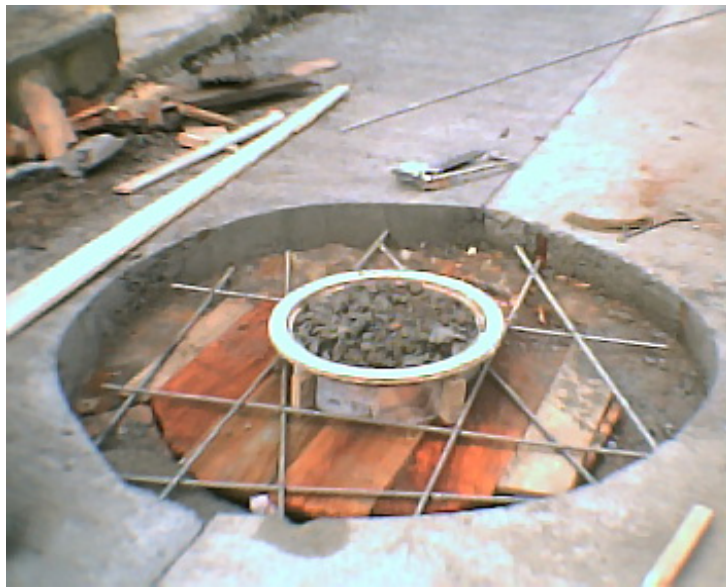
Foto 25. Refuerzo para cámara
