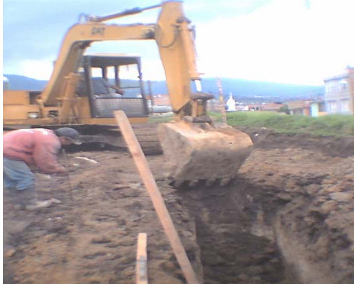
Foto 51. Excavación para alcantarillado pluvial
