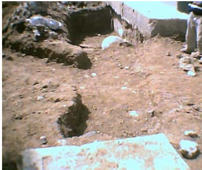
Foto 7. Conexión tubería para sumideros
