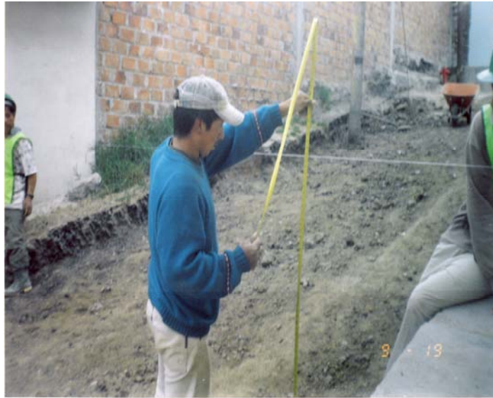
Foto 4. Medición de profundidades excavadas
