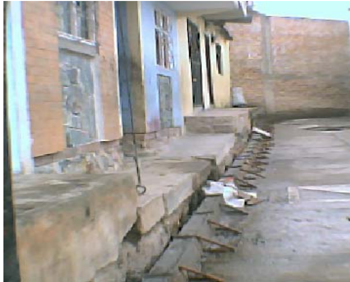
Foto 24. Encofrado y fundición de sardinel
