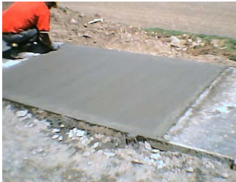
Foto 42. Acolillado de andén
