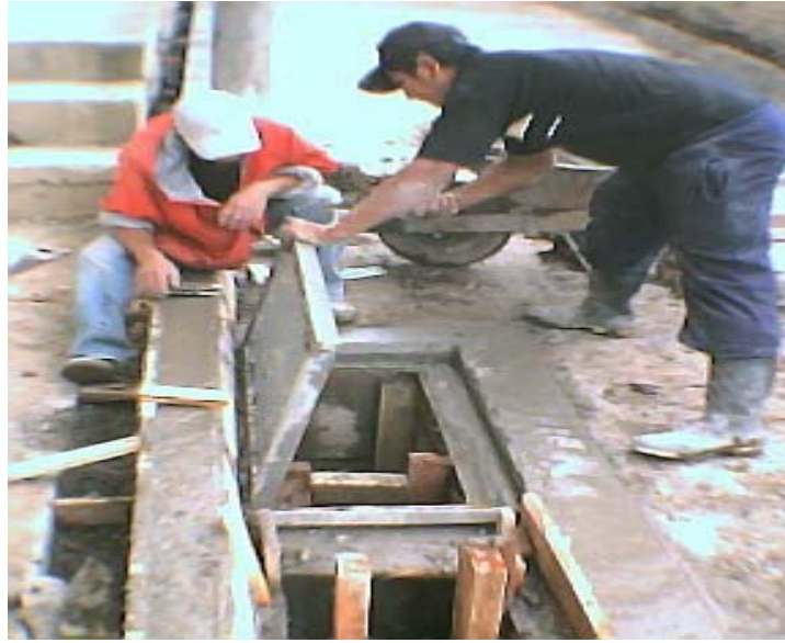
Foto 28. Fundición sumidero de calzada
