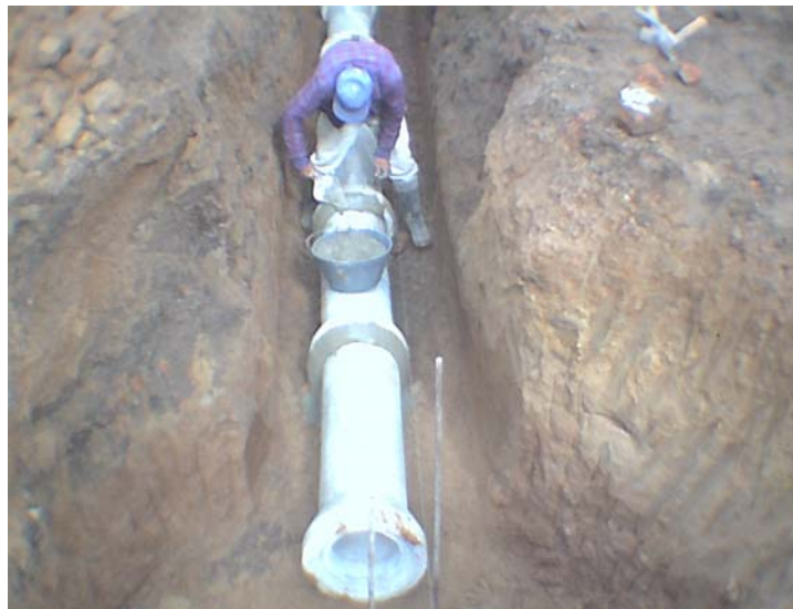
Foto 52. Instalación tubería pluvial
