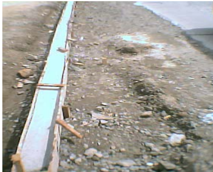
Foto 36. Encofrado sardinel de confinamiento
