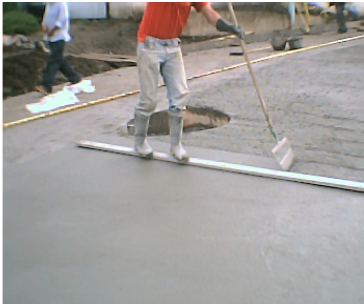
Foto 21. Escobeado del pavimento
