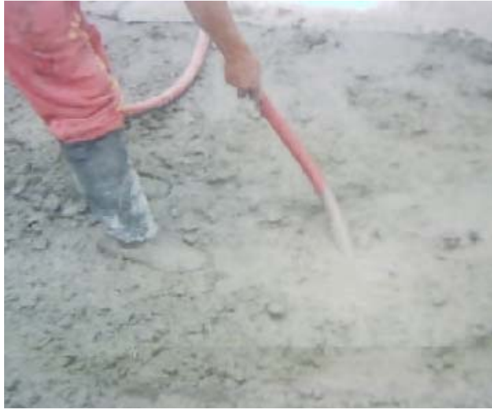
Foto 18. Vibrado del concreto
