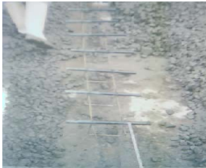
Foto 17. Distribución refuerzo transversal
