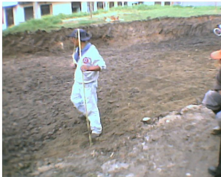
Foto 50. Verificación profundidades excavadas
