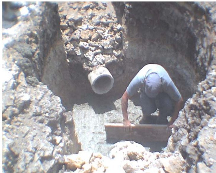
Foto 58. Construcción cámara
