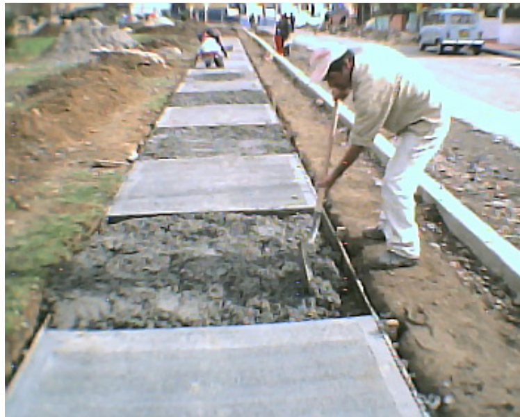
Foto 40. Fundición andén estilo ajedrez
