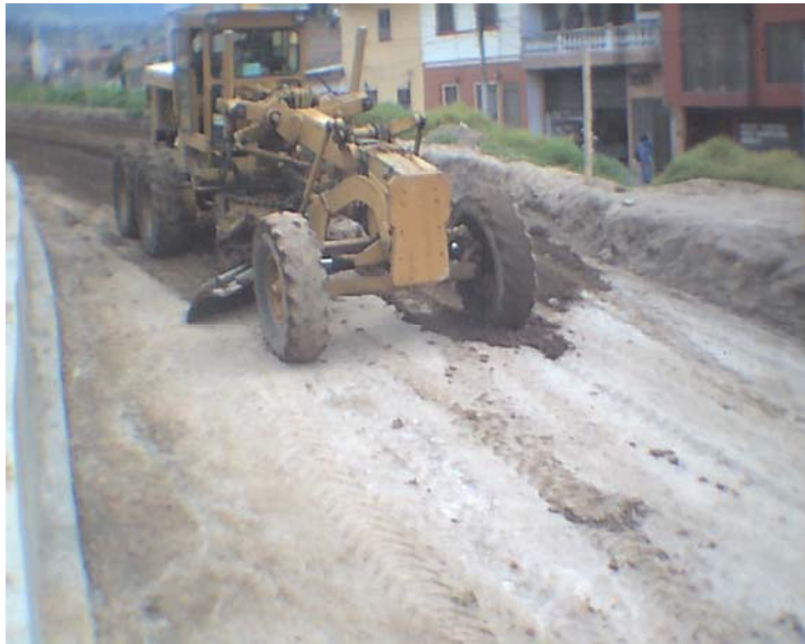
Foto 62. Conformación de Base con motoniveladora
