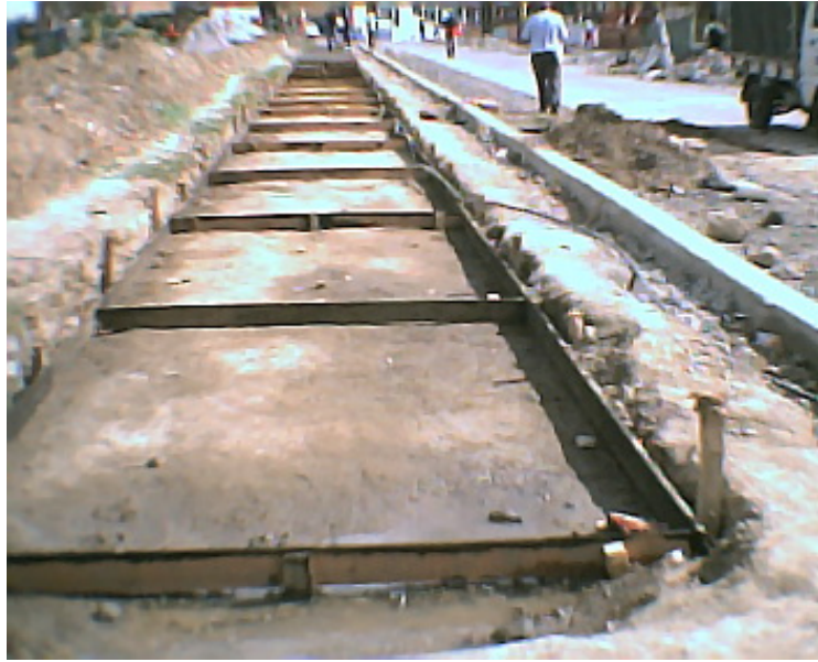
Foto 39. Encofrado de andén
