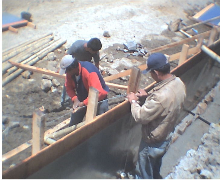
Foto 57. Encofrado cuerpo muro ciclópeo
