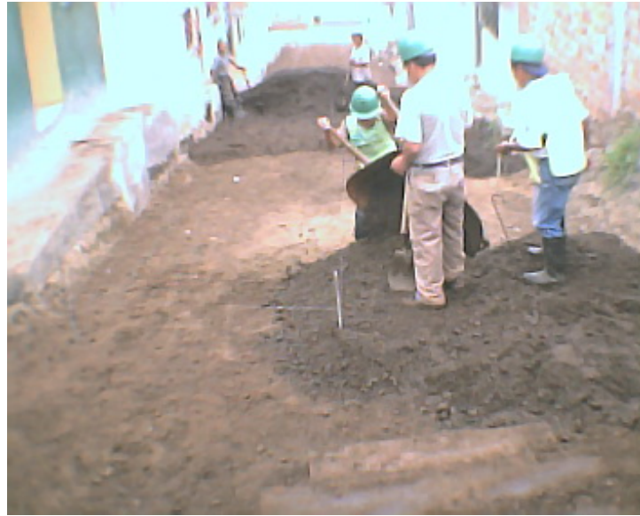
Foto 10. Colocado de base granular
