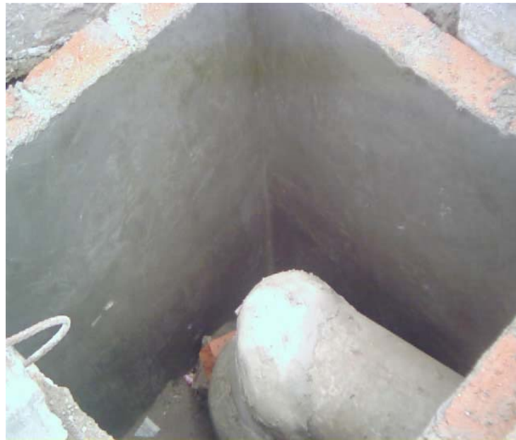
Foto 66. Construcción de sumidero
