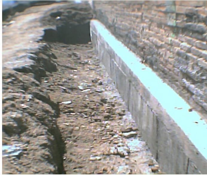
Foto 6. Muro en concreto reforzado
