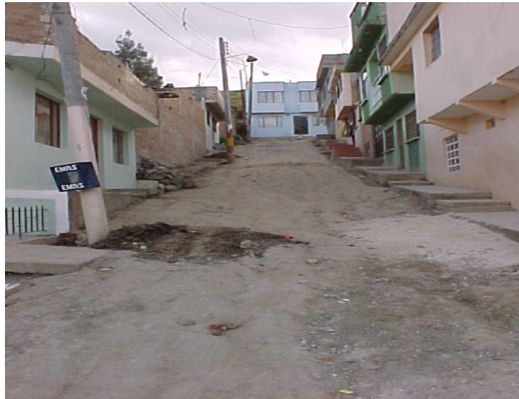
Foto 2. Estado inicial del proyecto
