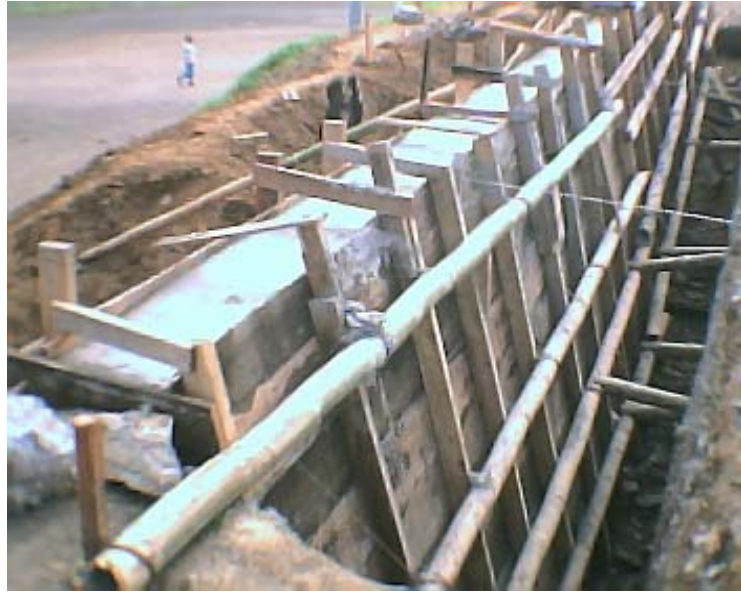
Foto 37. Encofrado y fundición muro ciclópeo
