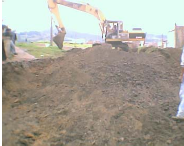
Foto 49. Excavación a máquina material conglomerado
