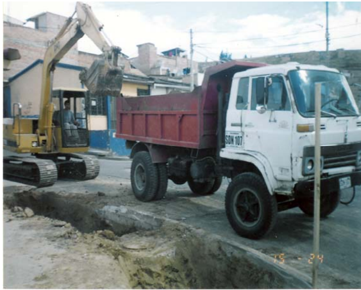
Foto 31. Excavación a máquina material conglomerado
