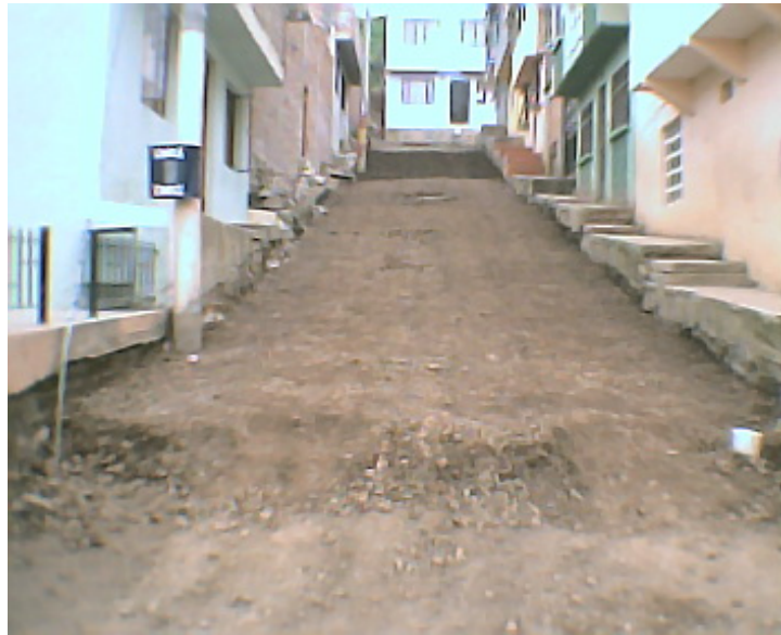
Foto 9. Subbase compactada
