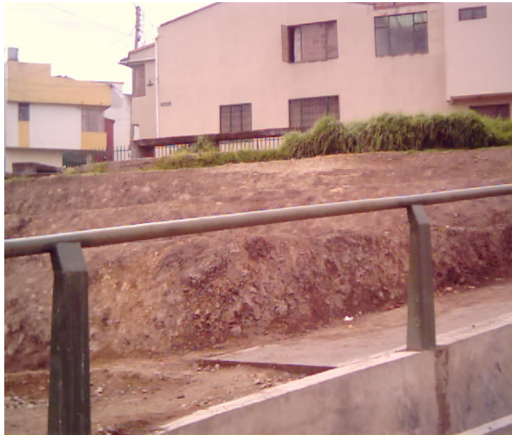
Foto 67. Baranda de protección andén y terraceo para visibilidad
