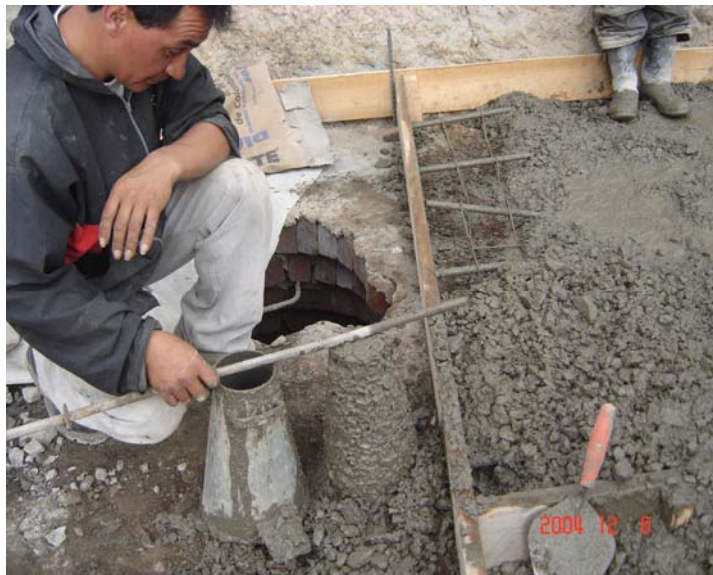
Foto 15. Consistencia de la mezcla (Slump)
