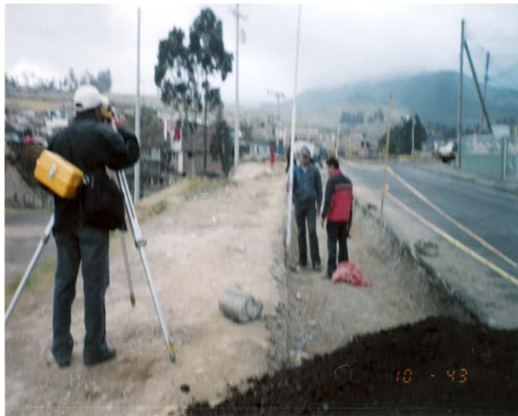
Foto 32. Replanteo nivel de subbase
