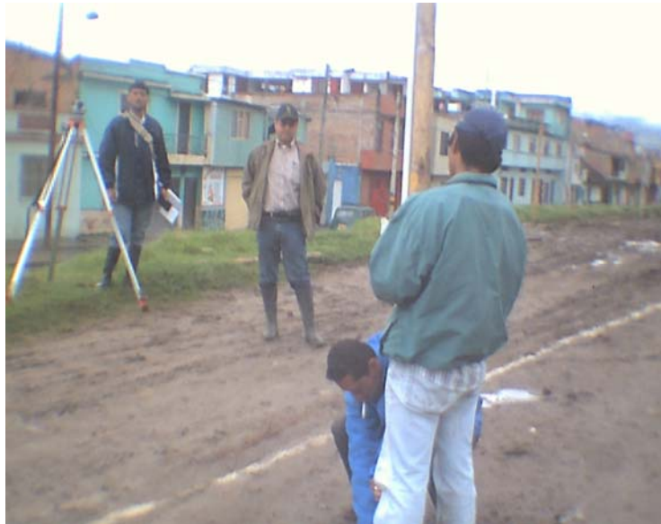
Foto 48. Colocación de niveletas en la vía
