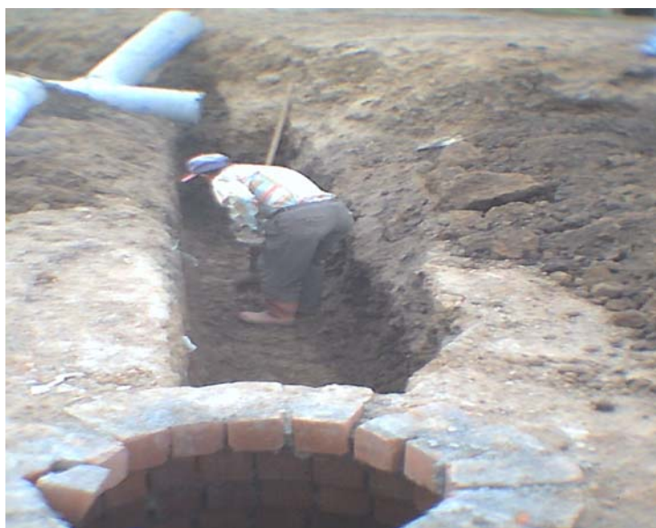
Foto 59. Excavación manual instalación tubería para sumideros
