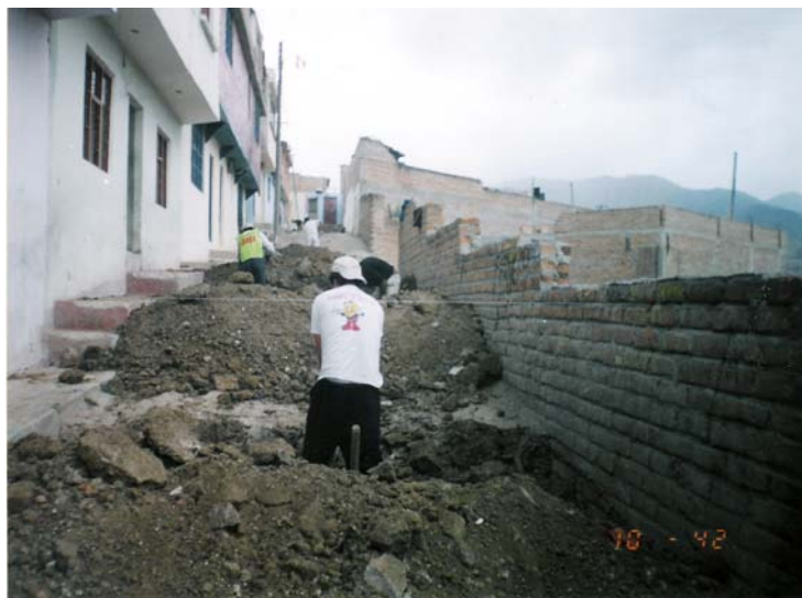
Foto 3. Excavación manual material conglomerado
