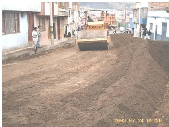
2.4.2 Construcción de la base en suelo- cemento. Antes de construir la base estabilizada se comprueba que la superficie que va a servir de apoyo tenga la densidad y lisura apropiada como también el perfil transversal y la rasante de la vía. Se debe contar con todo el equipo que se va a utilizar en la formación de la base estabilizada en suelo- cemento.
