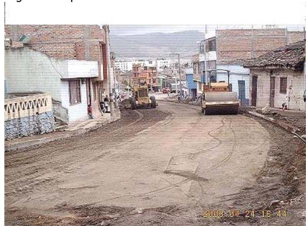
2.4.2.7 Acabado. La superficie debe quedar lisa, densa y libre de estrías, los tres días siguientes se irriga agua a la base estabilizada a fin de que se hidrate y no pierda humedad.
