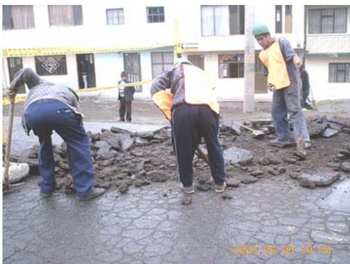
Fig. 17. Demolición capa de rodadura
