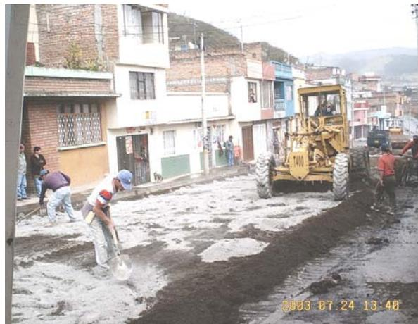
2.4.2.6 Compactación. Espesor de la capa quince centímetros, se consolida la capa formada hasta lograr una densidad máxima igual a la del próctor, la compactación se inicia partiendo de los bordes hacia el centro y en las curvas con peralte se procede a la inversa. Si el piso ha quedado ondulado la motoniveladora restituye el perfil y se humedece de nuevo el suelo suelto.
