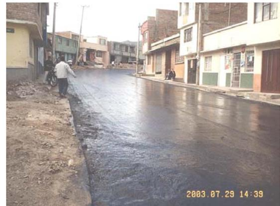
2.4.2.9. Carpeta de rodadura. Espesor = 5 cms, colocación del concreto asfáltico de gradación densa mezclado en planta y en caliente, extendido en una capa de cinco centímetros de espesor que tendrá la composición establecida por las especificaciones.
