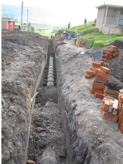
**Relleno de tubería con material de sitio**
