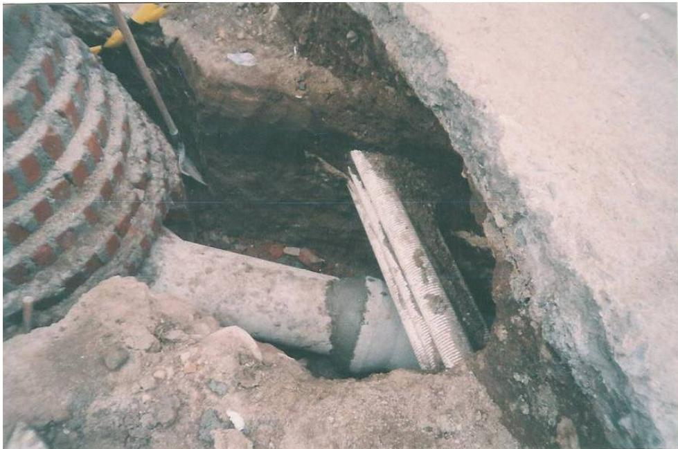
**Tubería de alcantarillado combinado antigua que se rompió durante el proceso de excavación**
