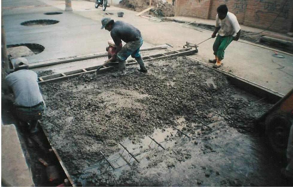
**Refuerzo transversal colocado mediante canastilla**
