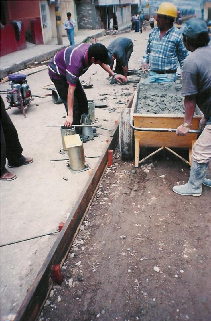
**Ensayo de asentamiento de mezcla – cono de Abrams**
