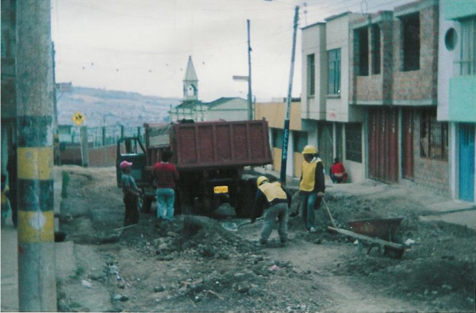
**Conexión sumidero convencional con tubería de 10"**
