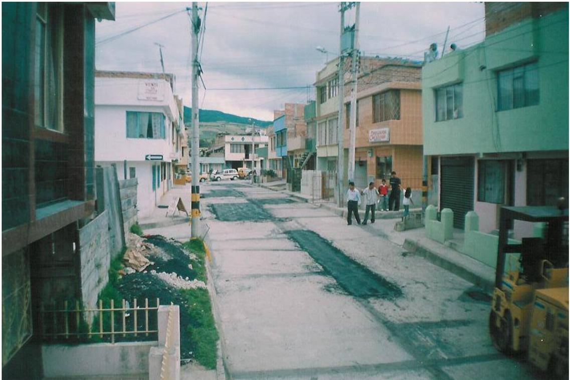
**Base de pavimento rígido soplado con compresor**
