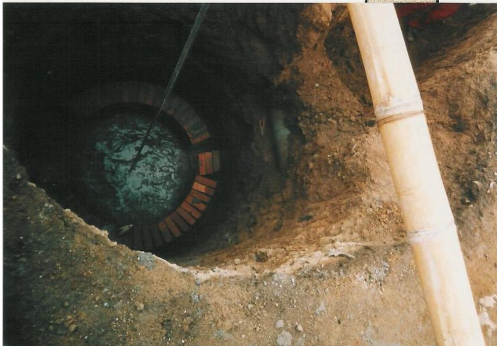
**Pozos de inspección con cámara de caída**
