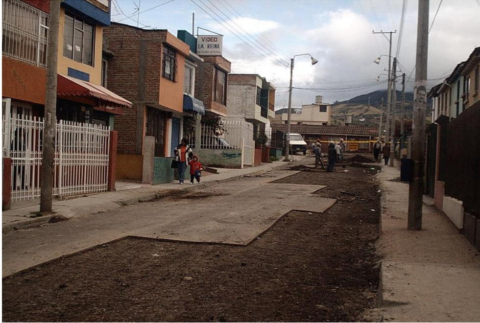
**Excavación a mano en material común**
