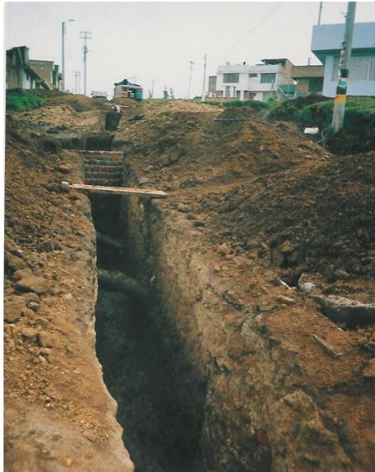
**Excavación a maquina para la instalación de tubería de 10" y 14"**
