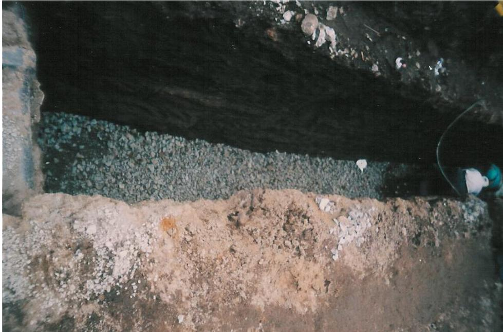
**Conexión de tubería de 12" a cámara de inspección de
