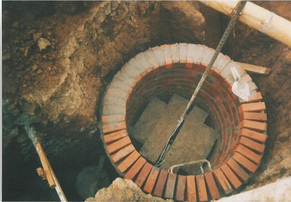
**Cámara de inspección de profundidad entre 1.80m<H<3m**
