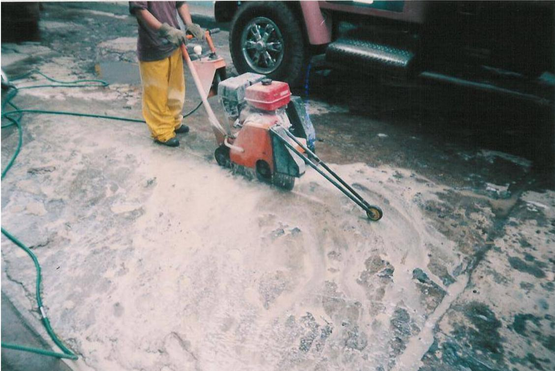
**Demolición capa de rodadura, excavación y desalojo de material sobrante**
