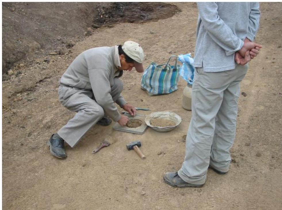
**Toma de densidades a relleno realizado para el alcantarillado**
