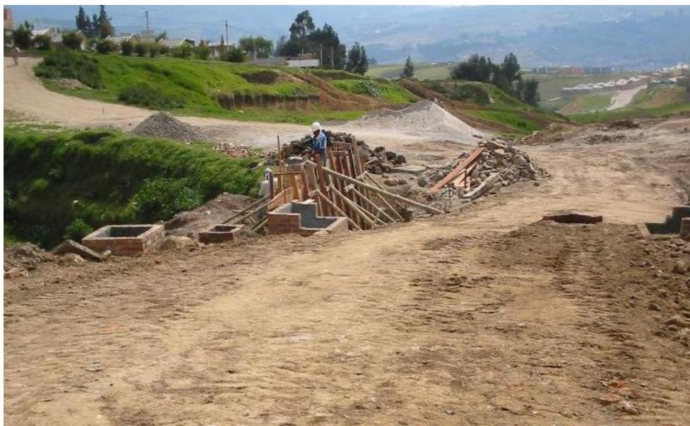
**Construcción de muro en concreto ciclópeo al final del pavimento**
