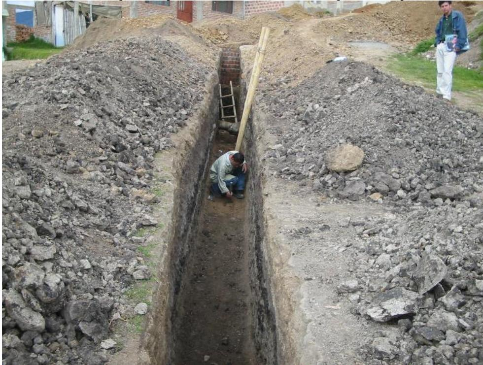
**Alineamiento por medio de hilo, para la instalación de tubería de alcantarillado**
