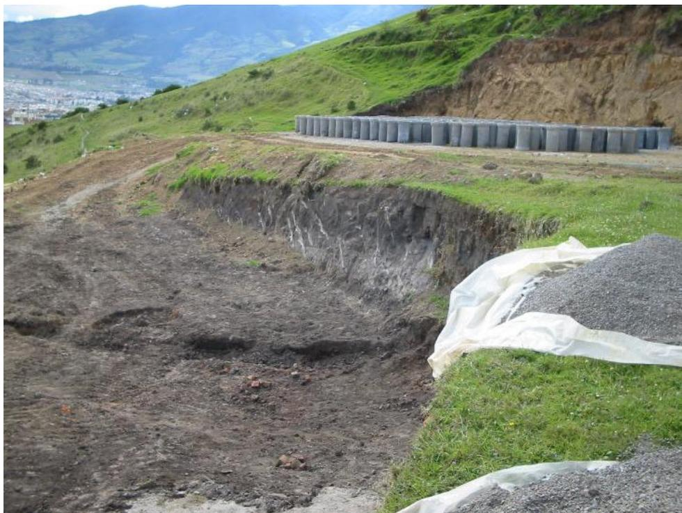
**Tubería construida de 10" y 14"**
