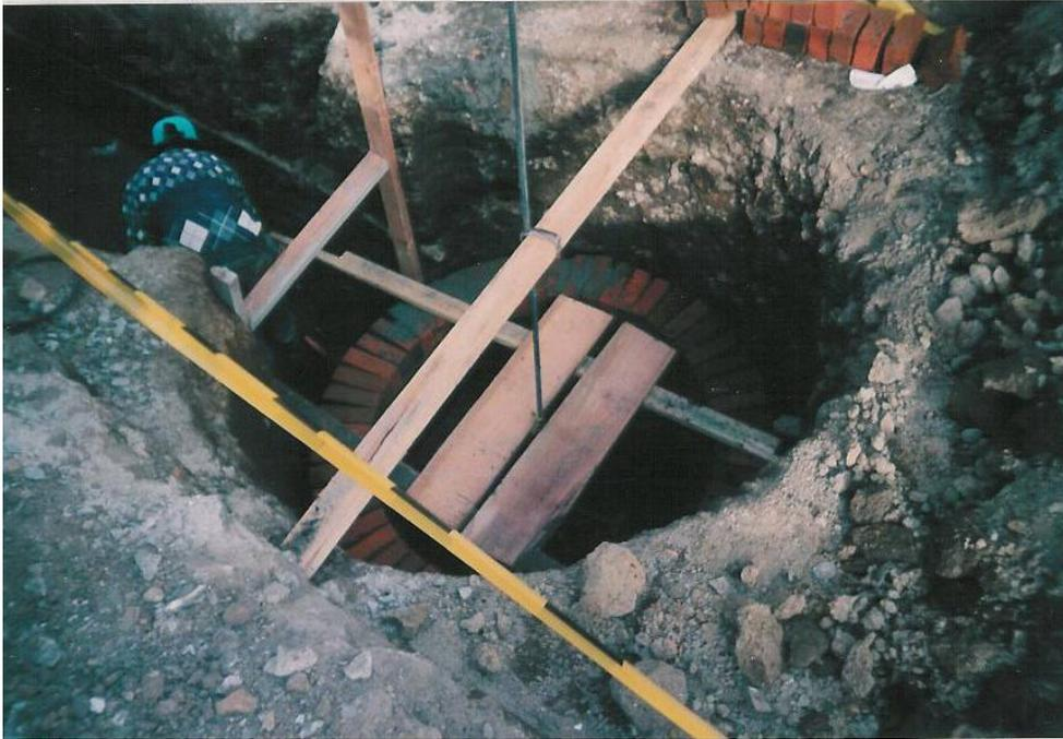
**Cámara de inspección de alcantarillado sanitario y señalización**
