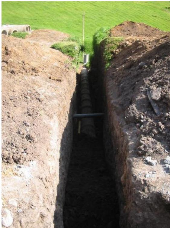
**Relleno de tubería con material de sitio**
