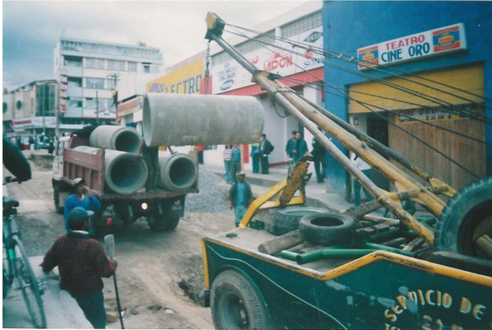
**Instalación de tubería de 27"**
