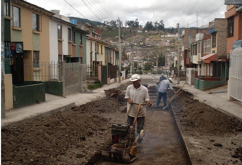
**Retiro de arena amarilla que se colocó sobre la lechada de asfalto líquido, curado MC-70**
