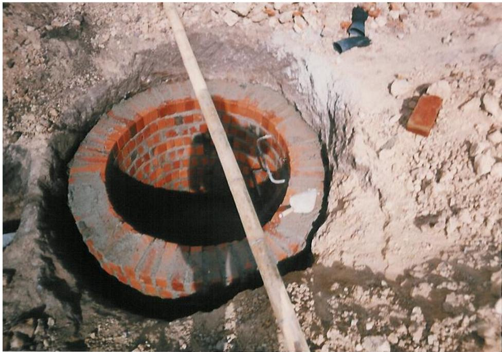
**Cámaras de inspección de profundidad entre  $1.80m < H < 3m$
