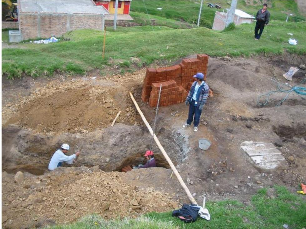
**Pozos de inspección con cámara de caída**
