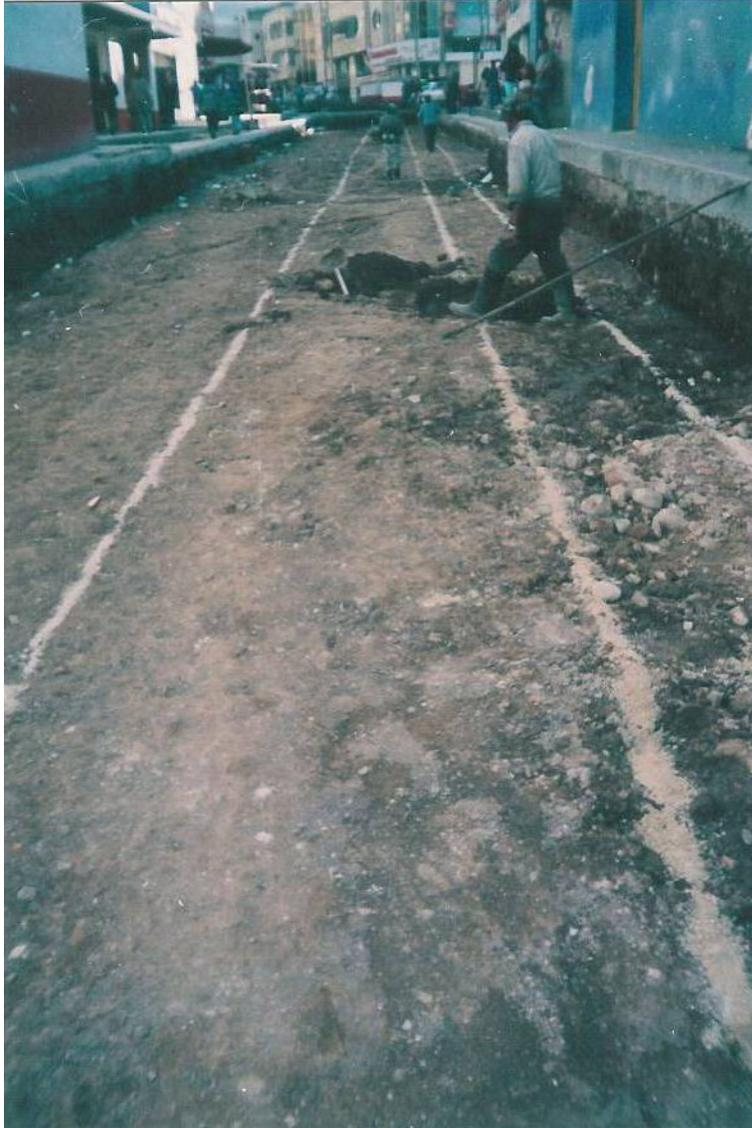
**Excavación para la instalación de la tubería del
