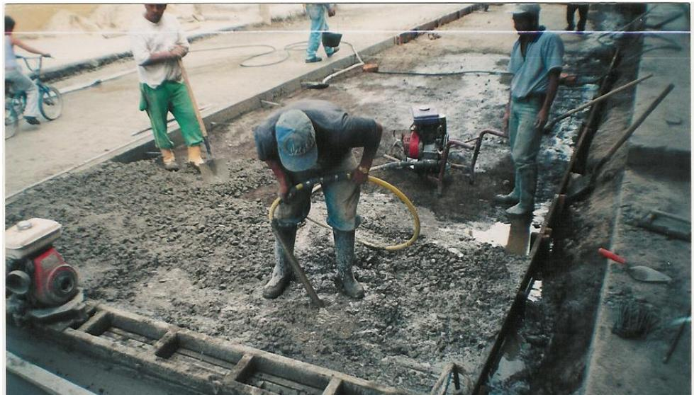
**Reacomodo de los materiales utilizando regla vibratoria**
