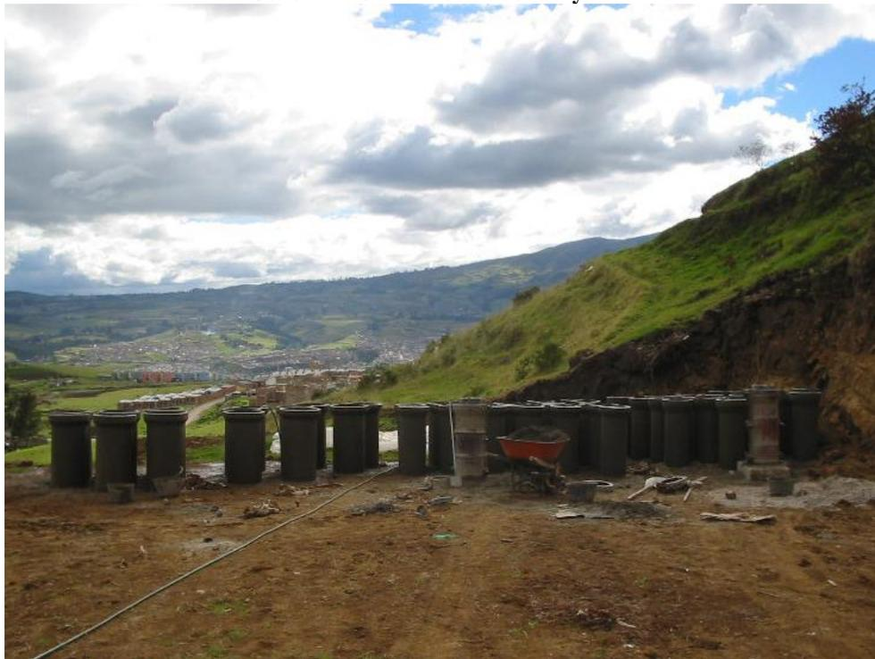
**Tubería construida de 10" y 14"**
