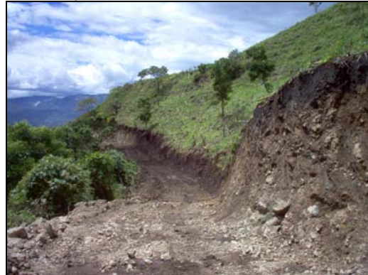
Figura 16. Avance 1300m. Ancho aproximado 6.0m
