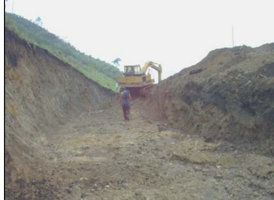
Figura 12. Avance 820m. Ancho aproximado 5,60m.
