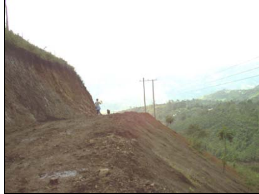
Figura 9b. Mina de material. 643m de Avance. Ancho aproximado 5.00m
