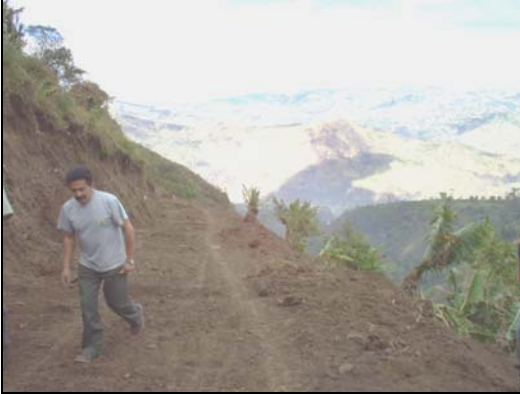
Figura 6a. Vía. 220m de avance. Ancho aproximado 4,50m
