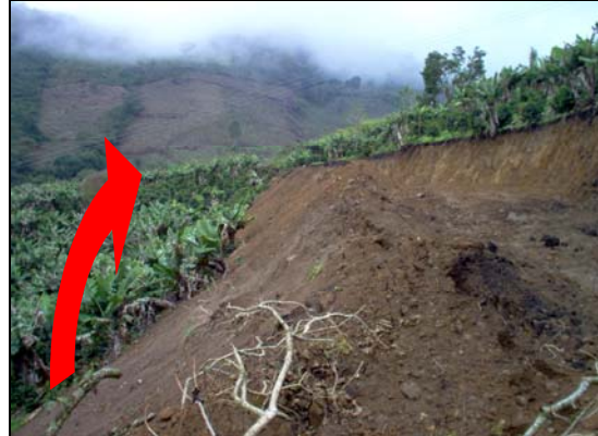
Figura 10b. Desvió de curva 4,70m. II 470m de avance. Ancho aprox. 4,50m
