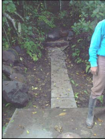
Figura 31. Canal de conexión acueducto El Hatillo.
