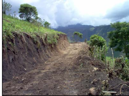
Figura 14. Avance 938m. Ancho aproximado 6,00m
