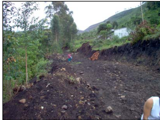
Figura 08. Vía. 540m de avance. Ancho aproximado 5,00m
