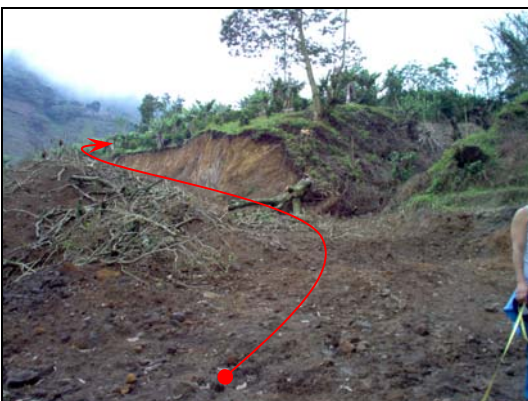
Figura 10a. Desvió de curva 4,70m. II 470m de avance. Ancho aprox. 4,50m.
