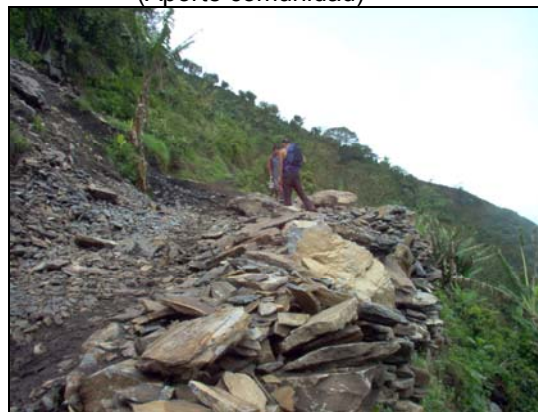
Figura 03. Muro de contención (Aporte comunidad)
