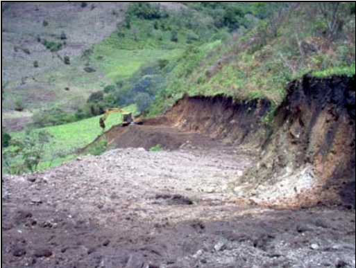
Figura 15. Avance 1150m. Ancho aproximado 6.00m
