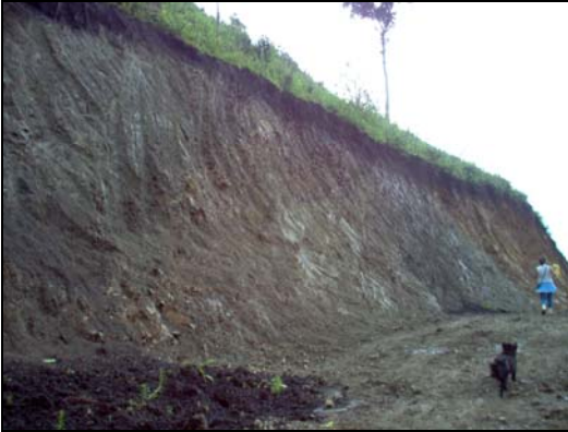
Figura 9a. Mina de material. 643m de avance.
