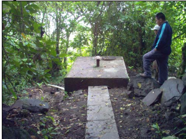
Figura 32. Desarenador acueducto El Hatillo
