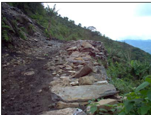
Figura 02. Muro de contención (Aporte comunidad)
