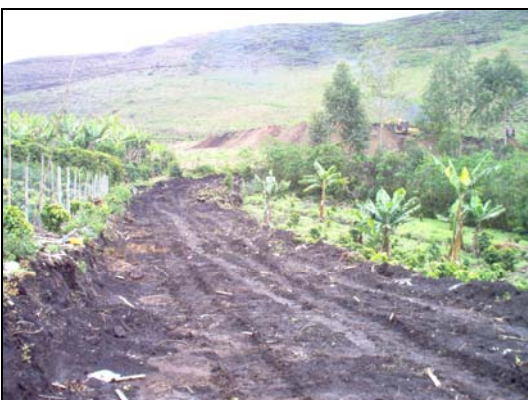
Figura 11. Avance 705m. Ancho aproximado 6,00m.
