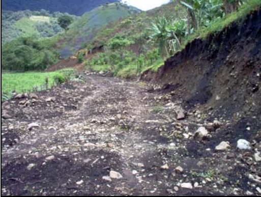
Figura 13. Avance 890m. Ancho aproximado 6,0m
