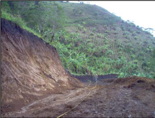
Figura 07. Vía. 379m de avance. Ancho aproximado 4,00m
