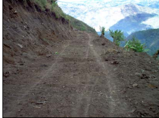
Figura 6b. Vía. 220m de avance. Ancho aproximado 4,50m
