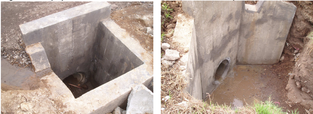
Figura 6. Caja y cabezote de alcantarilla en concreto simple
