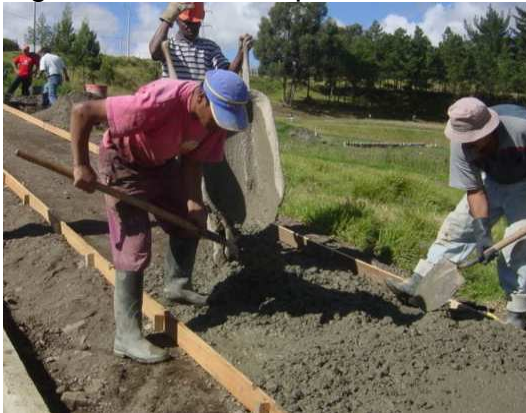
Figura 9. Fundición placa de andén
