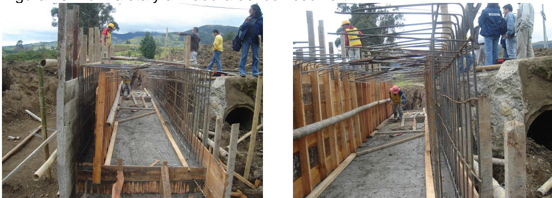
Figura 45. Formaleta y armadura del box coulvert
