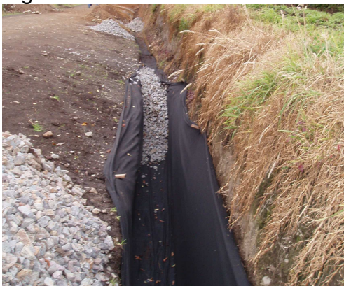
Figura 32. Construcción de filtros
