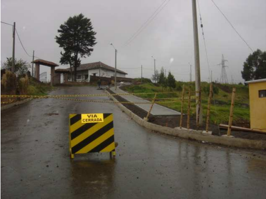
Figura 11. Señalización de cierre de vía
