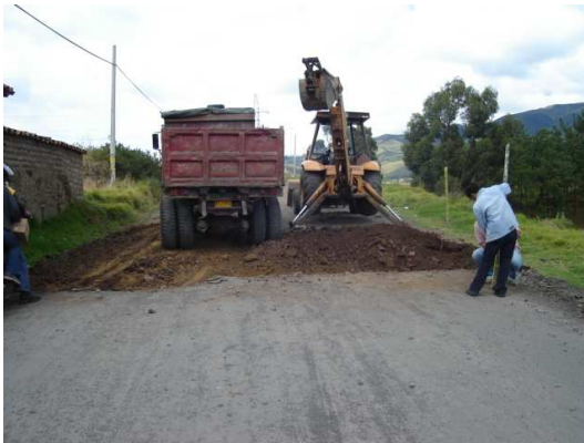
Figura 4. Excavación a máquina subrasante
