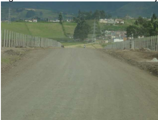
Figura 48. Estado inicial vía Cam – Mijitayo
