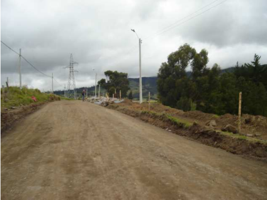
Figura 10. Compactación de la subrasante
