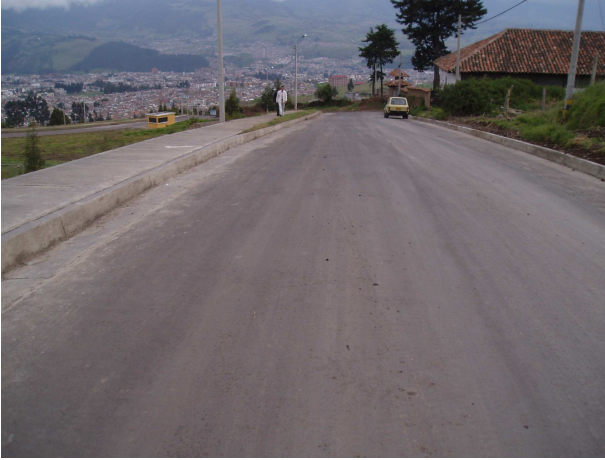
Figura 21. Estado final vía pavimentada Obonuco
