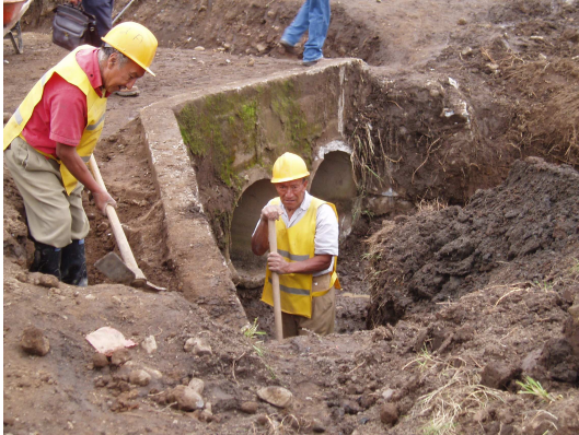
Figura 43. Excavación manual de box coulvert
