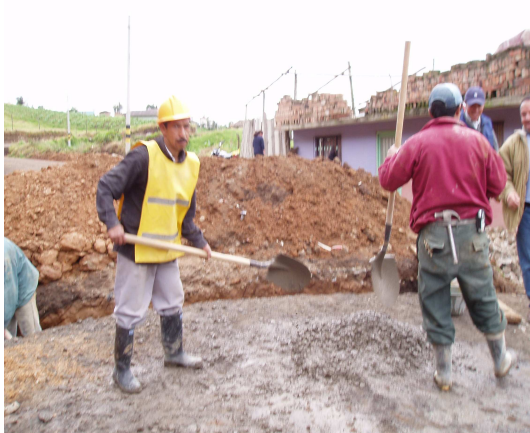
Figura 37. Instalación tubería de concreto
