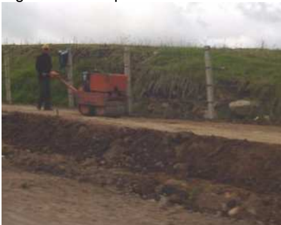
Figura 50. Compactación del recebo
