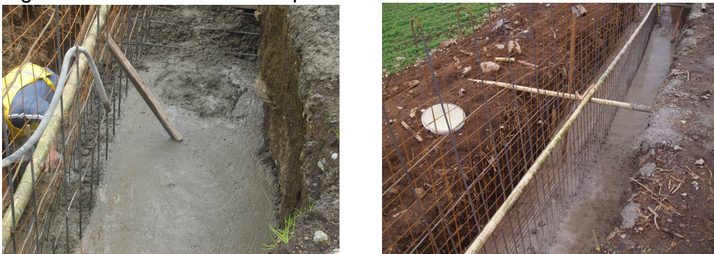
Figura 34. Fundición de la zarpa en los muros de contención
