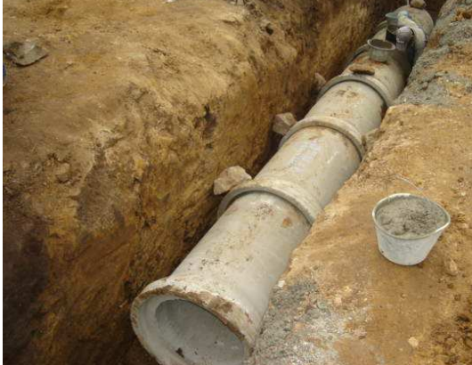
Figura 5. Instalación alcantarilla de tubería de concreto
