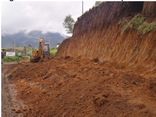
Figura 28. Excavación a maquina cortes de talud
