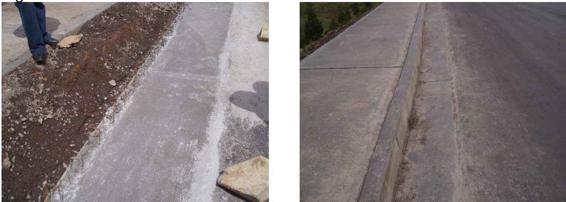
Figura 19. Construcción cuneta – sardinel
