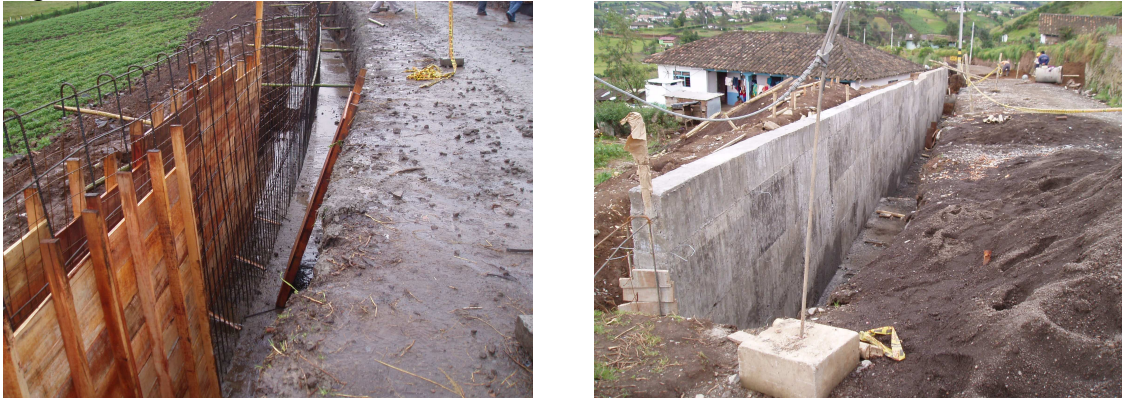
Figura 35. Construcción de los muros de contención
