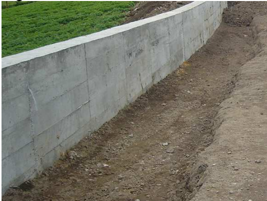
Figura 36. Relleno de muros de contención.
