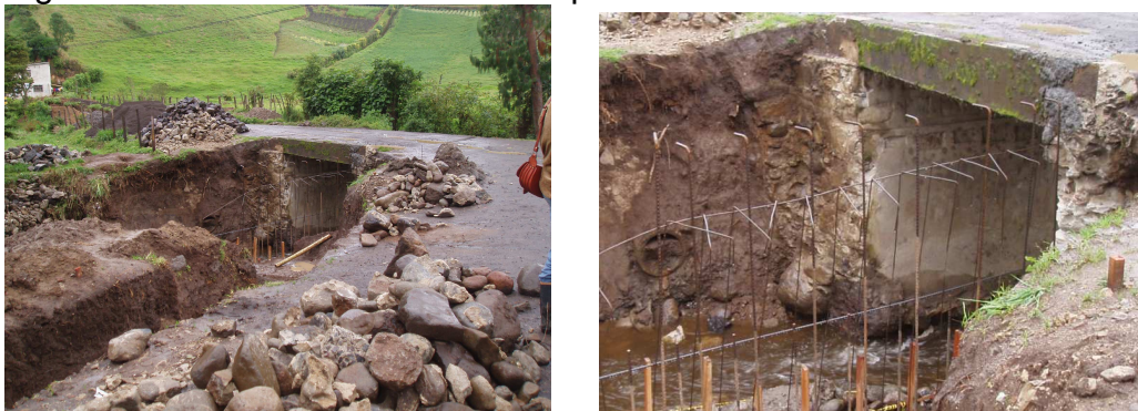
Figura 40. Demolición de aletas del pontón
