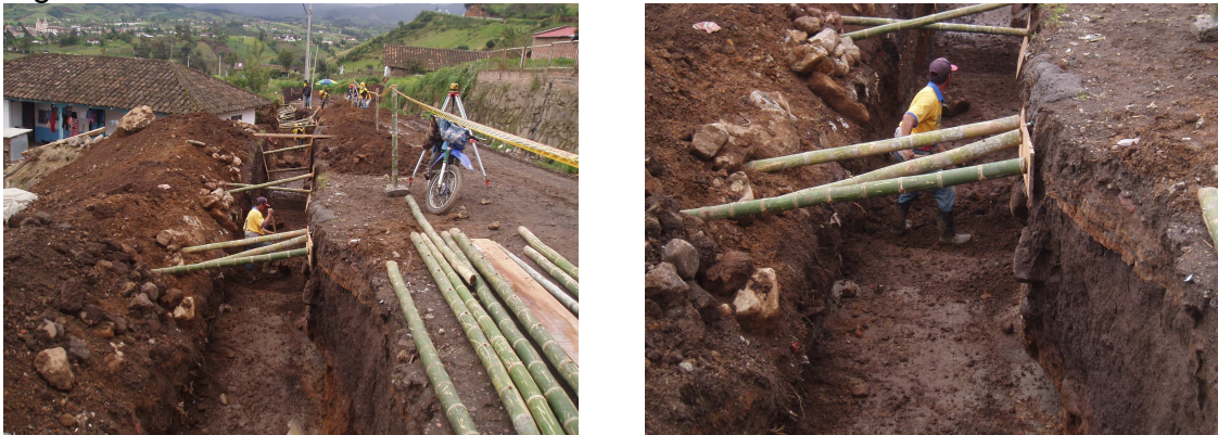
Figura 30. Excavación manual de muros de contención
