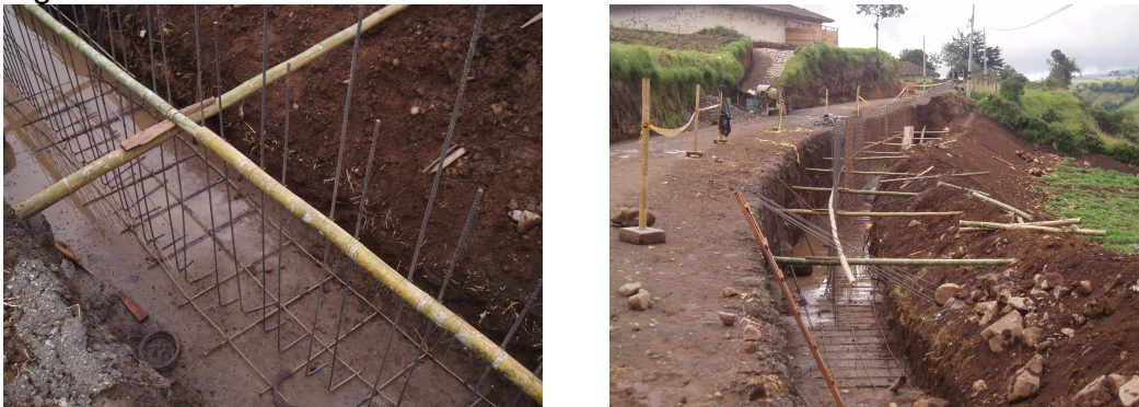
Figura 33. Colocación del refuerzo en los muros de contención
