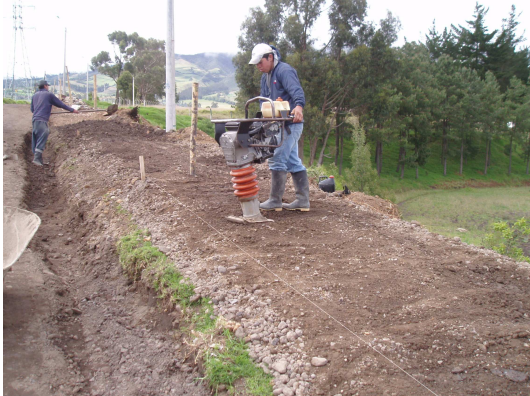
Figura 8. Compactación del recebo con saltarín
