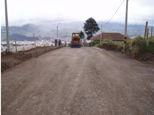
Figura 14. Compactación de la base granular
