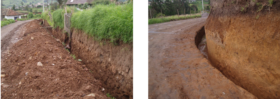
Figura 29. Excavación manual filtros
