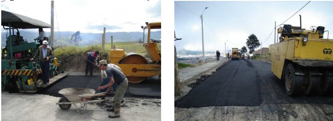
Figura 16. Conformación de la carpeta asfáltica
