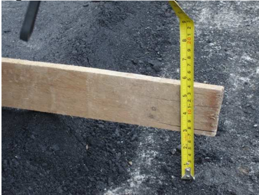
Figura 18. Control del espesor de la carpeta
