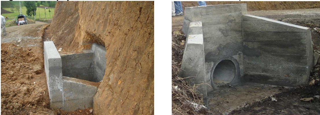
Figura 38. Caja y cabezote de alcantarilla en concreto simple
