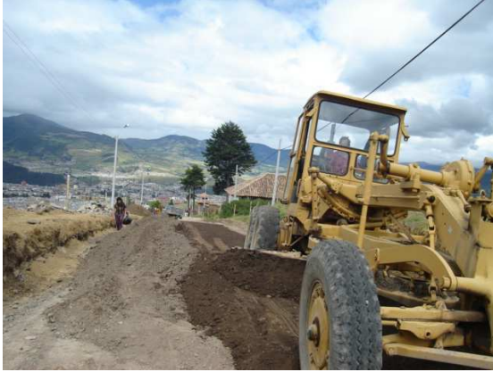
Figura 12. Conformación de material de subbase
