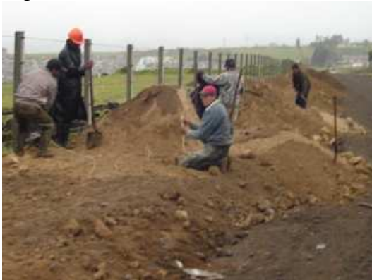
Figura 49. Relleno con recebo
