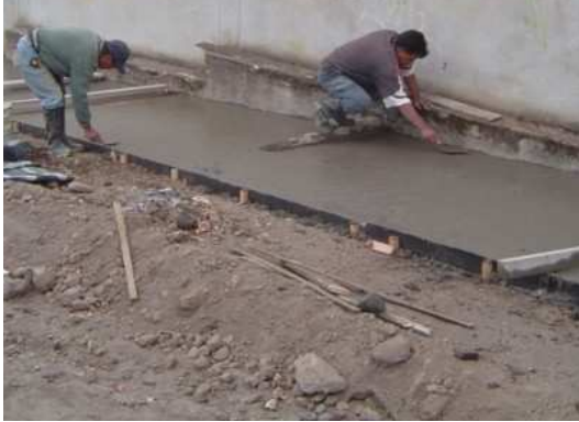
Figura 51. Fundición placa de andén
