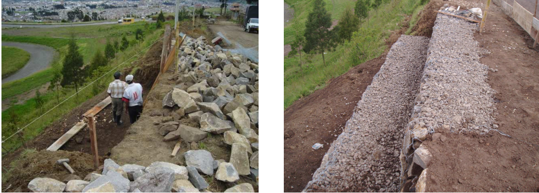
Figura 7. Construcción de muro de contención en gavión
