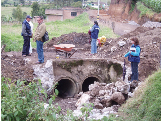
Figura 44. Demolición de aletas de box coulvert
