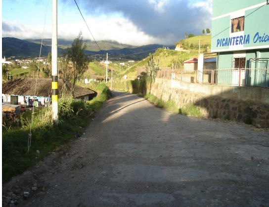
Figura 24. Estado inicial vía La Laguna
