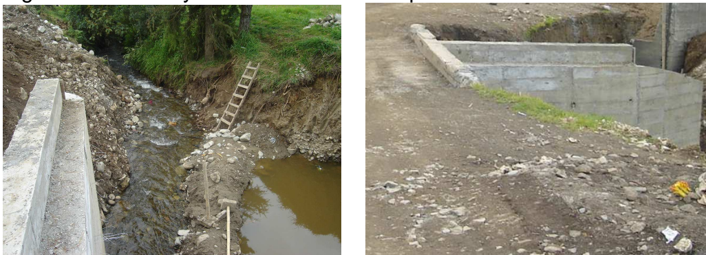
Figura 41. Estribo y aleta en concreto simple
