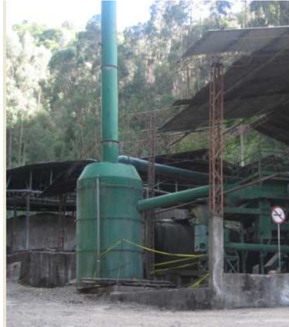
Figura 13. Depurador húmedo
