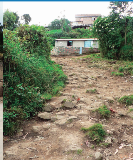
Excavado y/o tallado en roca, con cunetas
