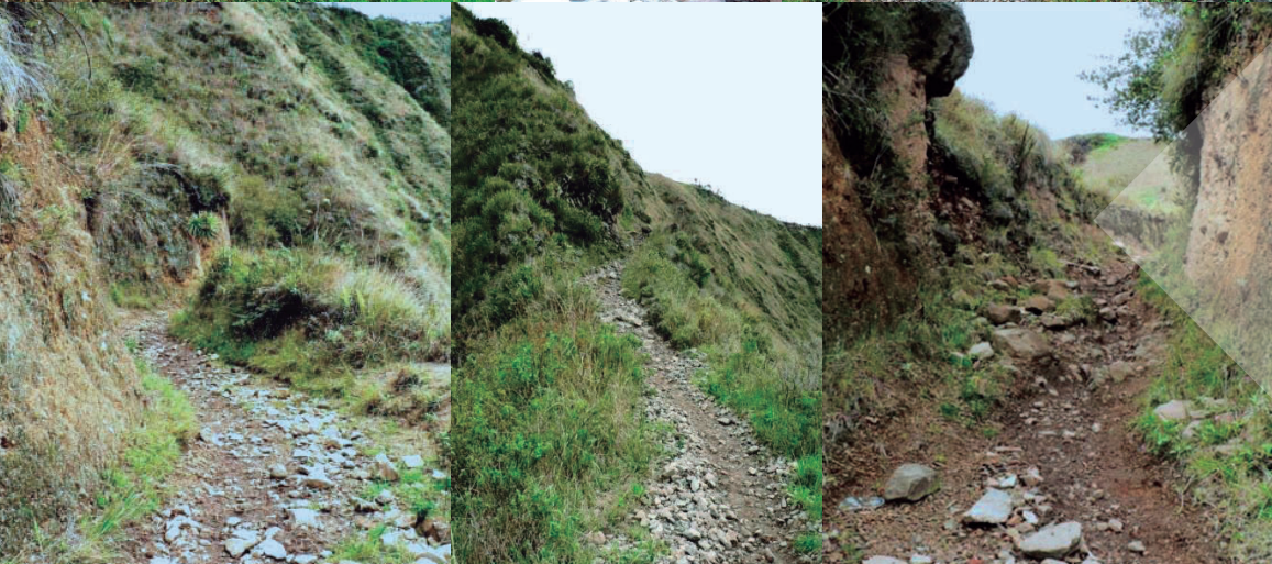
Figura 23 Superficie y taludes camino sección Rosal de Chapal (Funes)
