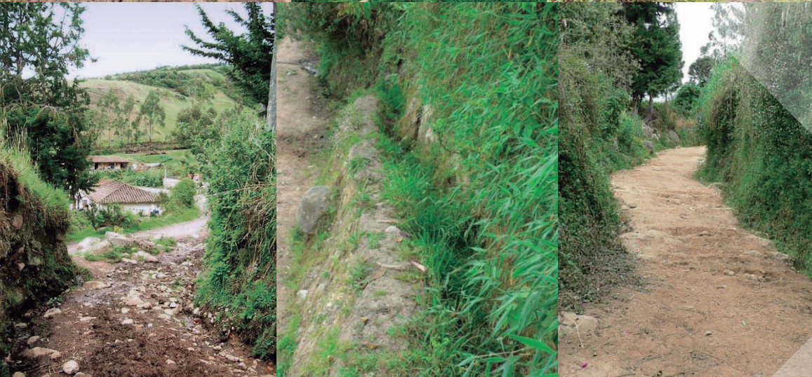
Figura 26 Superficie y canales camino sección Los Ajos (Tangua)
