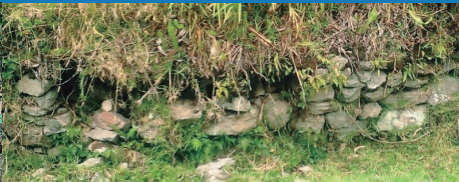
Excavado y/o tallado en roca, con muros en piedra (Sostenimiento talud)
