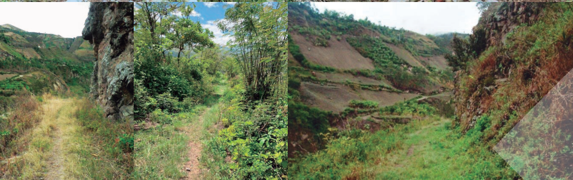
Figura 24 Taludes y muros de demarcación camino sección Guapuscal Bajo (Funes)
