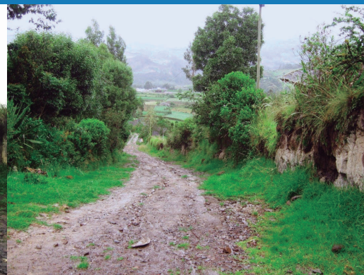
Plataforma (corte talud)
