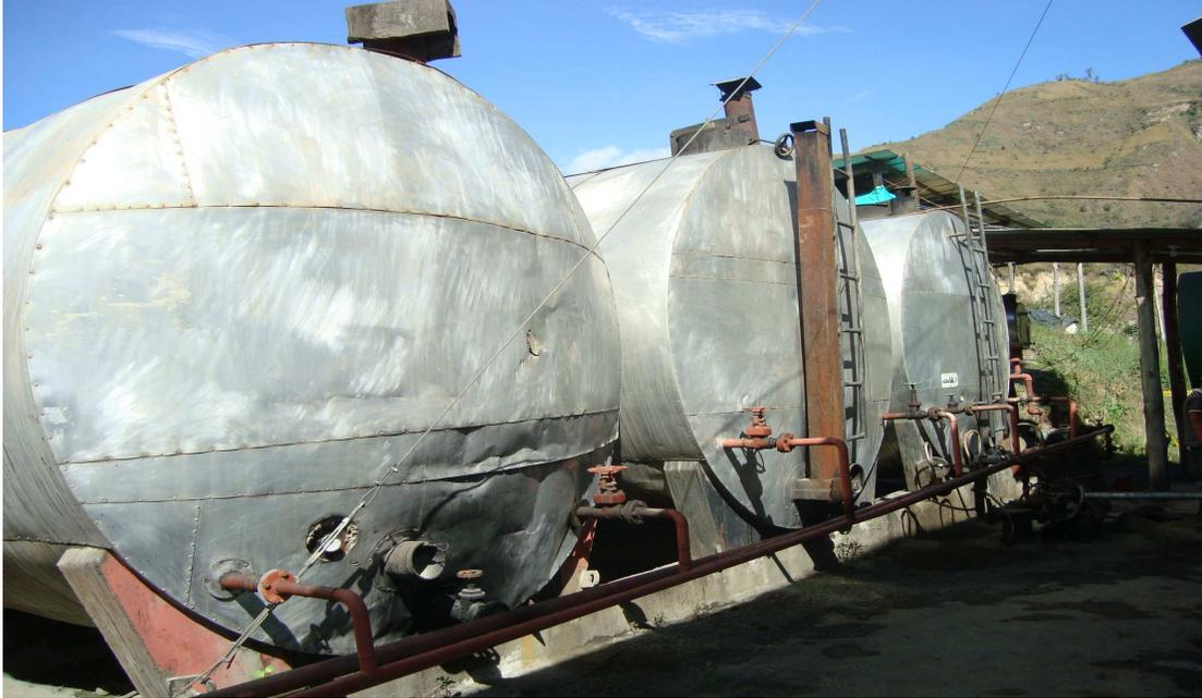
**Foto No.11. Tanques almacenaje de asfalto**
