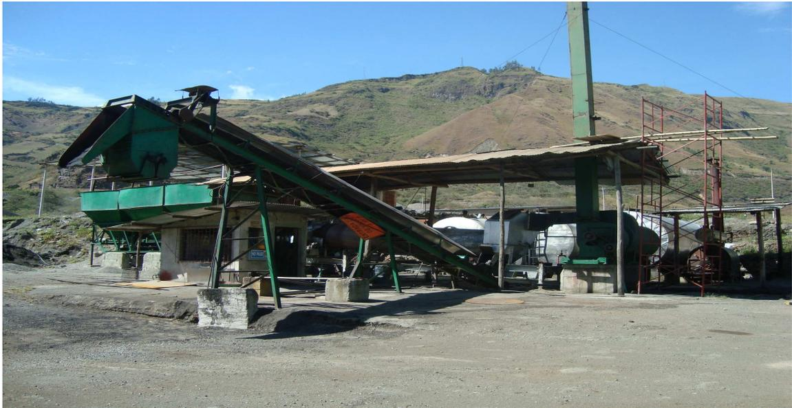
En una planta asfáltica continua (Ver foto No.3), los agregados son combinados, calentados, secados, dosificados, y mezclados con el cemento asfáltico para producir una mezcla asfáltica en caliente. Los componentes principales de una planta continua son:
