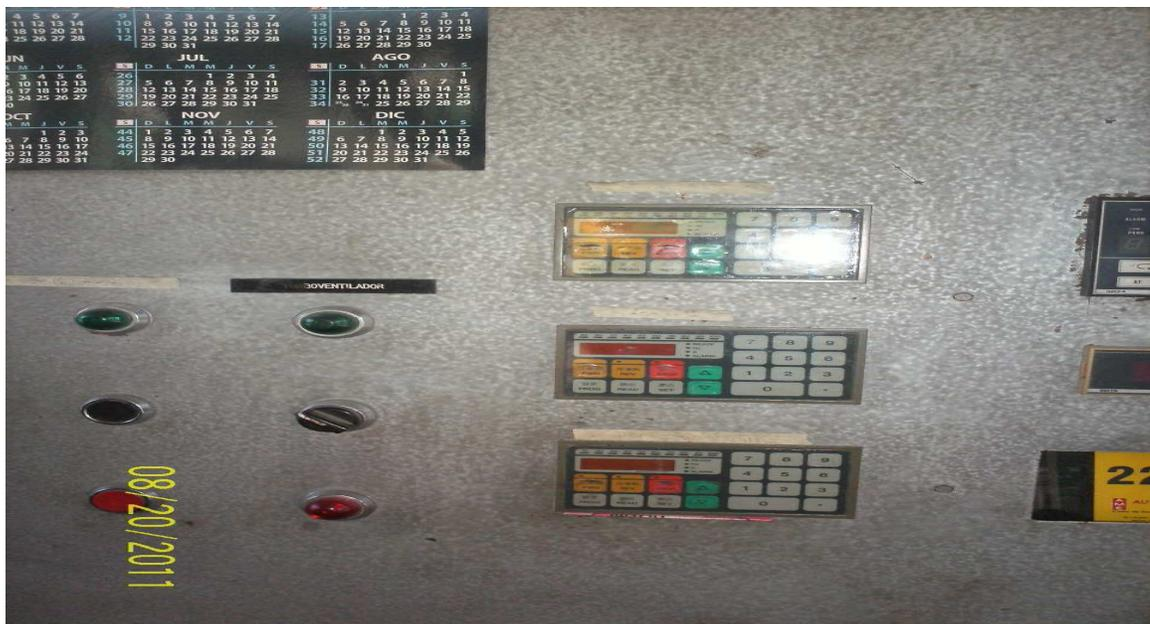
Dispositivos para dosificar el asfalto: la planta estará provista de balanzas de pesaje o de dispositivos de medición y calibración del asfalto, para asegurar que la dosificación de la mezcla se halle dentro de las tolerancias especificadas en la fórmula maestra de obra.
