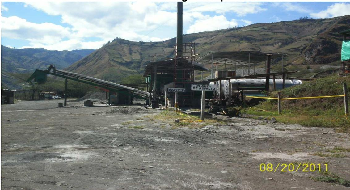
Diferencia entre plantas asfálticas continuas y discontinuas: la diferencia fundamental entre estas dos plantas reside en el método de dosificación; ya que en la planta discontinua se pesa los materiales cada vez que se inicia una amasada, mientras que en la planta continua es preciso mantener una dosificación volumétrica continua de los materiales.
