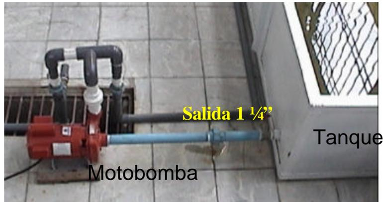
La acometida del equipo inicialmente se hizo con tubería RDE 21  $\phi$  1 1/4 la cual estaba unida a dos codos simultáneos que estaban produciendo una succión en la tubería y como consecuencia arrojaba lecturas falsas; esta acometida fue reemplazada por una manguera de alta presión de  $\phi$  1 1/4 de 4m. de longitud La cual hace que el agua de una curva bastante amplia antes de ingresar al sistema.
