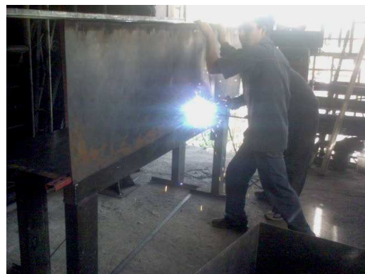
Figura 44 Soldadura de Tanques
