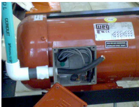
Figura 66 Conexión trifásica de bomba
