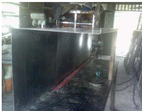
Figura 43 Aseguramiento de los Tanques
