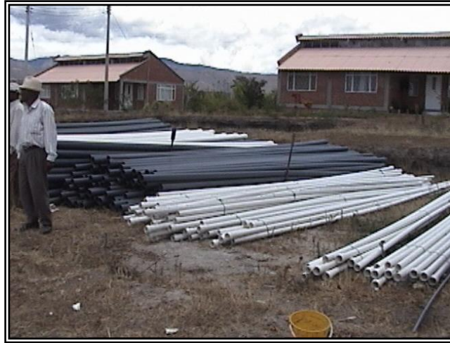
FOTO No. 05 ACOPIO DE MATERIALES – TUBERÍA PVC
