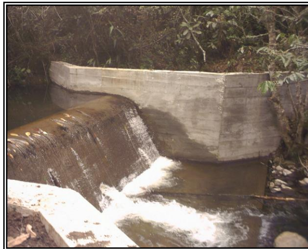
FOTO No. 06 BOCATOMA UBICADA EN EL RIO SALADO
