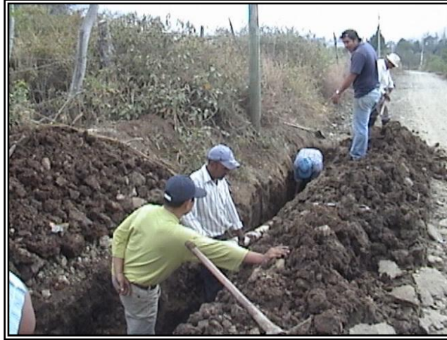
FOTO No. 09 EXCAVACIÓN MANUAL PARA TUBERÍA
