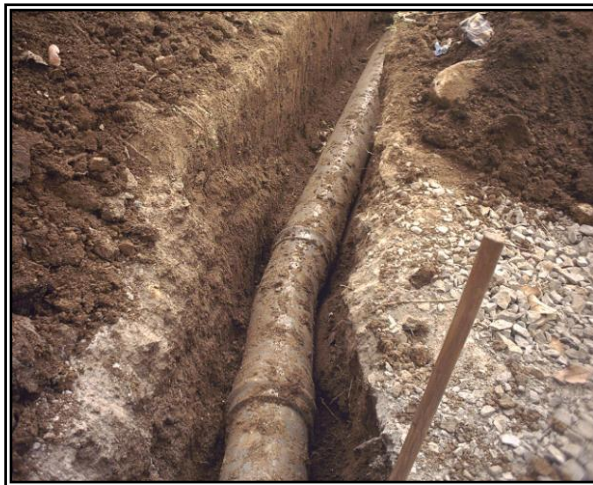
FOTO No. 10 INSTALACIÓN DE TUBERÍA MATERIAL EN PVC – DETALLE TUBOS Y CODO GRAN RADIO
