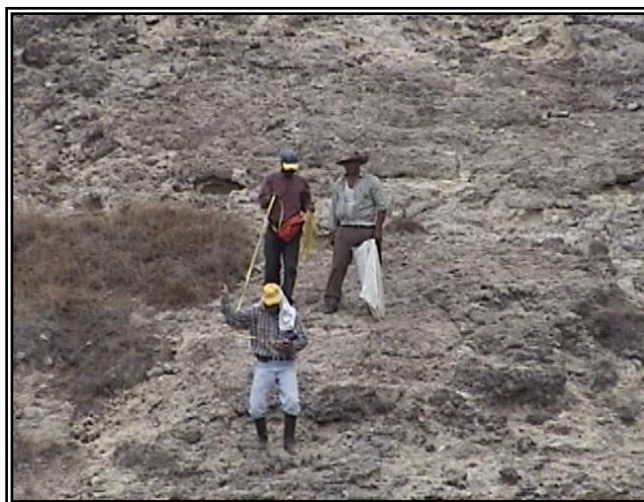
FOTO No. 02 MEDICIONES PROCESO TOPOGRÁFICO
