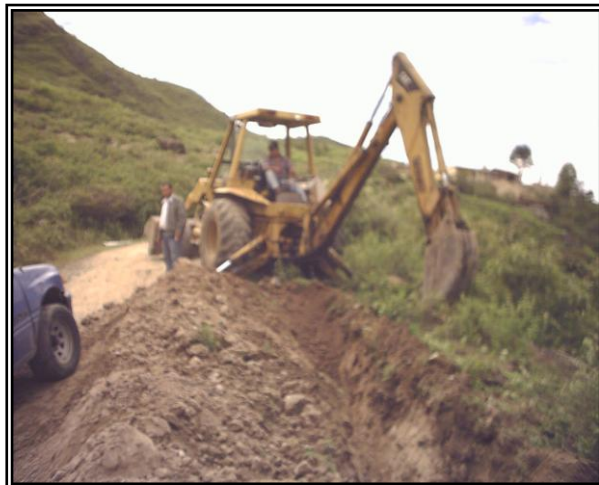
FOTO No. 08 EXCAVACIONES MECÁNICAS PARA TUBERÍA
