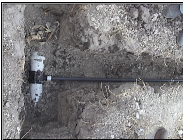
FOTO No. 14 DERIVACIÓN INDIVIDUAL PARA CADA USUARIO
