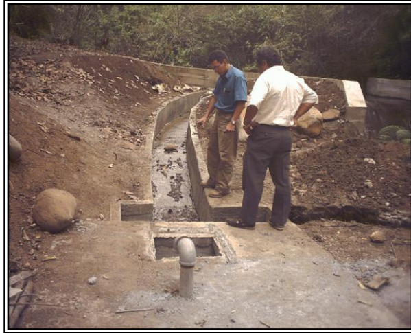
FOTO No. 07 VISTA FRONTAL CONSTRUCCIÓN DESARENADOR
