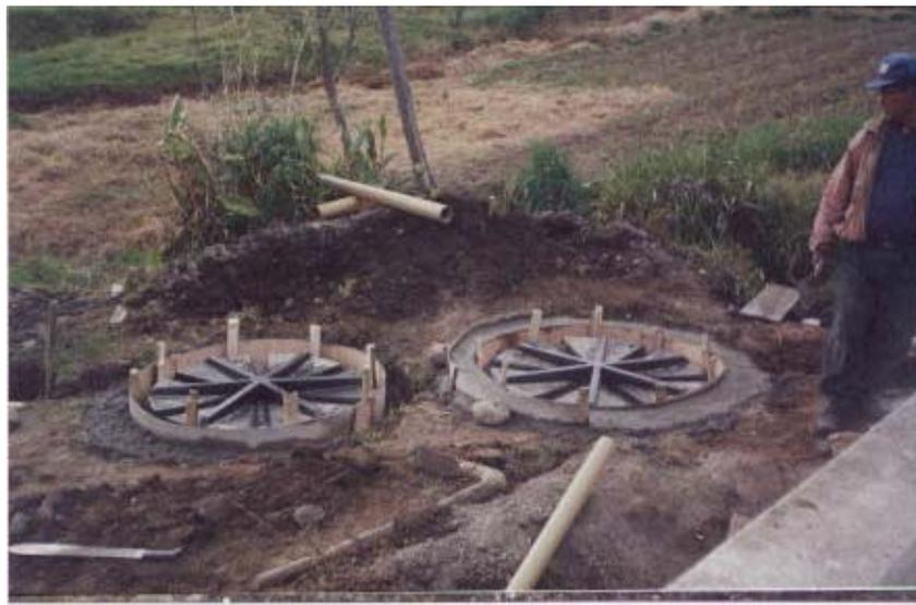
El problema más relevante se suscitó en la construcción de algunos pozos de absorción ya que en la excavación de estos se encontró con suelos poco o nada permeables y en otras situaciones más graves se encontró la presencia de nivel freático a poca profundidad como se observa en la Figura 2. Bajo estas situaciones, el funcionamiento de los pozos de absorción se ve frustrado o por lo menos limitado; por lo cual se debe dar una solución inmediata.
