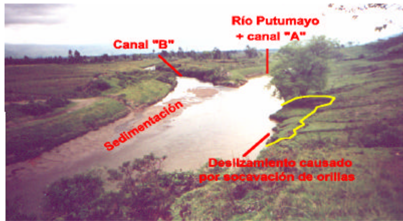
Figura 26. Saturación de sedimentos en el sistema de canalización.
