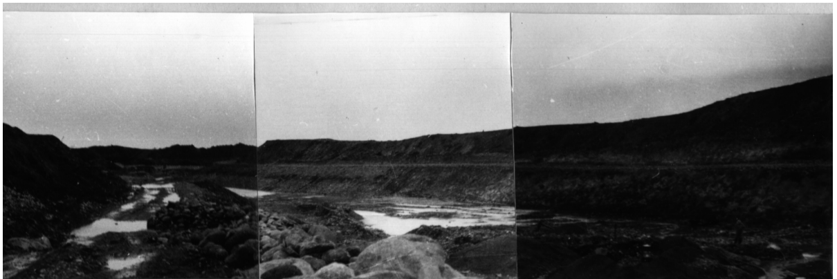
Figura 20. Construcción de Distrito de Drenaje en el Valle de Sibundoy.
