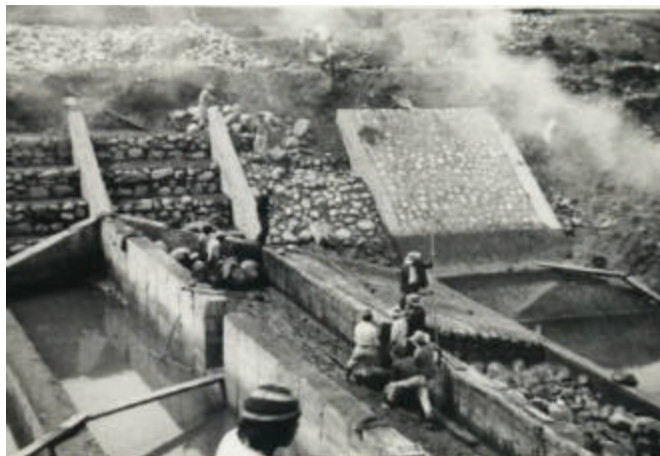
Figura 21. Construcción de dique sobre canal.
