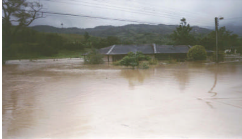
Figura 25. Viviendas afectadas por inundación.
