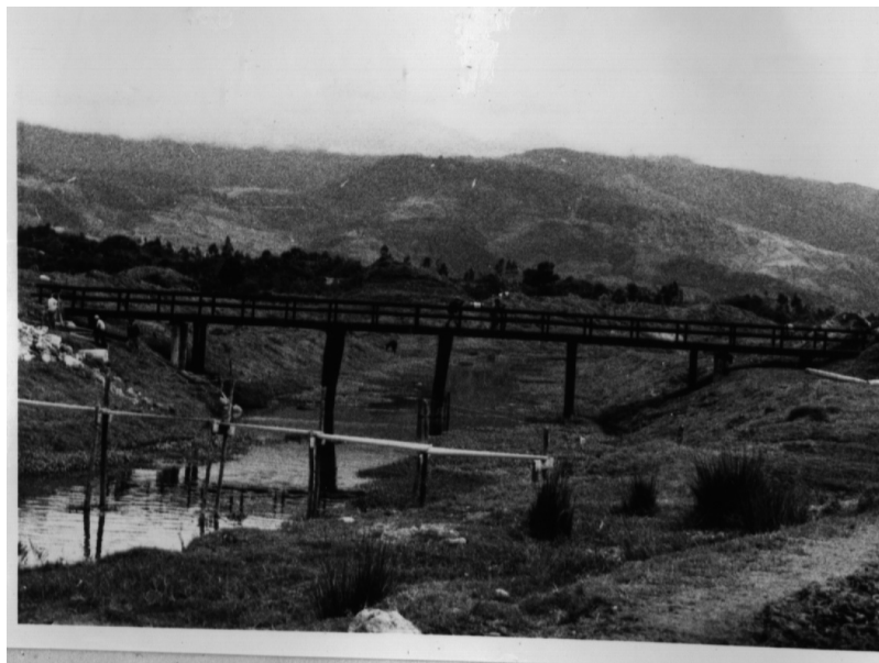
Figura 23. Construcción de puente sobre canal "C".
