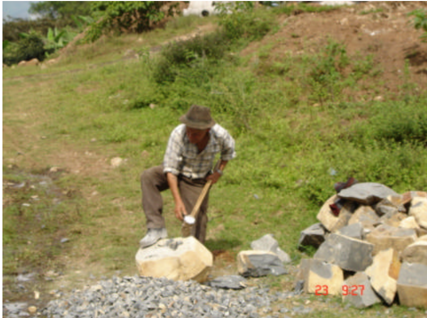
Figura 49. Trituración de roca
