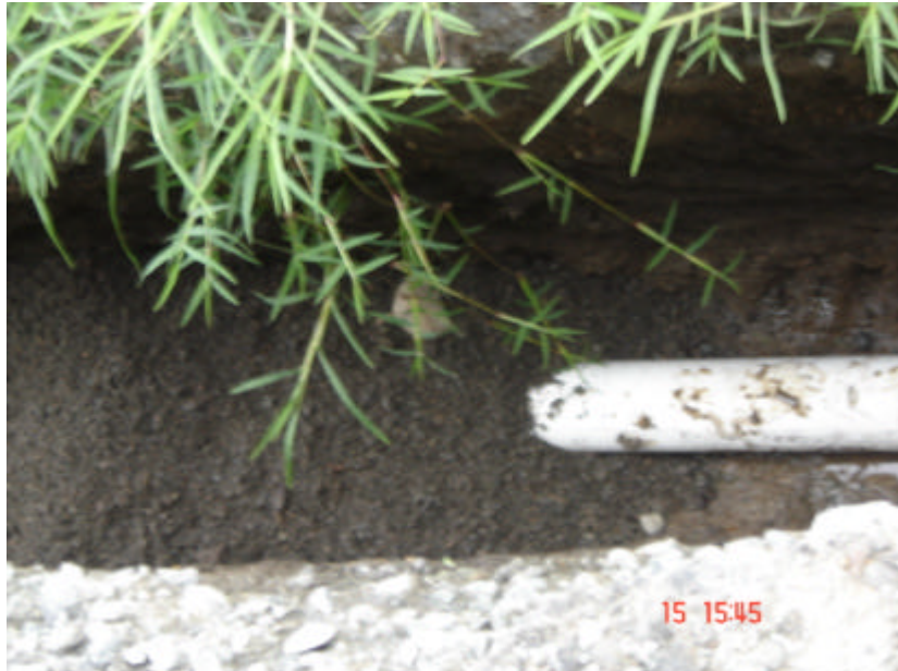
Figura 66. Adecuación de piso
