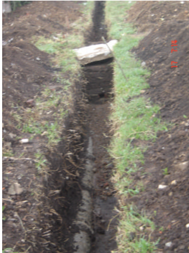
Figura 65. Zanja para acueducto
