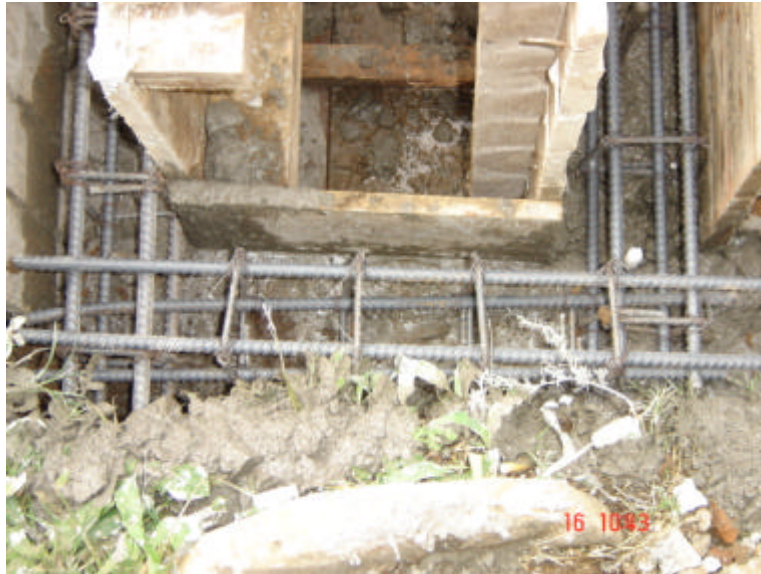
Figura 82. Refuerzo de muros
