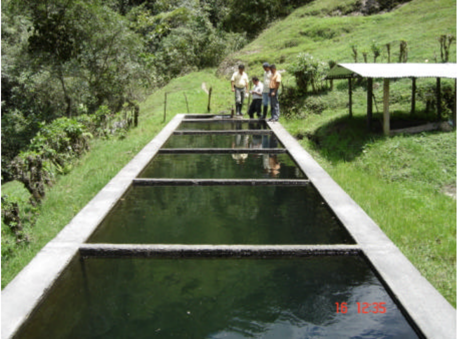
Figura 7. Desarenador
