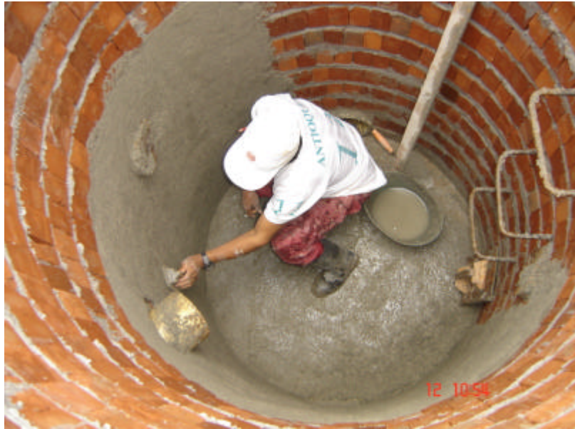
Figura 51. Esmaltado de cámara
