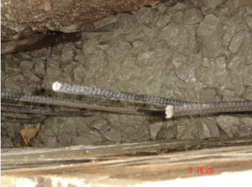
Foto 81. Refuerzo de muros
