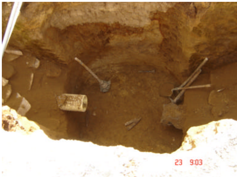
Figura 43. Excavación para pozo de inspección
