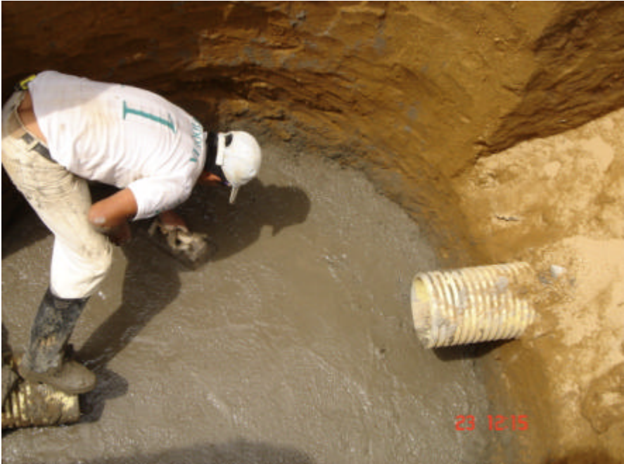
Figura 48. Solado inferior
