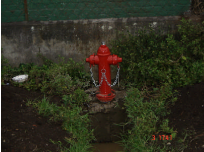
Figura 70. Instalación de hidrante
