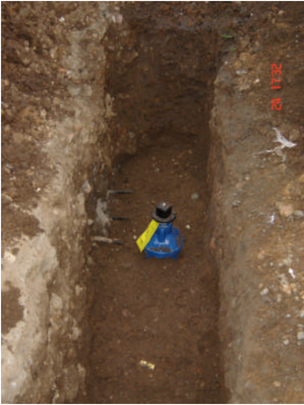
Figura 70. Instalación de hidrante
