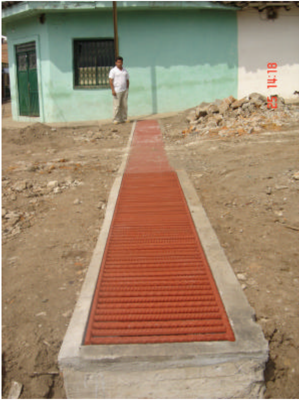
Figura 84. Sumidero transversal terminado
