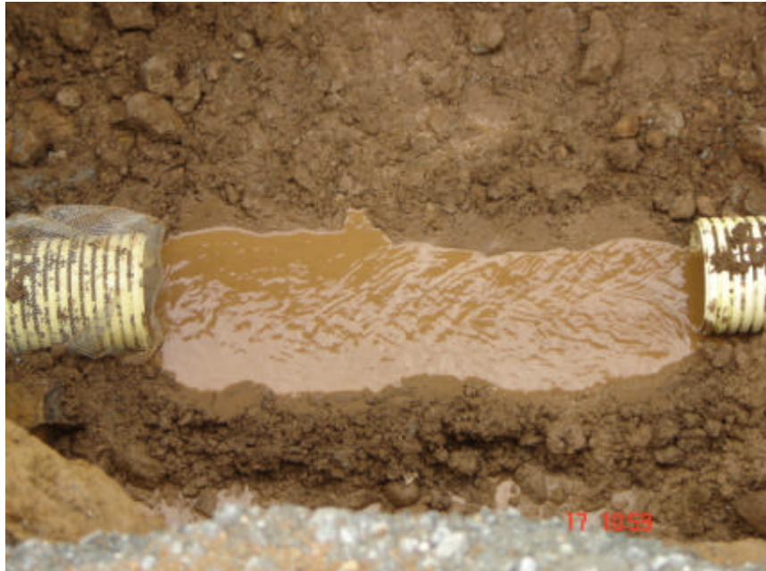
Figura 42. Espacio para pozo
