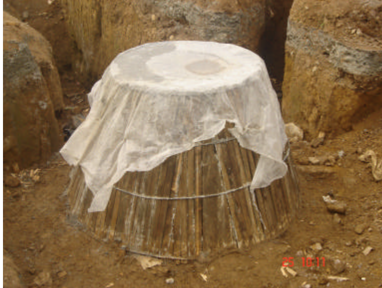
Figura 57. Desencofrado de cono en concreto reforzado
