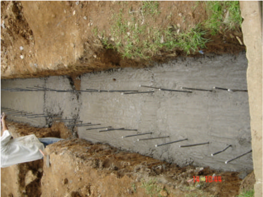
Figura 78. Fundición de piso
