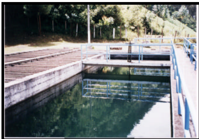
Figura 10. Sedimentadotes
