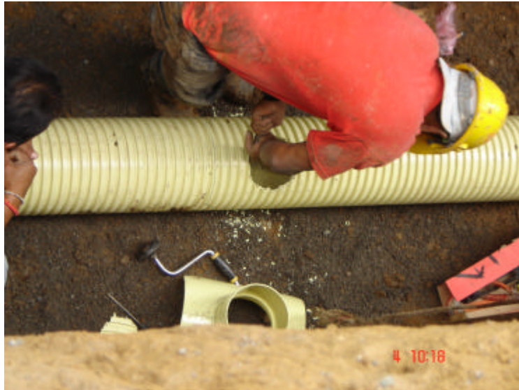
Figura 37. Instalación de silla
