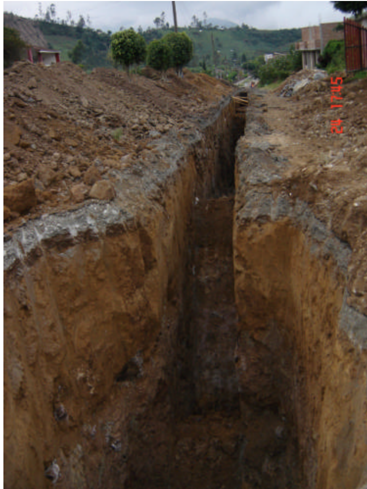
Figura 22. Excavación para pozo
