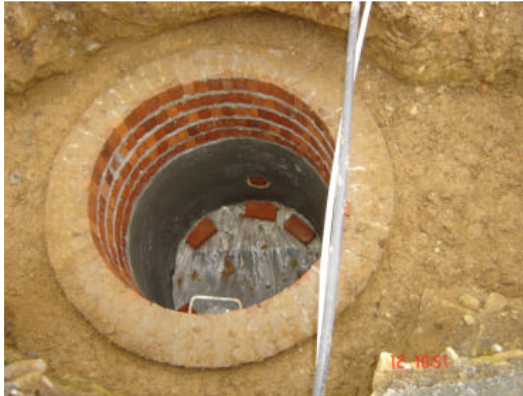
Figura 53. Pozo de inspección
