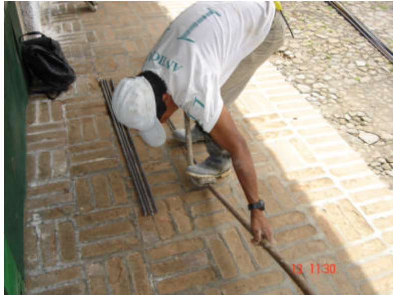
Figura 54 Figurado del acero para conos.
