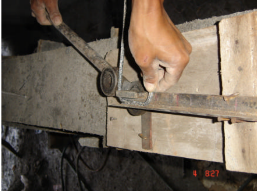
Figura 73. Figurado de acero
