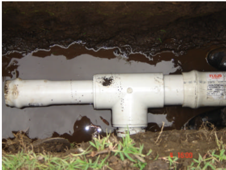
Figura 68. Instalación de tee
