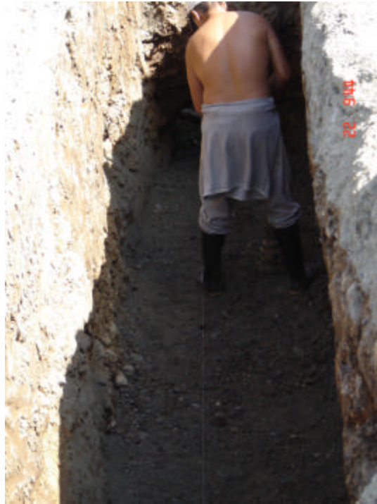
Figura 58. Compactación con pisón
