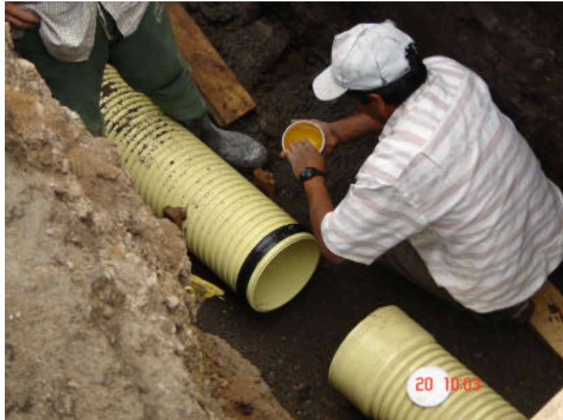
Figura 35. Instalación de tubería
