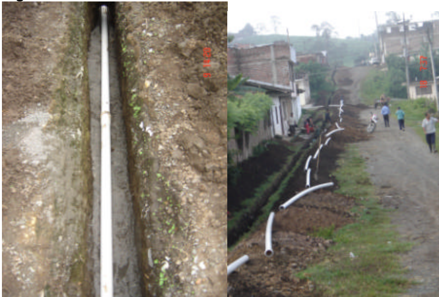
Figura 67. Suministro de tubería
