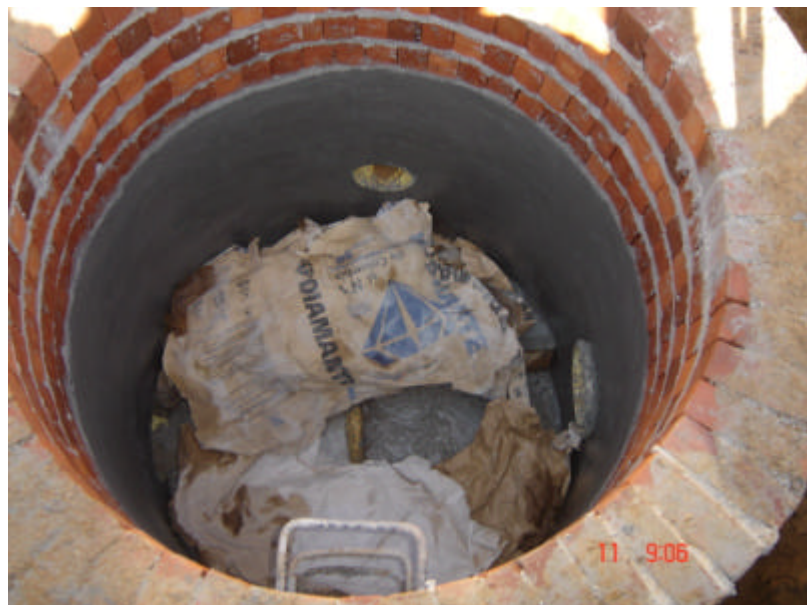
Figura 51. Esmaltado de cámara
