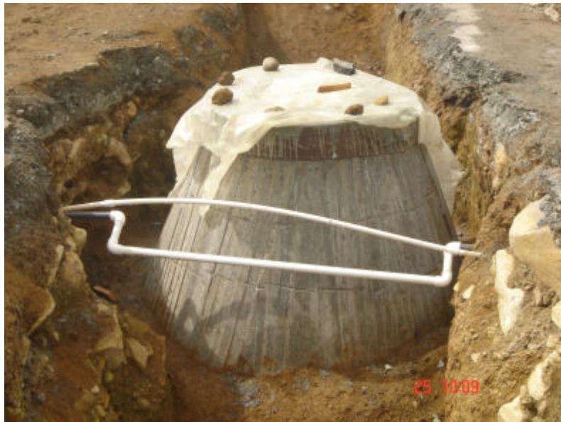
Figura 57. Desencofrado de cono en concreto reforzado
