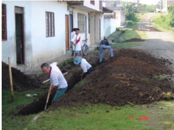
Figura 63. Excavación material común
