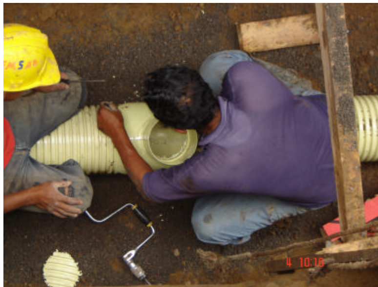
Figura 37. Instalación de silla
