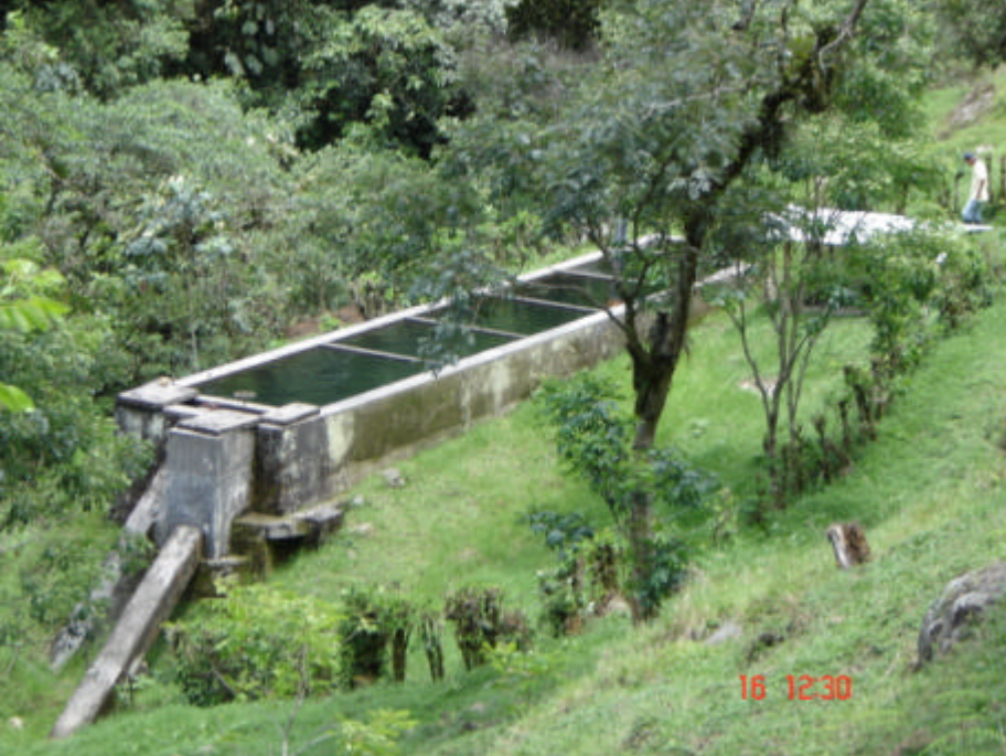
Figura 7. Desarenador
