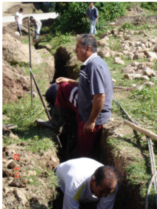
Figura 64. Excavación material conglomerado
