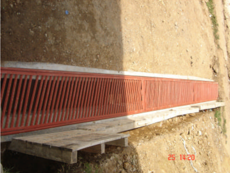
Figura 83. Rejilla instalada 7/8”
