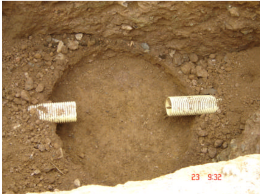
Figura 44. Excavación para solado inferior
