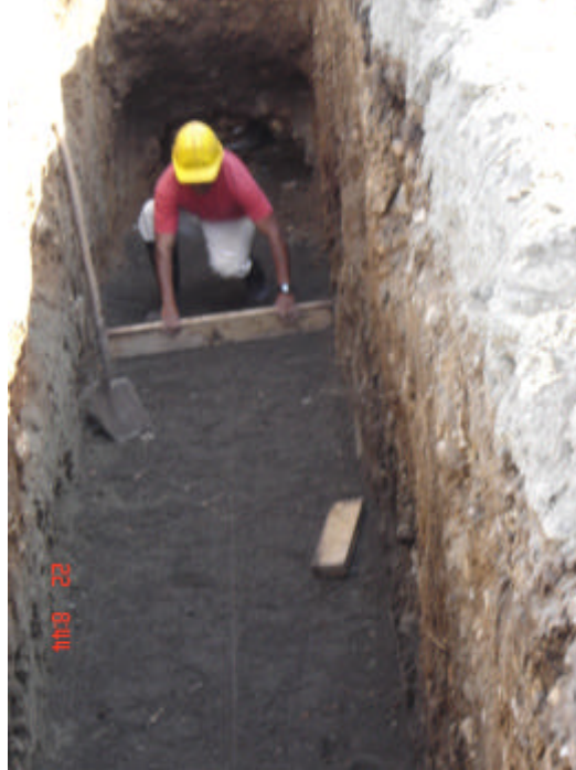
Figura 33. Nivelación de piso con grava y arena
