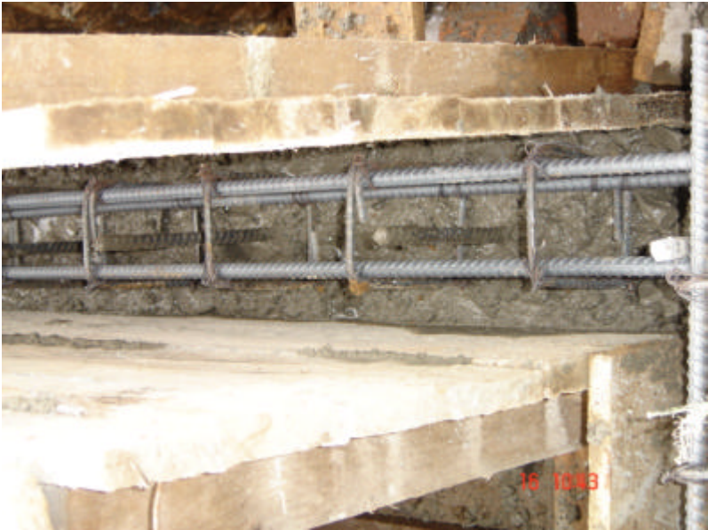
Foto 81. Refuerzo de muros
