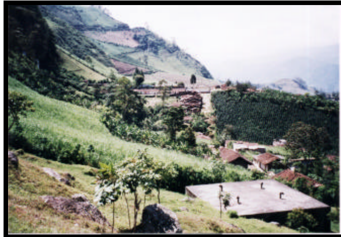
Figura 12. Tanques de almacenamiento
