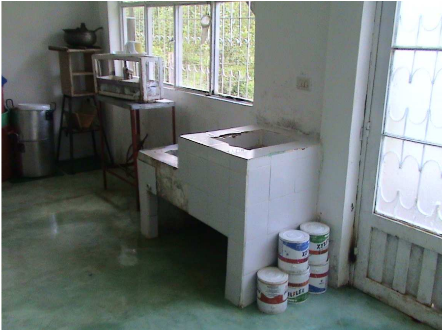
Mesón de lavado (Aseo)
