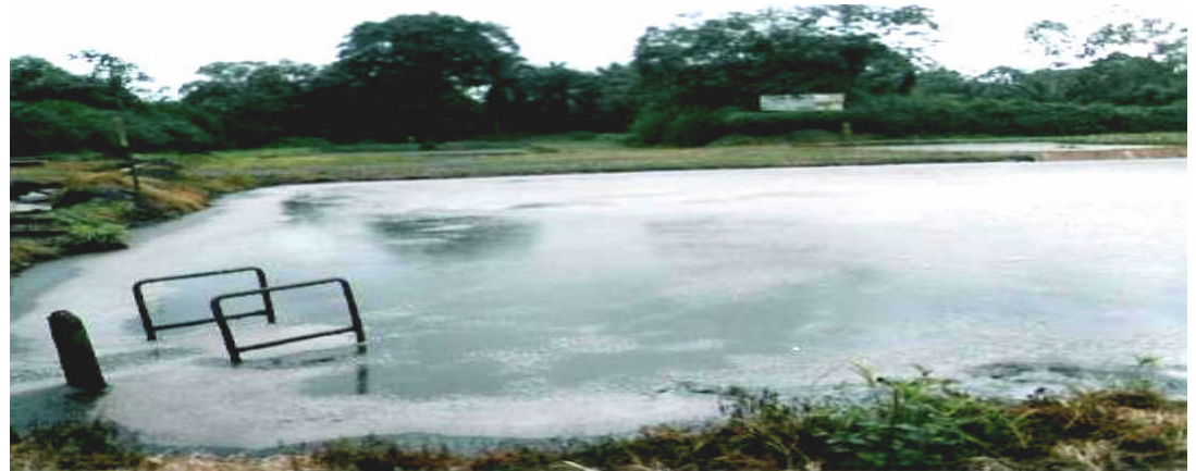
Efluentes en piscina de oxidación
