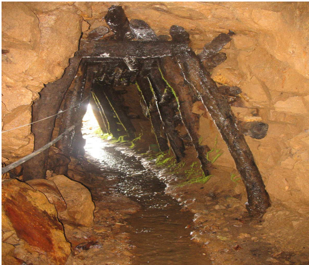
Figura 4. Socavón La Palmera
