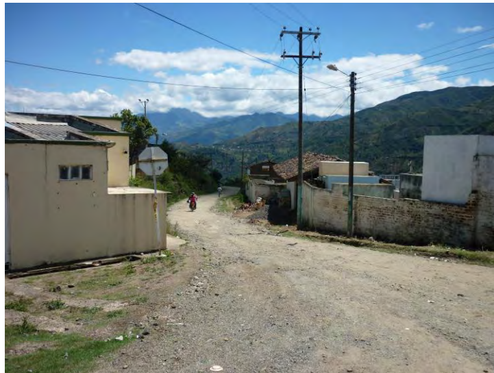
Imagen 50. Vía departamental. Buesaco – Tabón de Gómez
