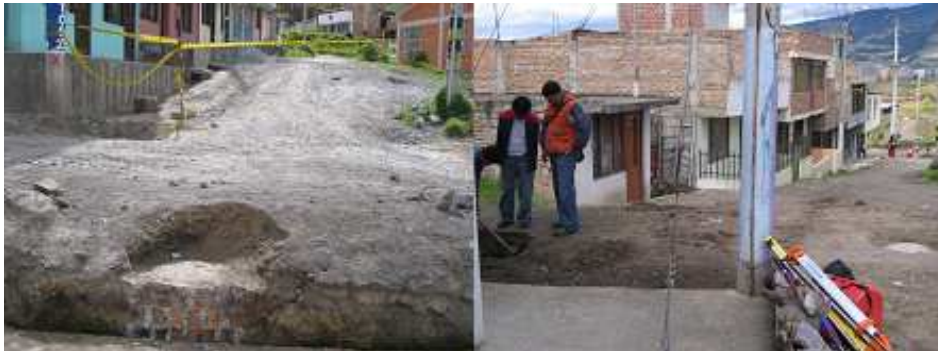
Figura 7.- Cámaras Parte inferior Tramo 2 (Izquierda) - Comisión de topografía (Derecha).
