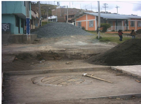
Figura 4.- Vista inferior Tramo 1
