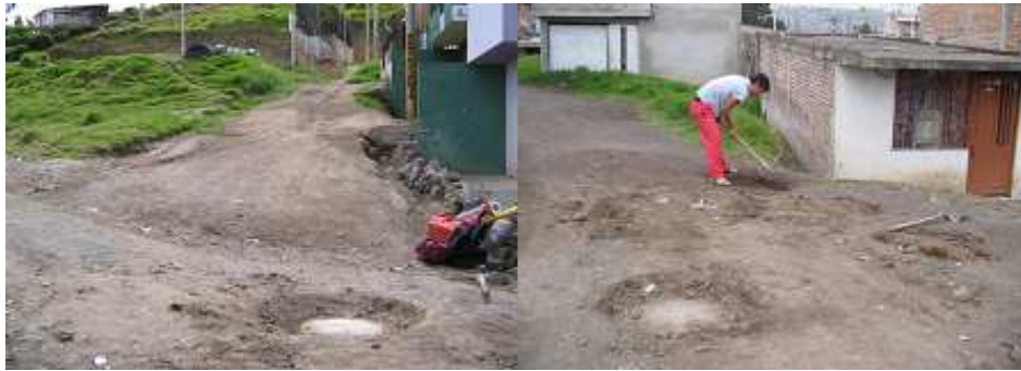
Figura 6.- Cámaras Parte superior Tramo 1.
