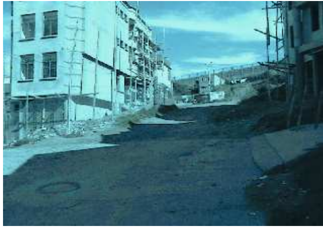
FIGURA 12.- Tramo carrera 1 este la Carolina Alto
