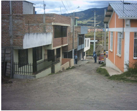
Figura 2.- Vista superior Tramo 1
