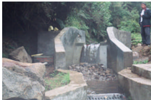
Figura 2 Captación sumergida quebrada La Pila. cabecera Corregimiento de Cabrera
