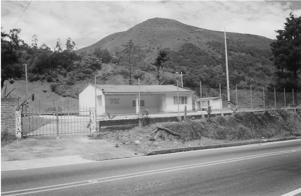
Figura 18. Escuela Zona Rural de Chachagüí.
