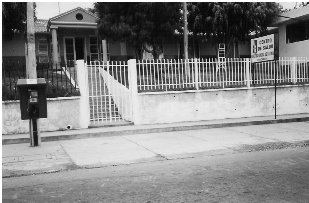
Figura 30. Puesto de Salud Municipal Chachagüí.
