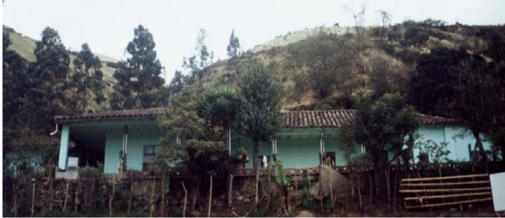
Figura 22. Vivienda antigua construida en adobe
