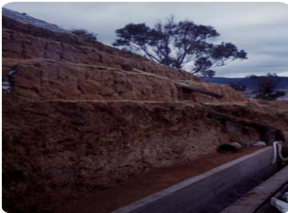
Figura 38. Terminación de obra. Terraceo Planta Centenario.
