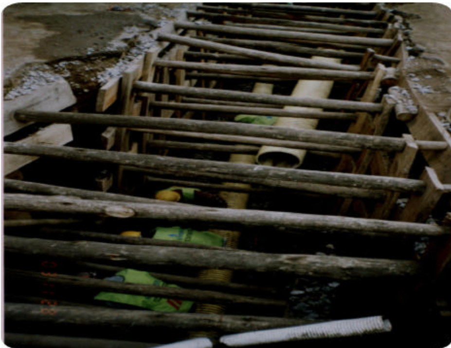
Figura 25. Colocación de filtro y mejoramiento de suelo para alcantarillado Carrera 31C.
