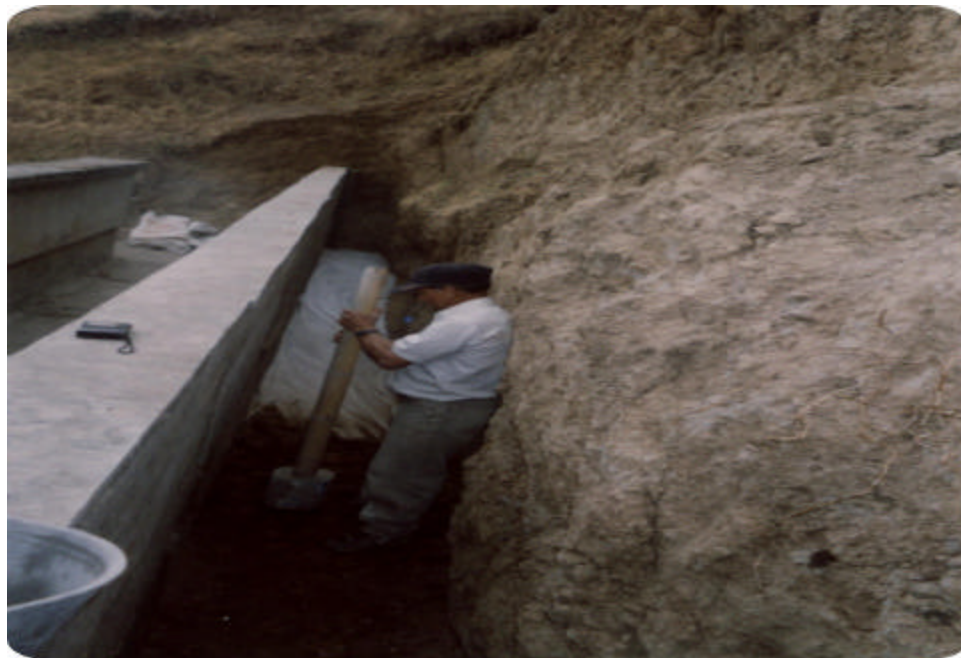
Figura 37. Relleno sobre filtro. Terraceo Planta Centenario.
