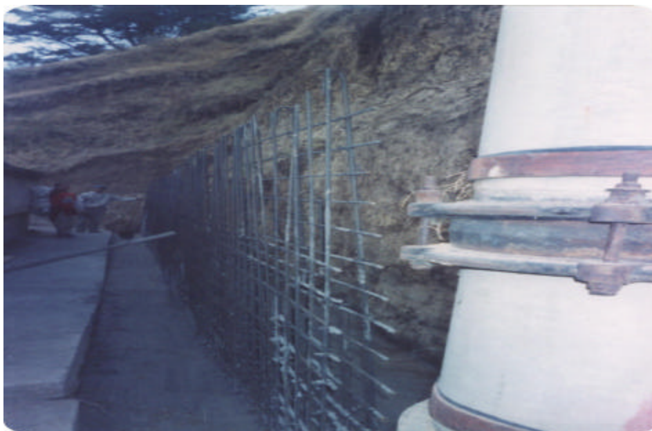
Figura 32. Armado muro de contención de 14 mts. Terraceo Planta Centenario.
