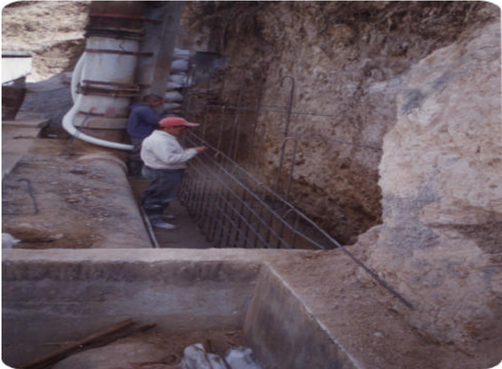
Figura 34. Formaleta muro de contención de 5,5 mts. Terraceo Planta Centenario.
