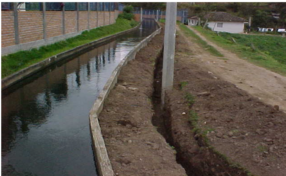
Figura 5. Excavación para filtro.
