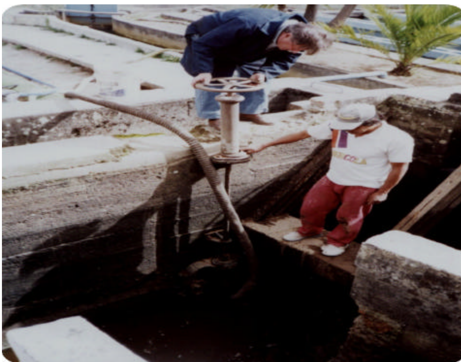
Figura 19. Instalación de la compuerta circular deslizante d=12”
