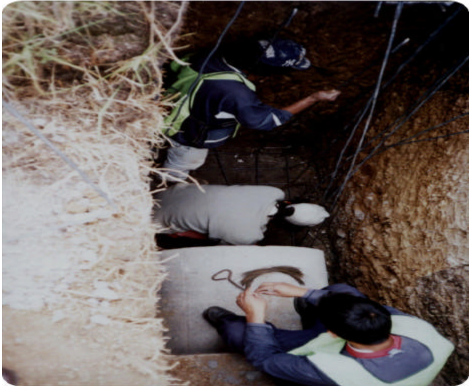
Figura 15. Figuración de hierro instalada la tubería de 24”
