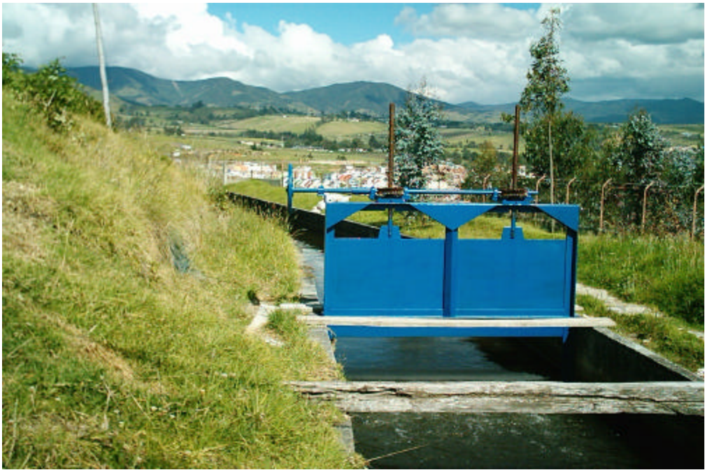
Figura 23. Compuerta tipo guillotina doble vástago
