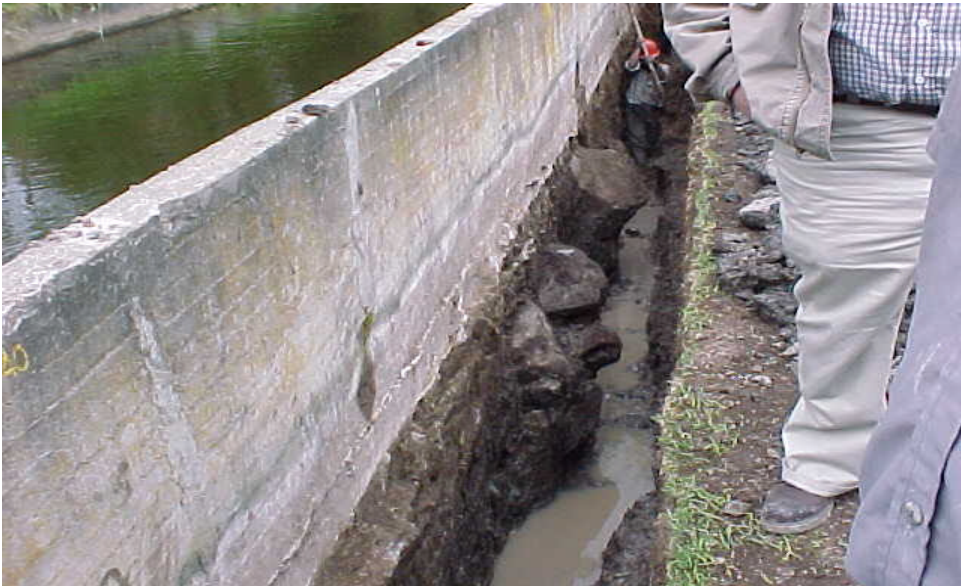
Figura 7. Terminación de excavación del filtro con descole a la cámara de inspección vía Buesaquillo.
