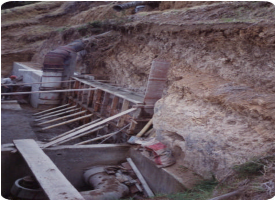
Figura 34. Formaleta muro de contención de 5,5 mts. Terraceo Planta Centenario.
