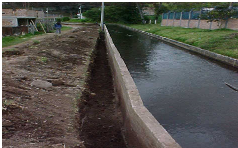
Figura 5. Excavación para filtro.
