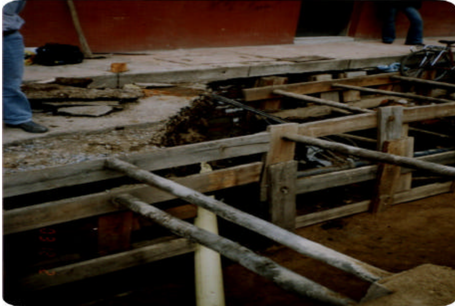
Figura 25. Colocación de filtro y mejoramiento de suelo para alcantarillado Carrera 31C.
