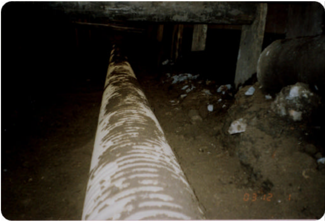
Figura 29. Reparación interna de domiciliaria e instalación de la misma con tubo novafor de 6" incluyendo silla
