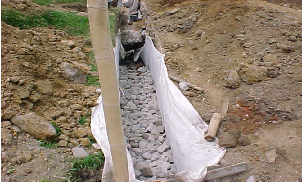
Figura 8. Llenado del filtro con grava de 4”.
