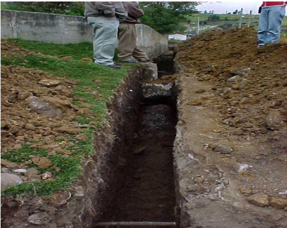
Figura 7. Terminación de excavación del filtro con descole a la cámara de inspección vía Buesaquillo.
