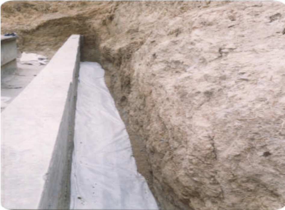
Figura 36. Llenado y tapado de filtro. Terraceo Planta Centenario.
