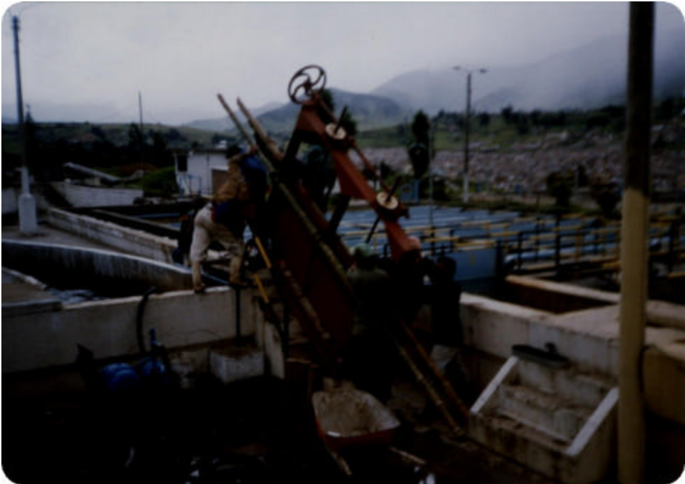
Figura 21. Traslado de la compuerta de guillotina doble vástago
