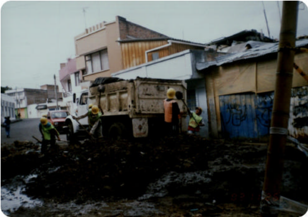
Figura 27. Desalojo. Alcantarillado Carrera 31 C.
