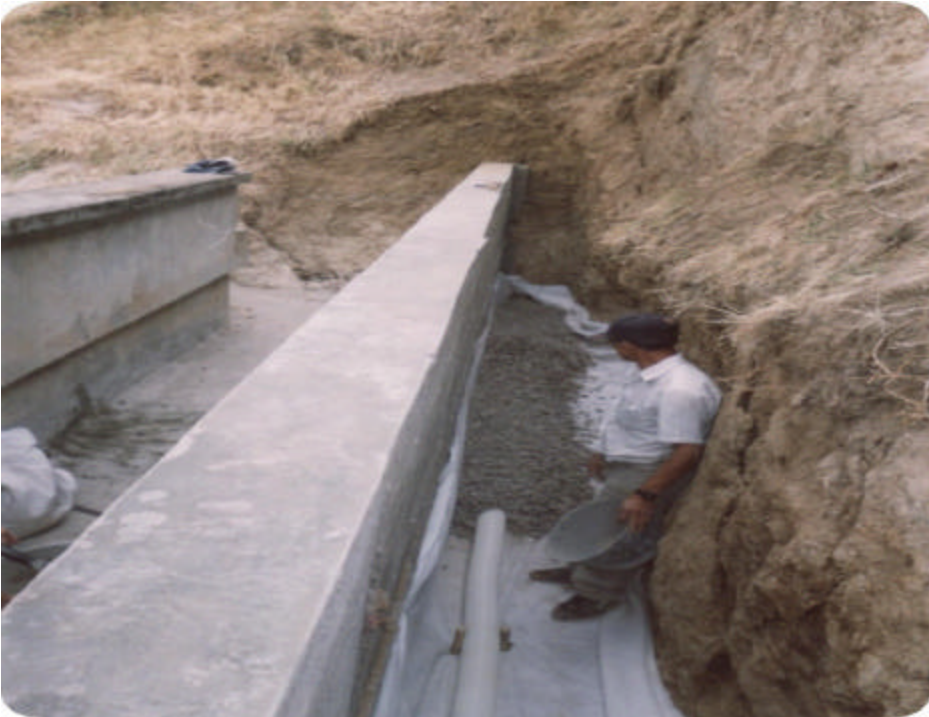
Figura 36. Llenado y tapado de filtro. Terraceo Planta Centenario.
