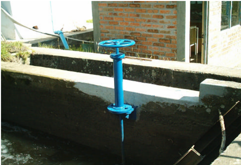
Figura 21. Traslado de la compuerta de guillotina doble vástago
