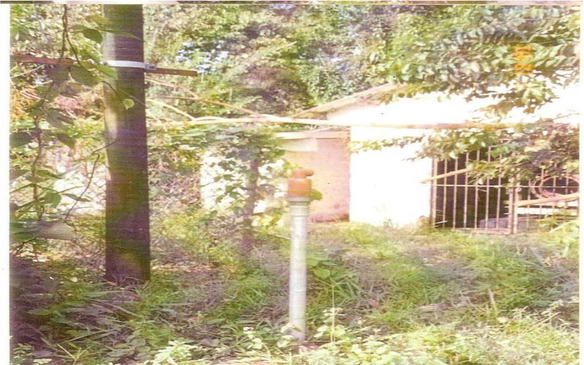
La iluminación de la planta es deficiente, uno de los factores que se presenta es la humedad la que ocasiona cortos circuitos internos frecuentes, otros, la antigüedad del sistema de iluminación y la falta de reflectores.
