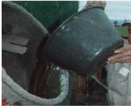
FIGURA 34 AGREGANDO ADITIVO TOXEMEN
