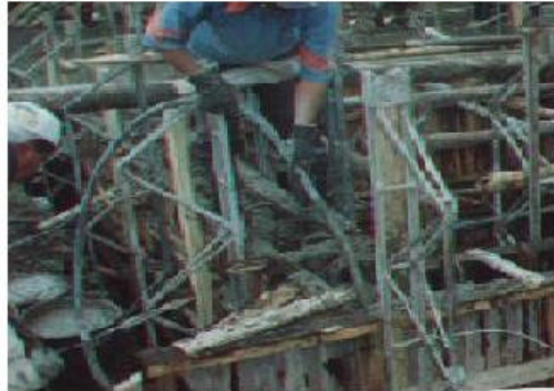
FIGURA 18 FUNDICION DE PAREDES
