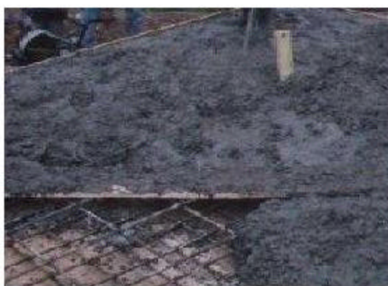
FIGURA 57 FUNDICION DE LA TAPA
