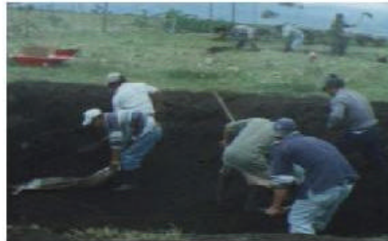
FIGURA 2 DESCAPOTE Y LIMPIEZA
