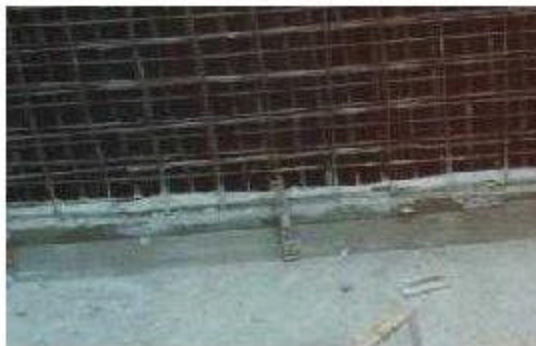
FIGURA 56 FUNDICION DE PLACA DE PISO
