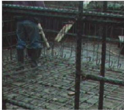
FIGURA 62 AMARRADO DEL ACERO DE REFUERZO
