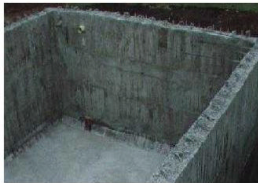
FIGURA 35 FUNDICION DE PAREDES
