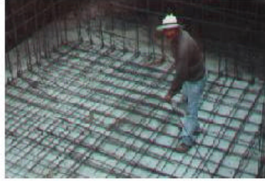
FIGURA 49 ARMADO DEL ACERO DE REFUERZO
