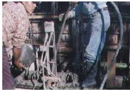
FIGURA 43 FUNDICION DE PAREDES
