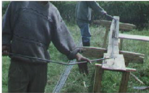
FIGURA 6 CORTE Y FIGURADO DE ACERO
