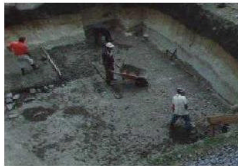
FIGURA 40 FUNDICION DE CICLOPEO
