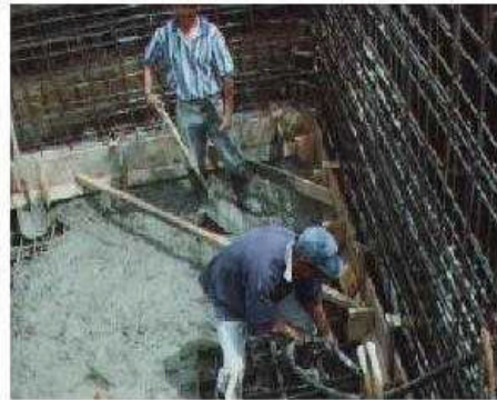
FIGURA 26 FUNDICION PLACA DE PISO
