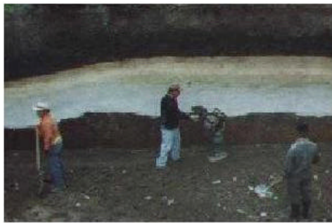
FIGURA 39 RELLENO Y APISONADO
