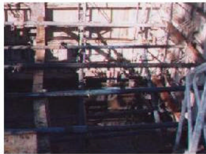
FIGURA 51 FUNDICION DE PAREDES
