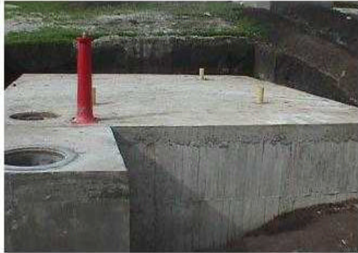
FIGURA 20 TERMINACION FINAL DEL TANQUE
