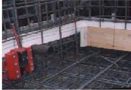
FIGURA 41 ARMADO DEL ACERO Y COLOCACION DE ACCESORIOS
