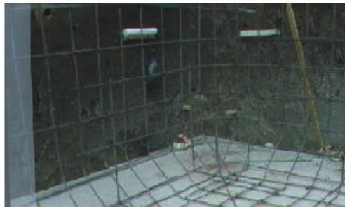
FIGURA 7 ARMADO DEL ACERO DE REFUERZO
