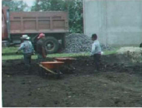
FIGURA 37 DESCAPOTE Y LIMPIEZA
