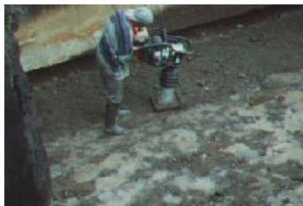
FIGURA 4 RELLENO Y APISONADO
