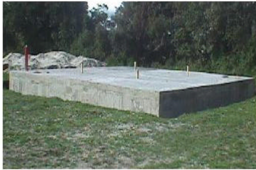
FIGURA 44 TERMINADO FINAL DEL TANQUE
