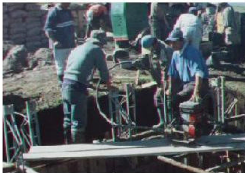
FIGURA 10 FUNDICIÓN DE PAREDES
