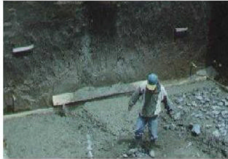
FIGURA 5 FUNDICION DE CICLOPEO
