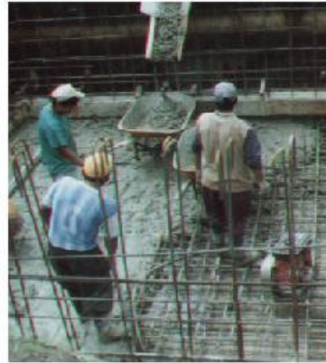
FIGURA 50 FUNDICION PLACA PISO
