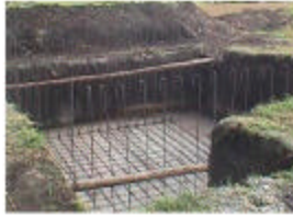
FIGURA 55 ARMADO DEL ACERO
