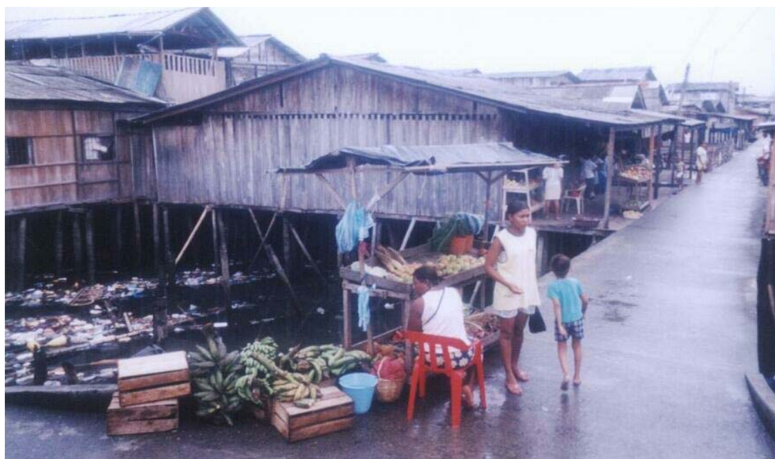
Foto 3. Vista general del Puente de entrada al barrio Las Flores.
