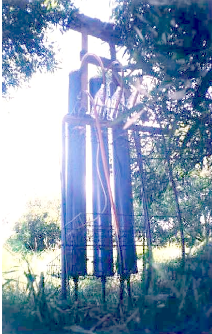
Vista posterior de los reactores de lecho fijo de flujo ascendente, ubicados en la Sede de CORPONARIÑO, Pasto.
