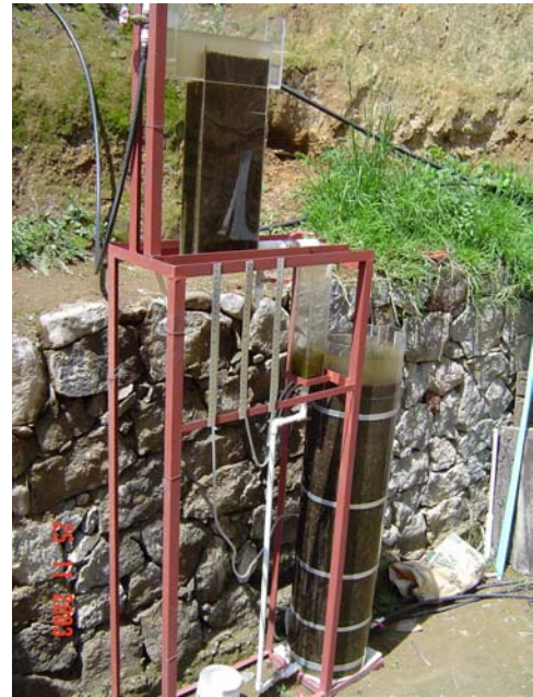
Figura 6. Filtro piloto en funcionamiento
