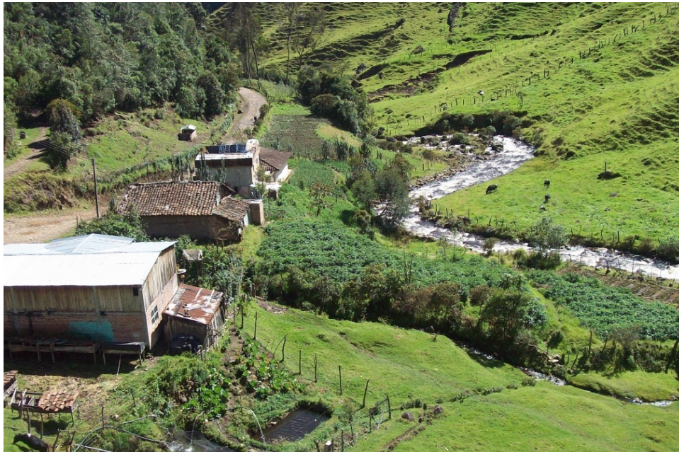
Figura N° 3 Acequia conectora al río para descarga de aguas residuales, vista frontal.
