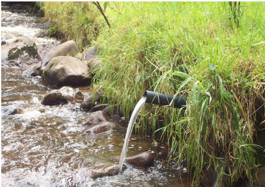
Figura N° 6 Descarga de aguas residuales a través de tubería , vista lateral
