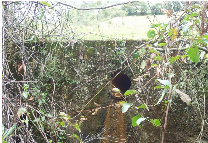
Figura N° 6 y 7 Alcantarillado del corregimiento de Rosal del Monte ubicado en la parte aledaña a la corriente principal, vista frontal
