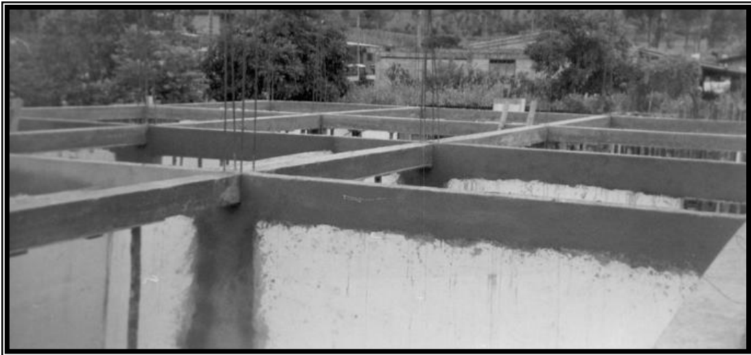
Figura 39. Viga aérea fundida
