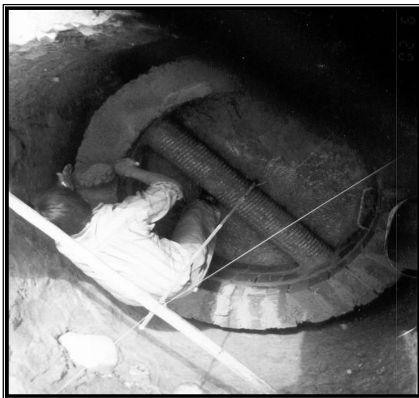
Figura 7. Construcción cámara de inspección
