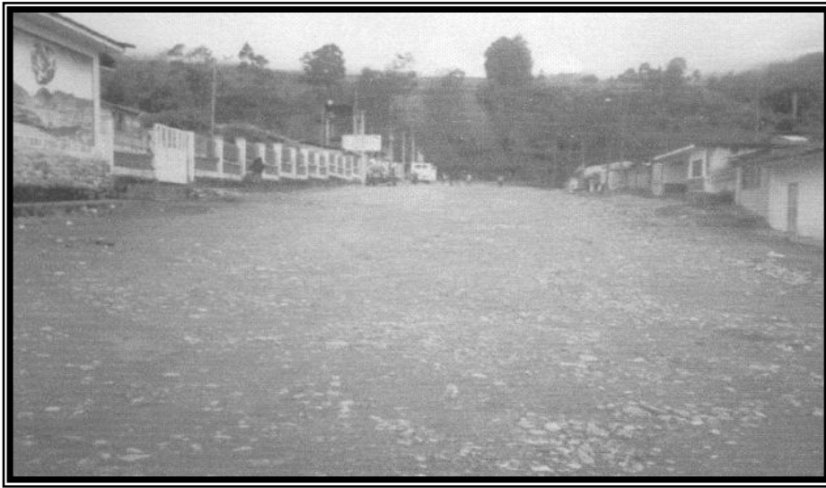
Figura 2. Tramo a excavar
