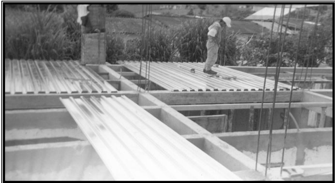
Figura 41. Instalación corpalosa
