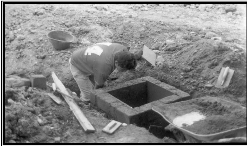
Figura 11. Construcción cajilla en mampostería
