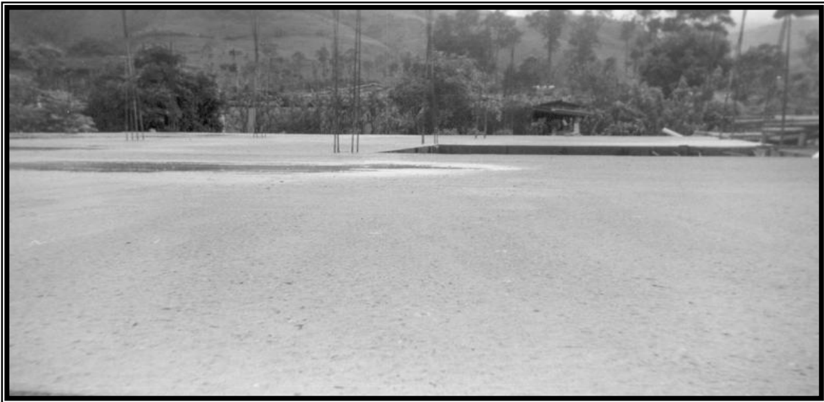
Figura 44. Losa de entrepiso fundida
