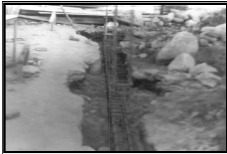
Figura 30. Refuerzo viga de cimentación
