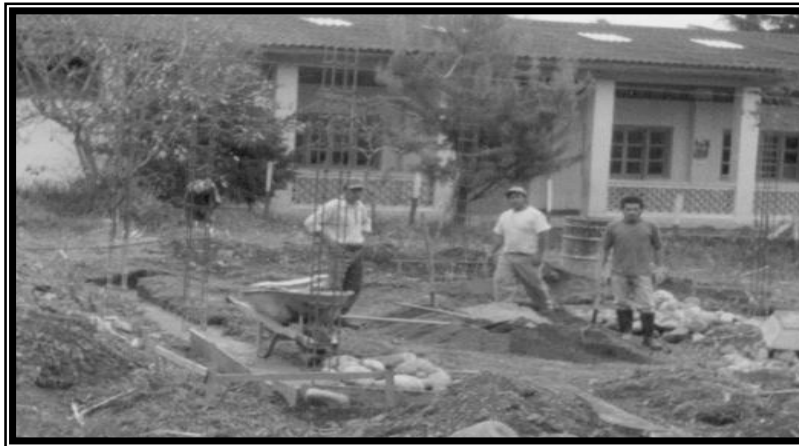
Figura 18. Cimentación concreto ciclópeo
