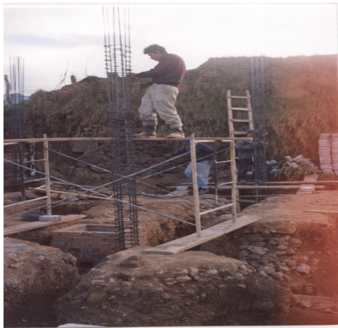
Figura 7. Instalación de flejes en columnas.
