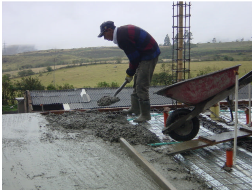
Figura 18. Fundición de placa de entepiso
