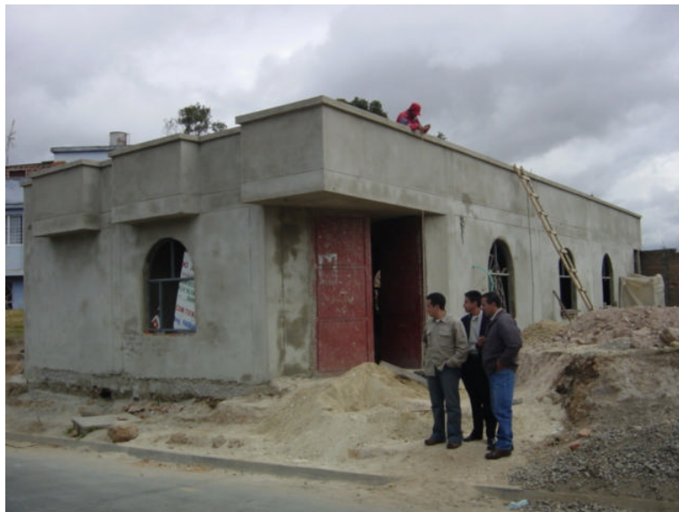
Figura 27. Mampostería superior y repellos exteriores
