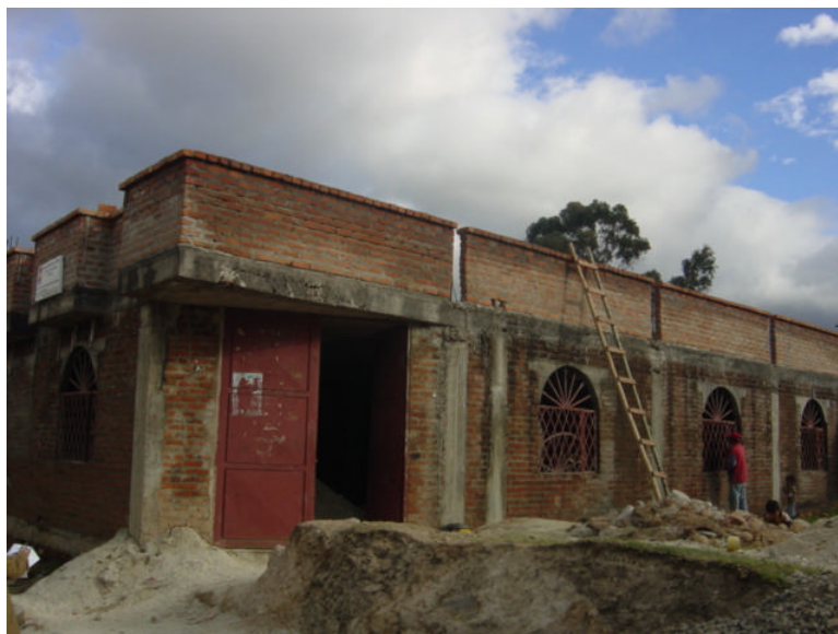
Figura 26. Estado exterior anterior
