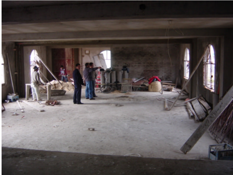
Figura 25. Inicio de trabajos de instalaciones sanitarias y acabados
