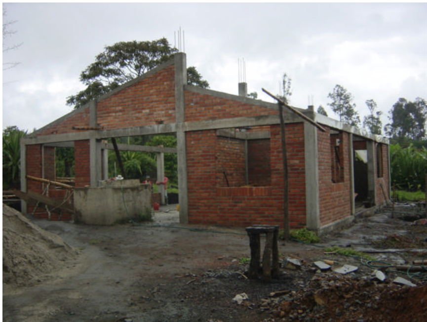
Figura 28. Estado de avance de la obra hasta la fecha.
