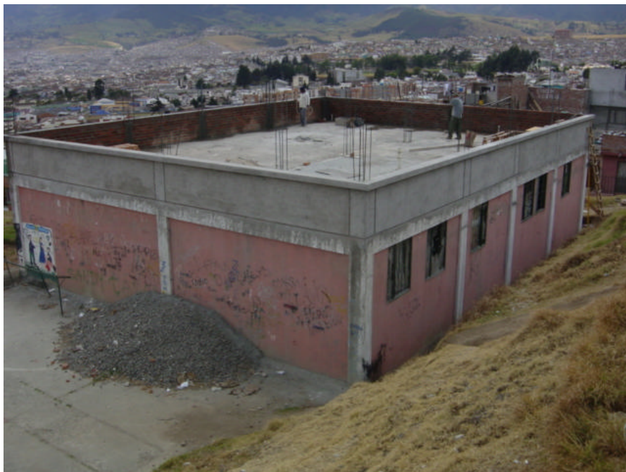
Figura 10. Cubierta para tratamiento con Sika Latex
