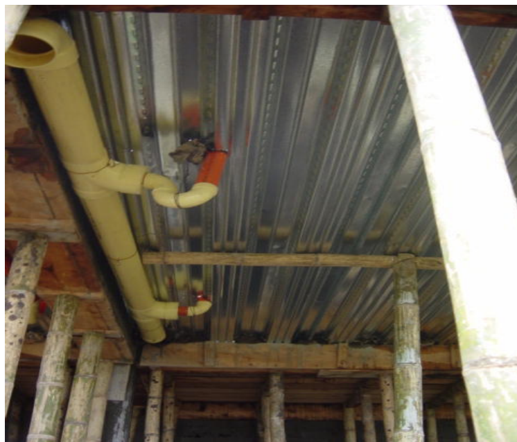
Figura 19. Instalación red sanitaria
