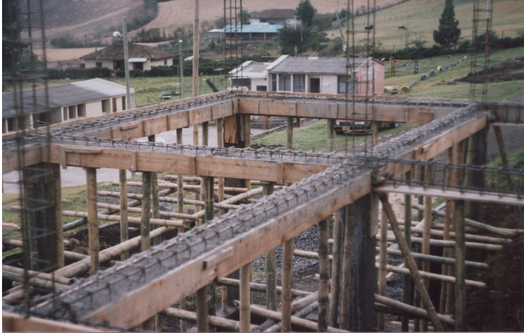
Figura 18. Fundición de placa de entepiso
