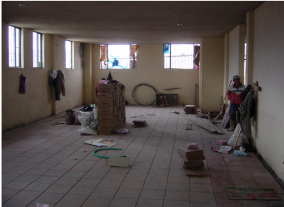
Figura 12. Instalación tablón Gress 30x30
