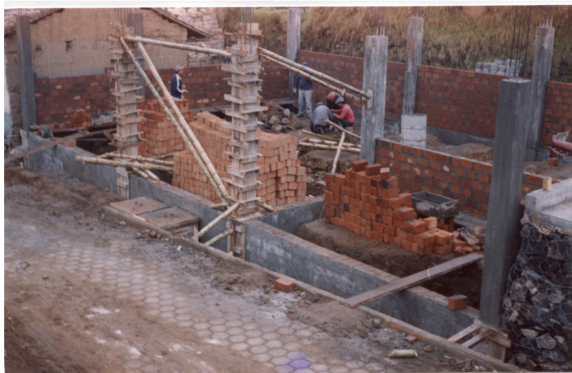
Figura 9. Mampostería y desformaletado de columnas
