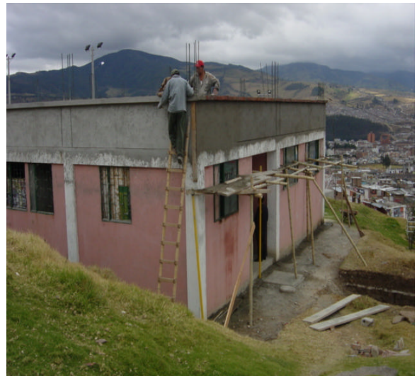
Figura 14. Repello muros exteriores
