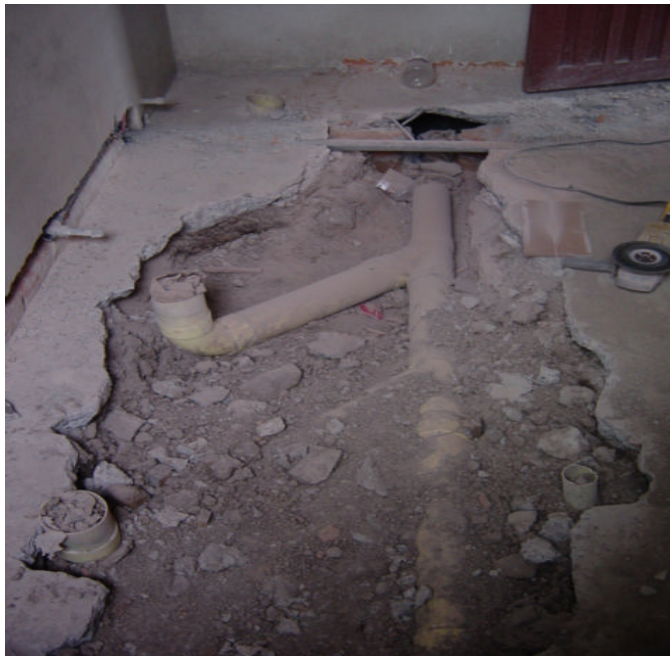
Figura 11. Instalación red sanitaria.
