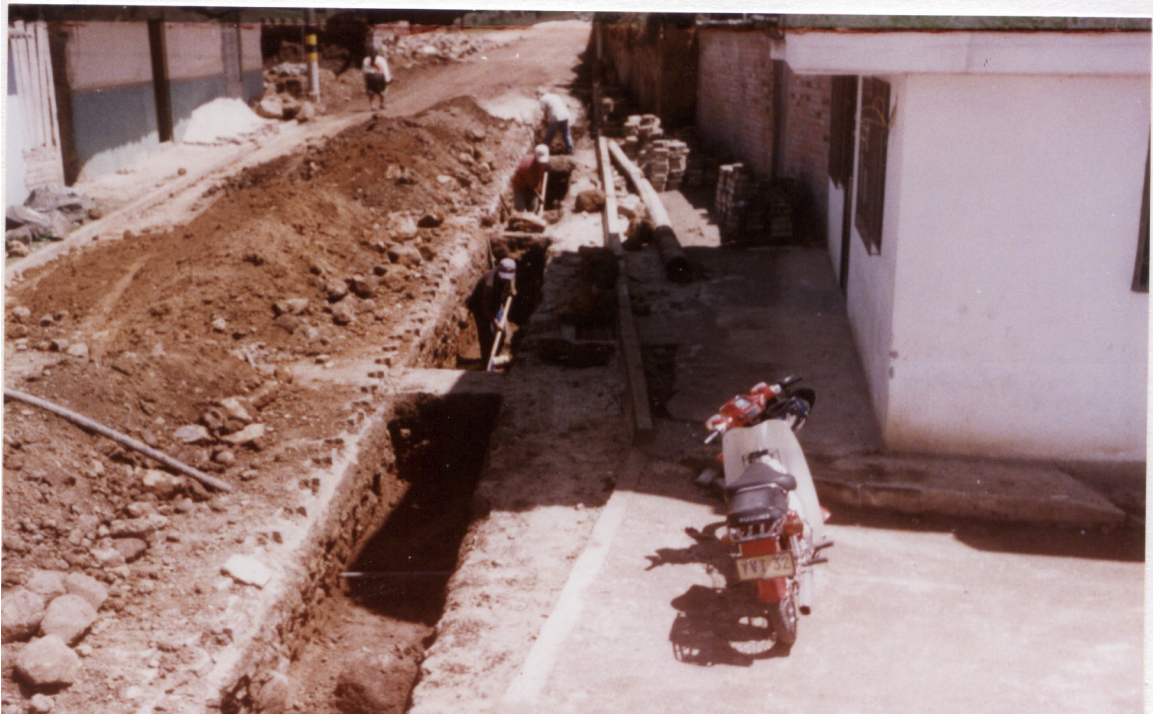
Figura 0. Excavación para instalación de tubería.
