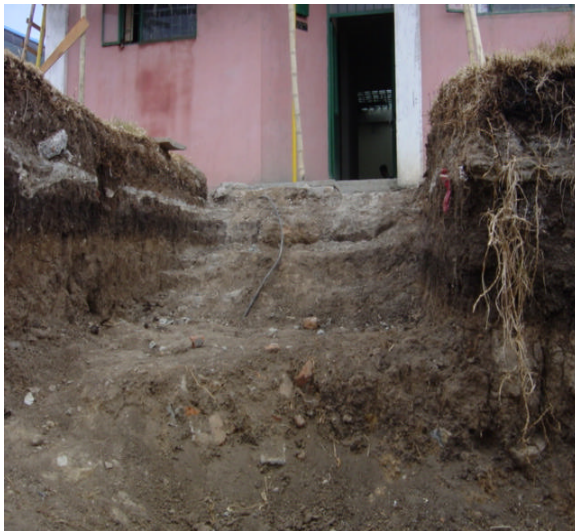
Figura 13. Excavación para escaleras de acceso
