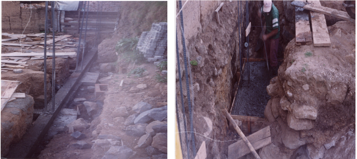
Figuras 5 y 6. Fundición de Zapatas y vigas de cimentación
