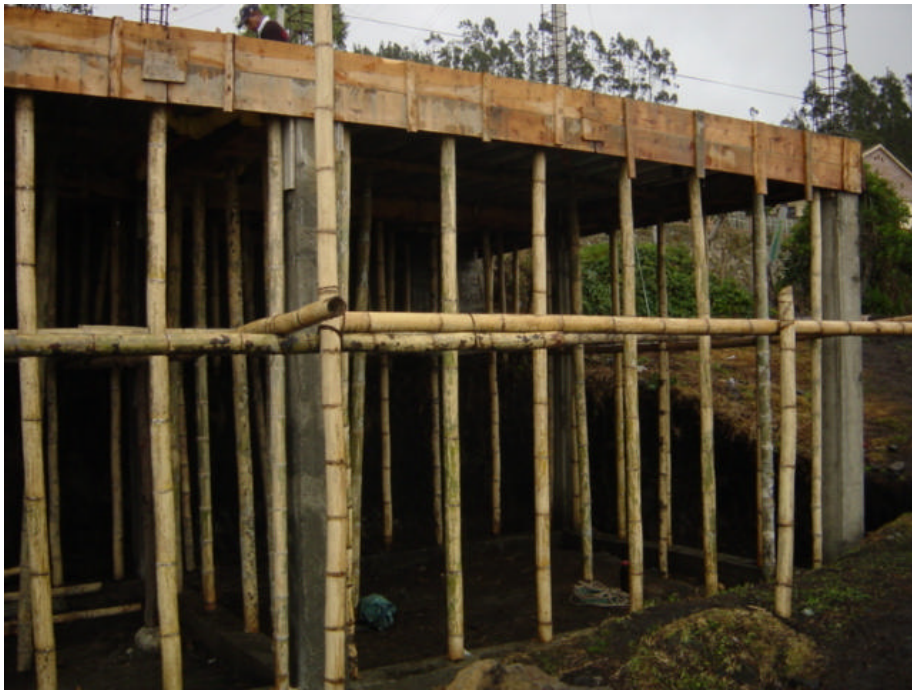
Figura 16. Formaleteo y apuntalamiento vigas y placa de entrepiso
