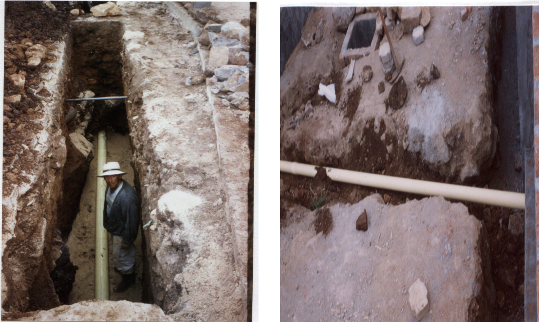
Figuras 1 y 2. Instalación Tubería Novaform
