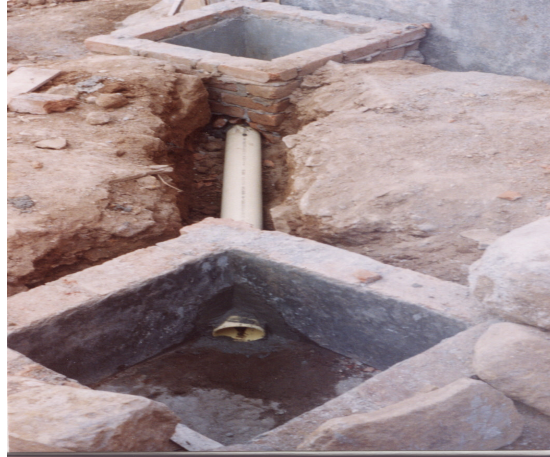
Figura 3. Cajas de inspección
