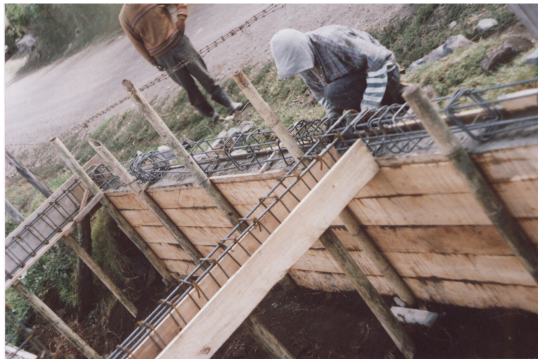
Figura 15. Muro de contención y viga de amarre
