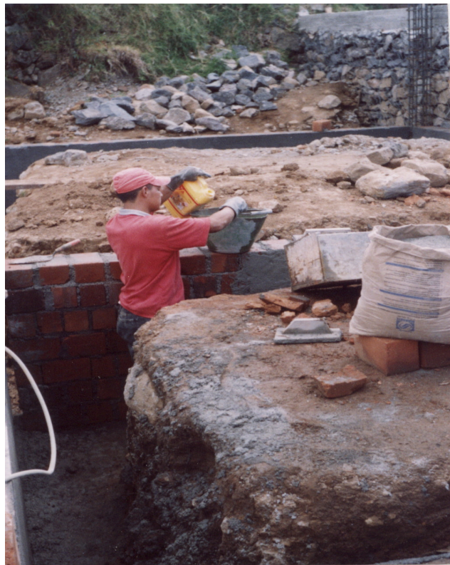
Figura 8. Sobrecimiento con pañete impermeabilizado
