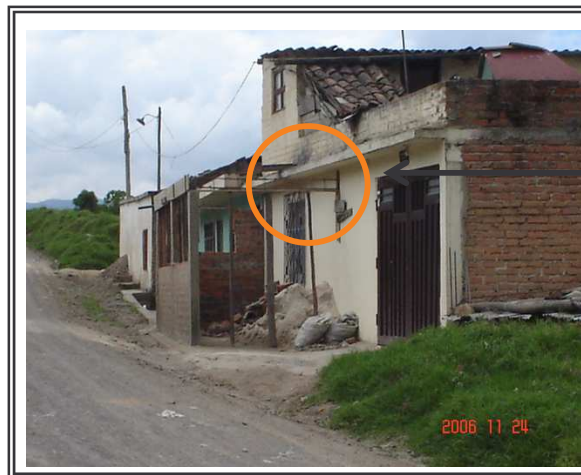
Figura 12. Construcción en Espacio Público
