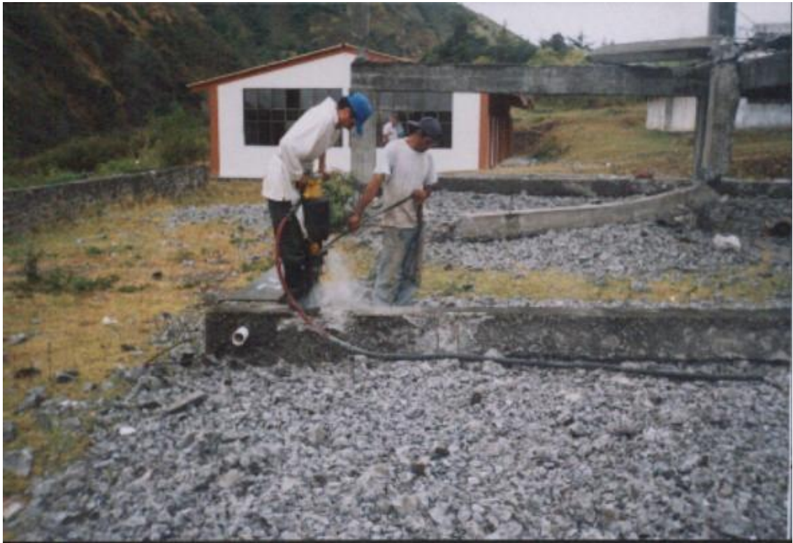
Figura 46. Demolición de pórticos vigas y columnas
