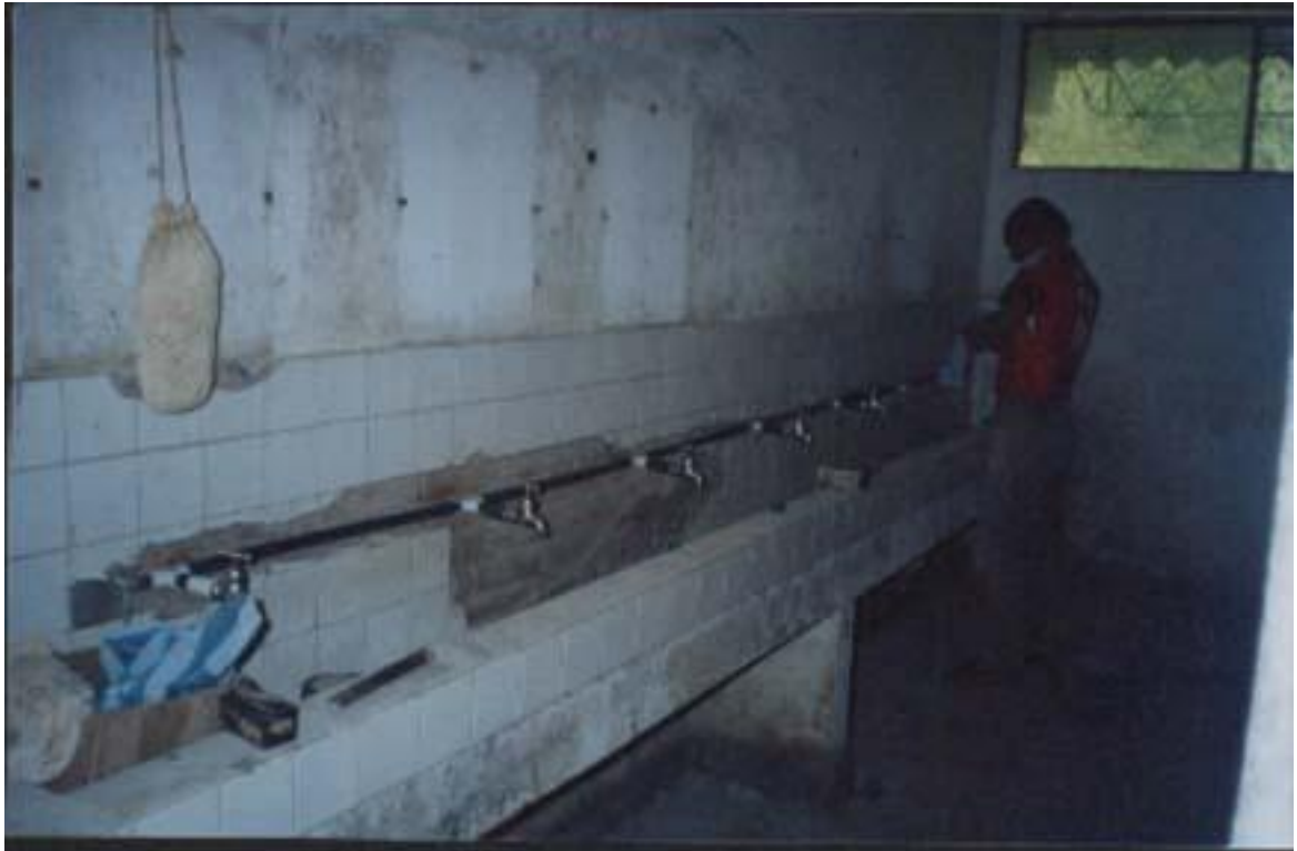
Figura 19. Reposición de toda la tubería y accesorios
