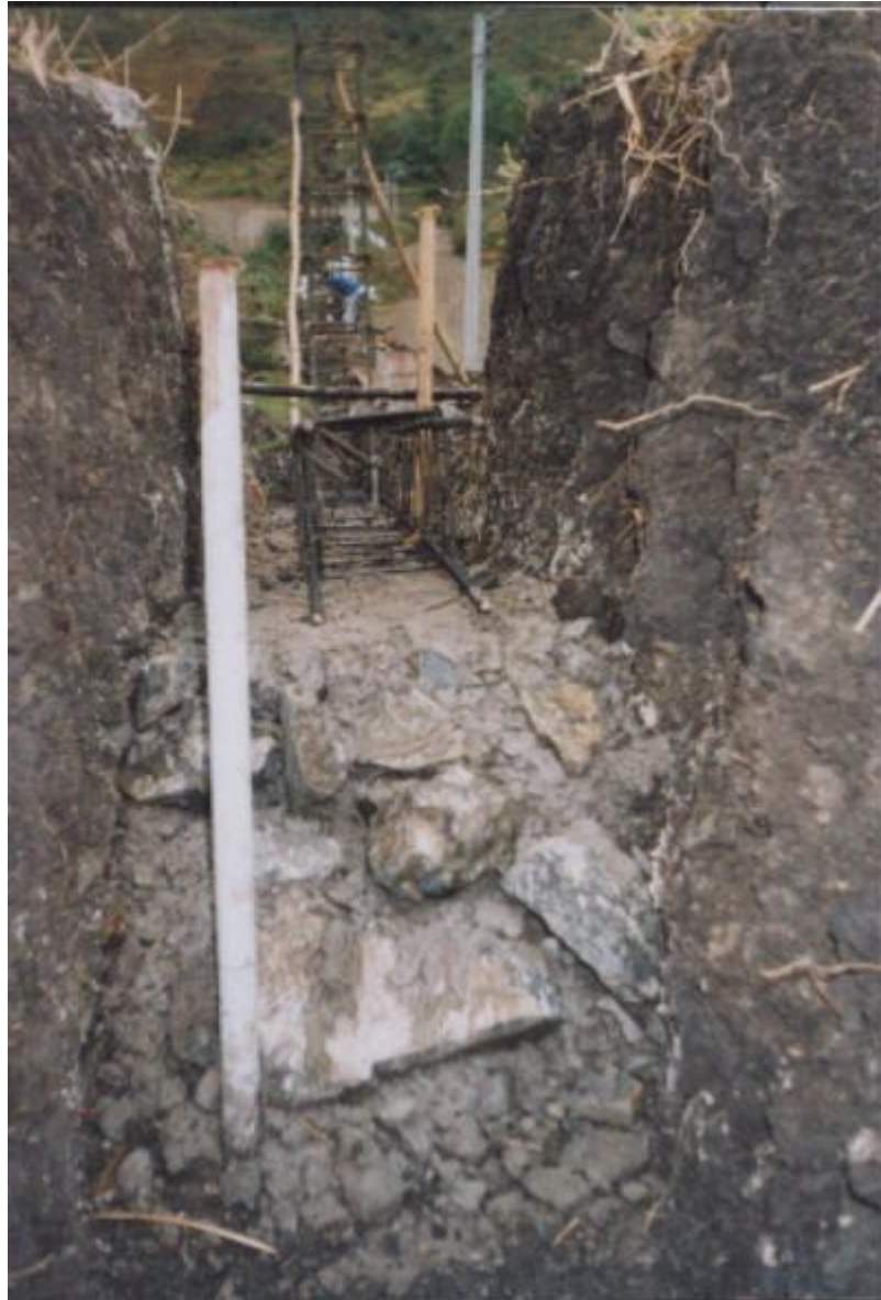
Figura 39. Concreto ciclópeo, viga de amarre y columnas antes de fundir
