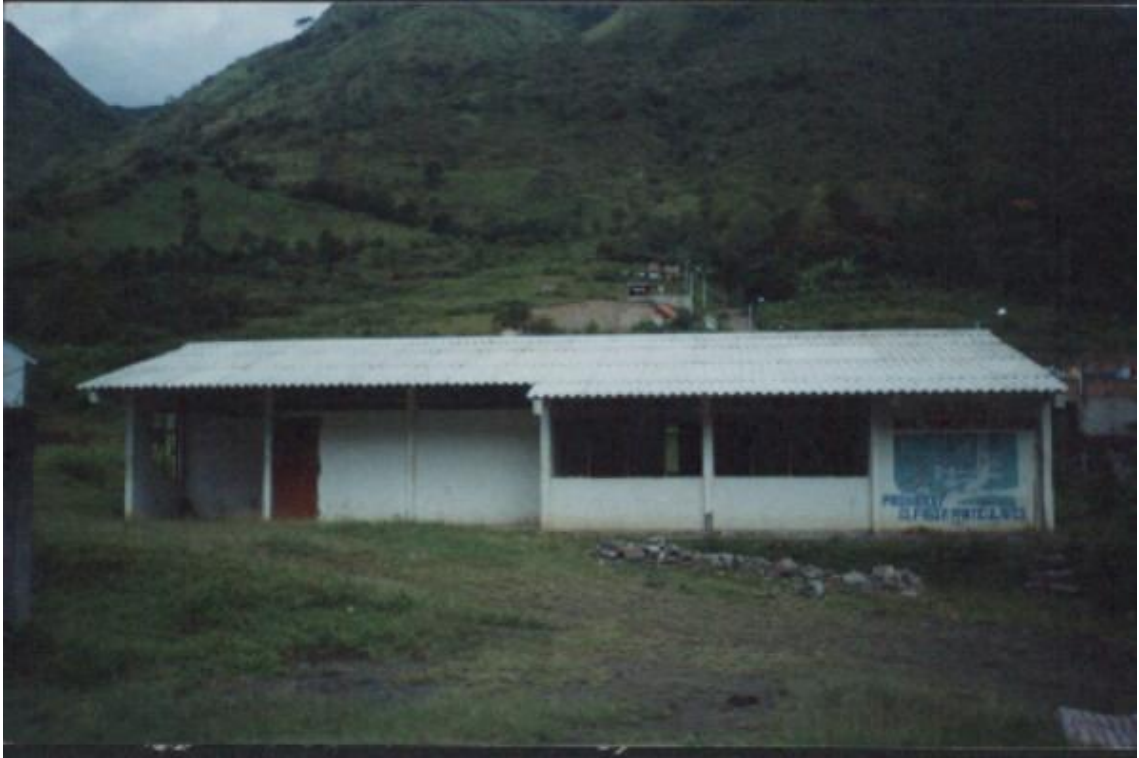
Figura 3. Cubierta bloque administrativo reparada y limpia
