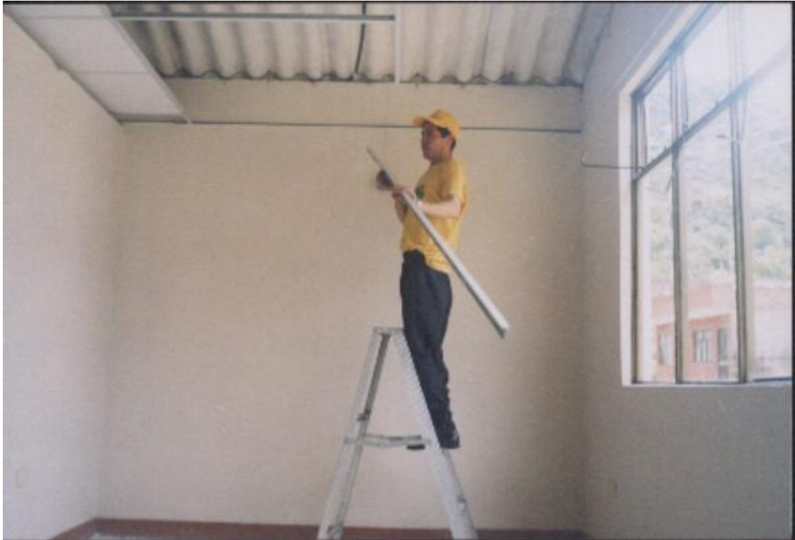
Figura 36. Instalación cielo raso falso
