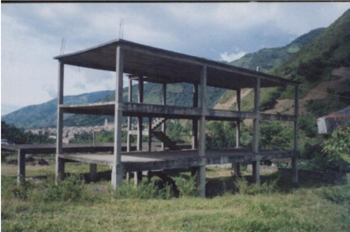
Figura 42. Estructura de concreto existente
