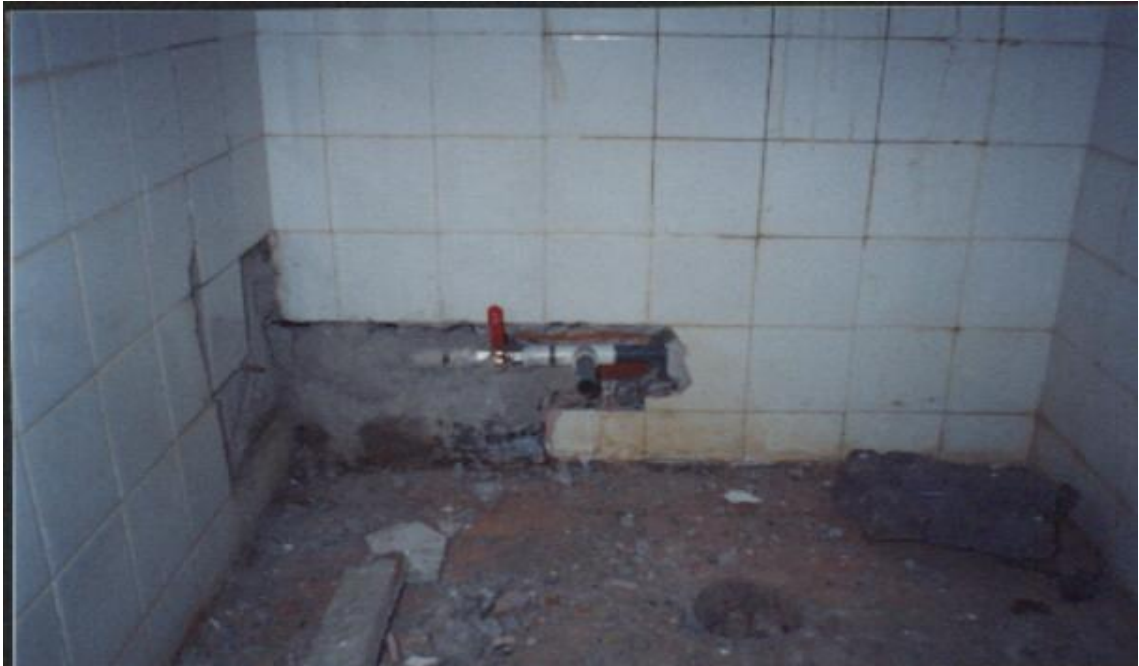
Figura 20. Instalación de llaves de paso en batería sanitaria
