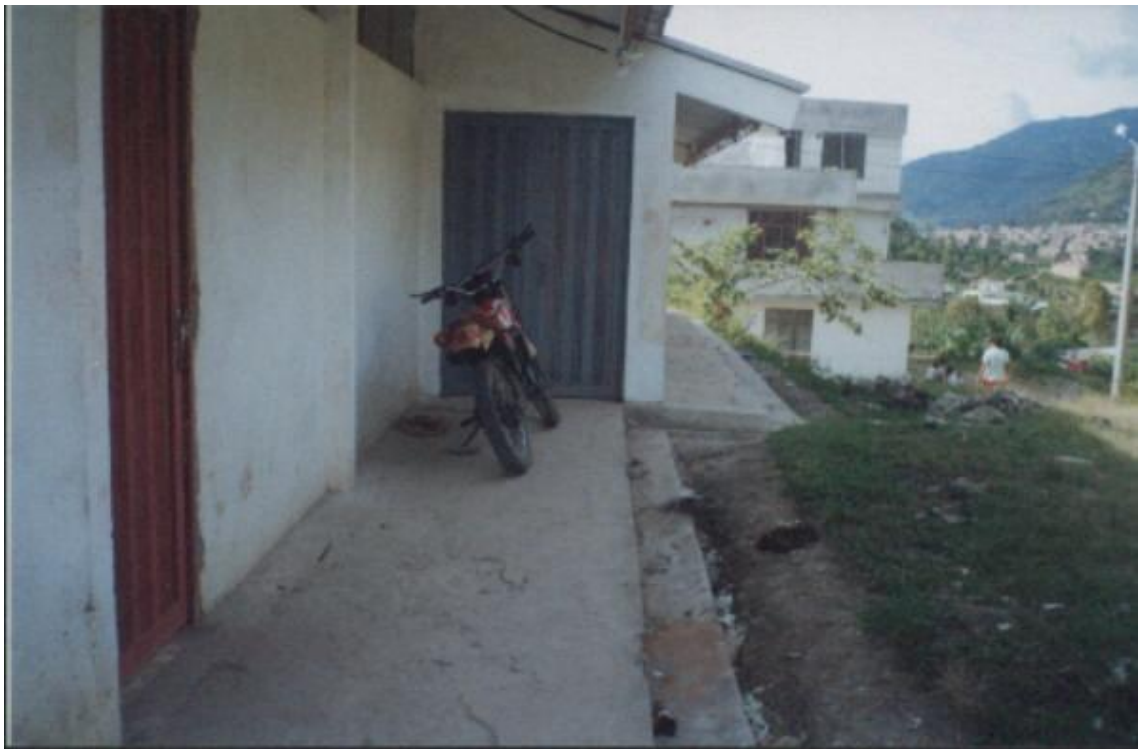
Figura 38. Fundición de anden y cañuela Bloque Administrativo
