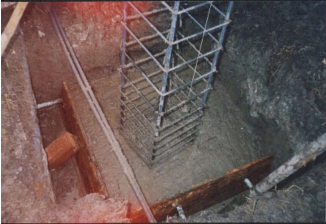
Figura 40. Zapata de columna portón principal de acceso.
