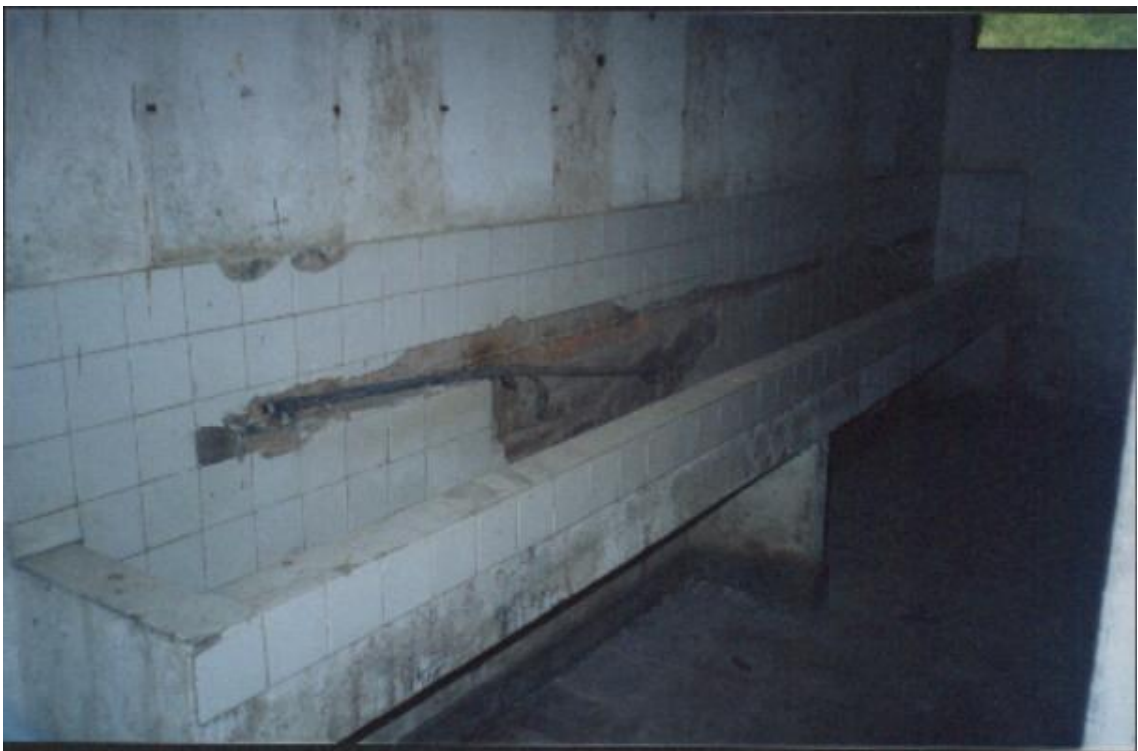
Figura 18. Instalaciones hidráulicas iniciales en lavamanos
