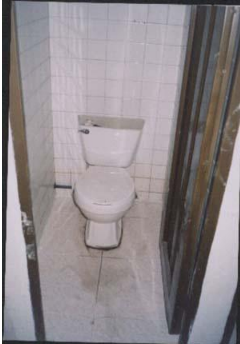
Figura 32. Enchape azulejo, cerámica de piso y colocación de sanitarios
