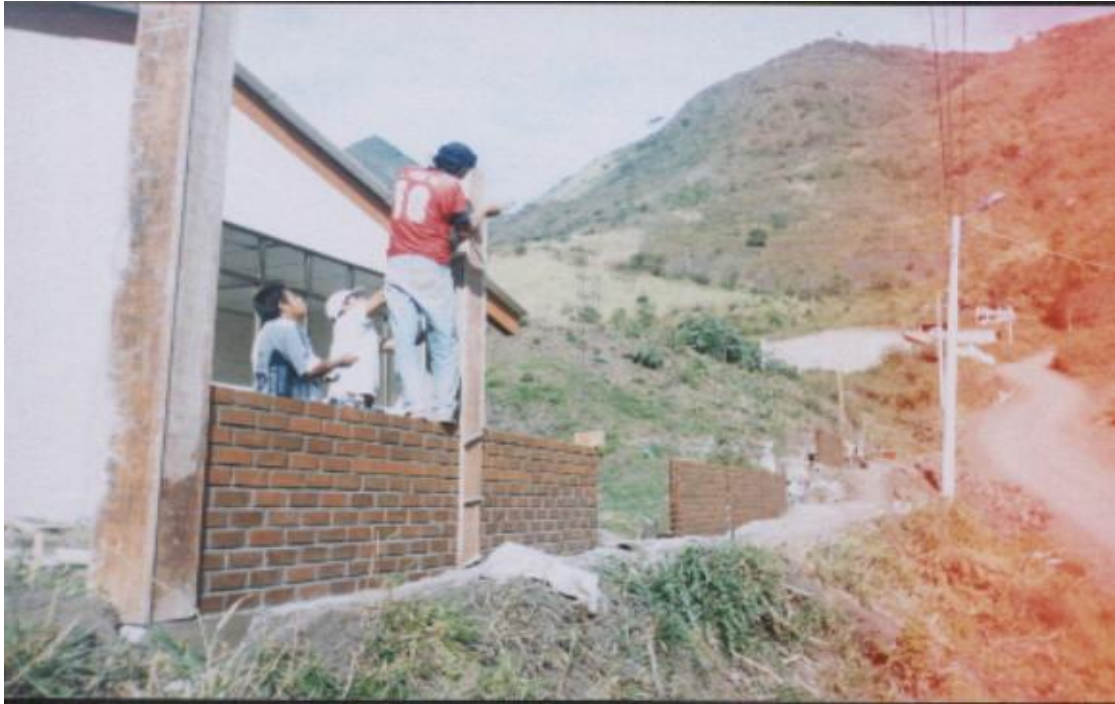
Figura 37. Cerramiento ladrillo y malla, formaleteo de columnas.
