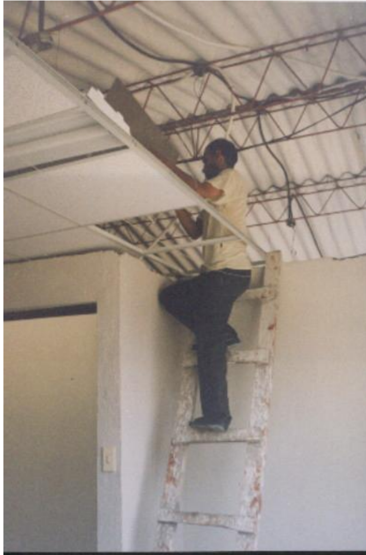
Figura 35. Instalación cielo raso Bloque Administrativo
