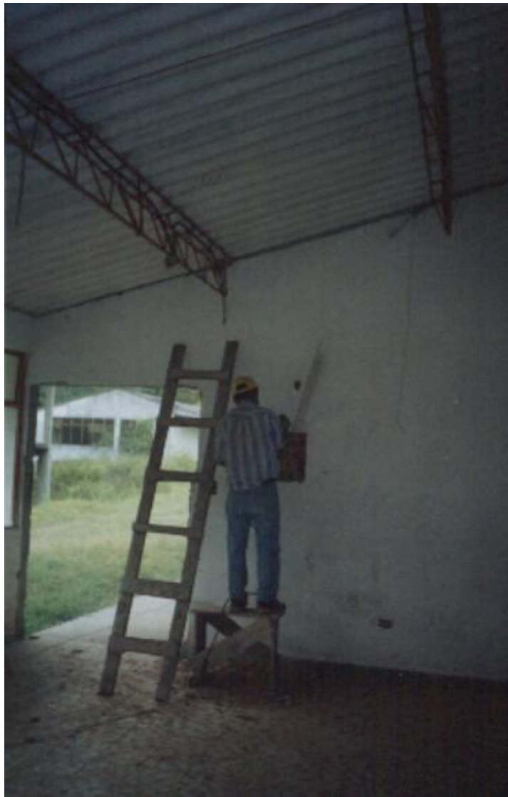
Figura 14. Regatas para la instalación del tablero general de cargas
