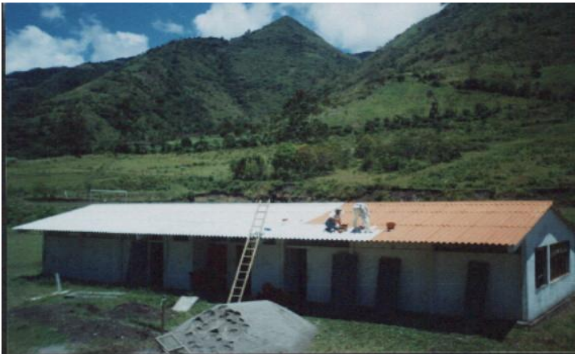
Figura 7. Cubierta Bloque N° 2 en proceso de pintura
