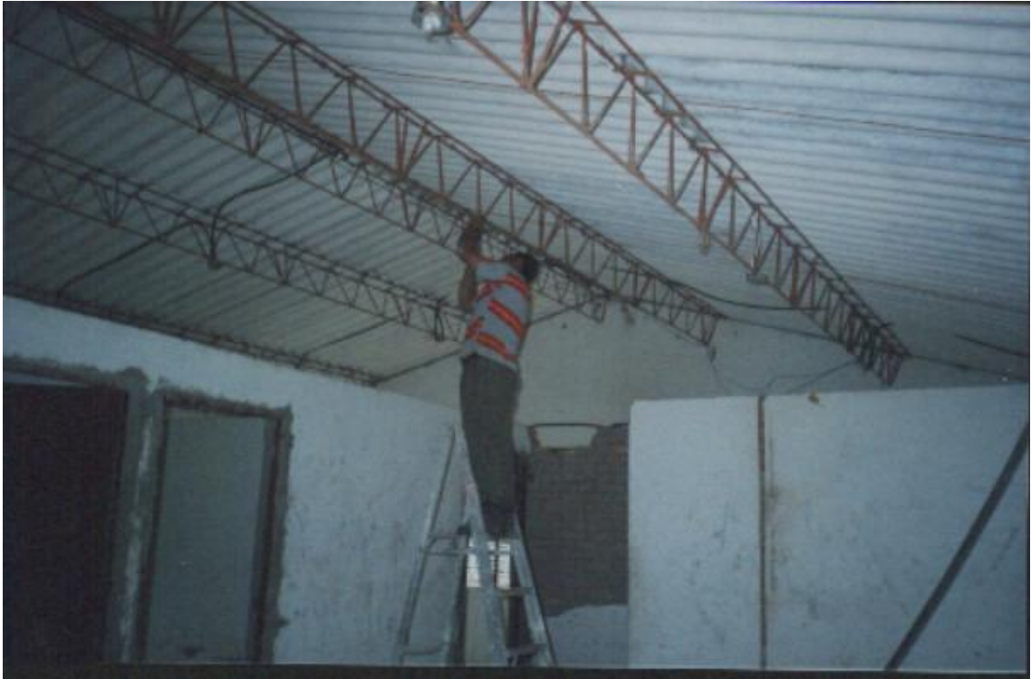
Figura 15. Reposición de tubería y cableado de ductos
