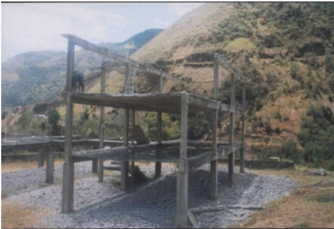
Figura 44. Demolición placa maciza estructura de tres pisos
