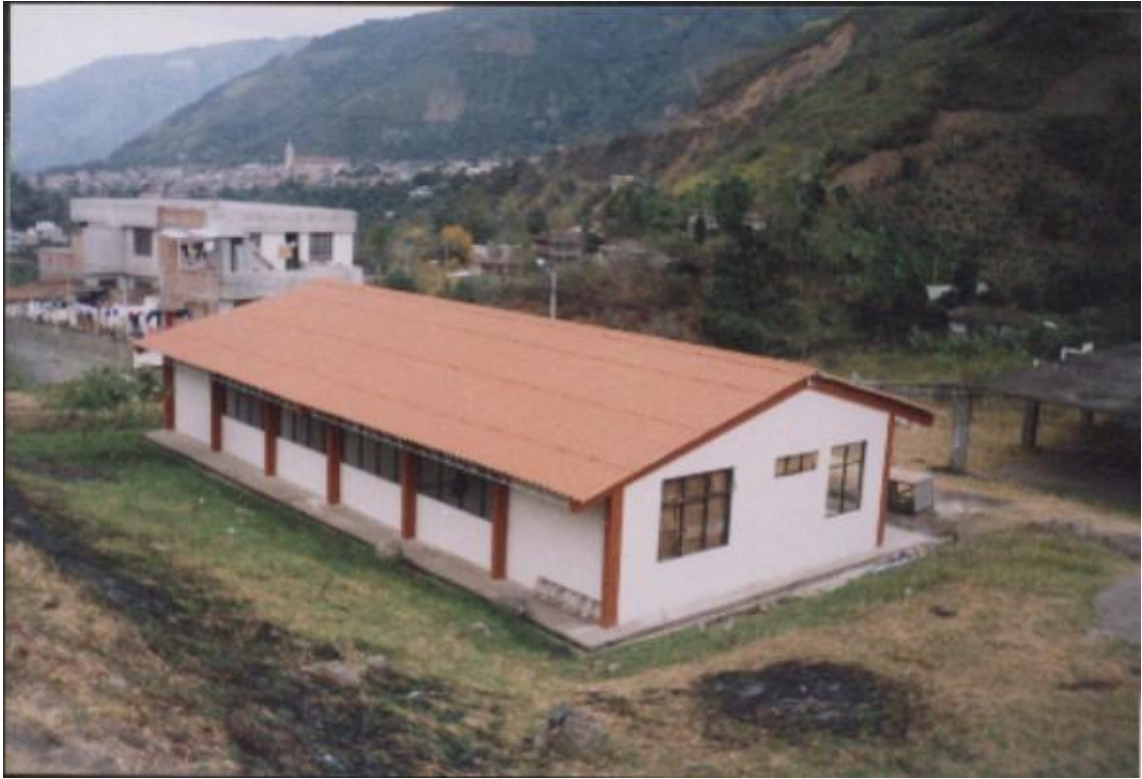
Figura 25. Pintura interior y exterior terminada Bloque administrativo
