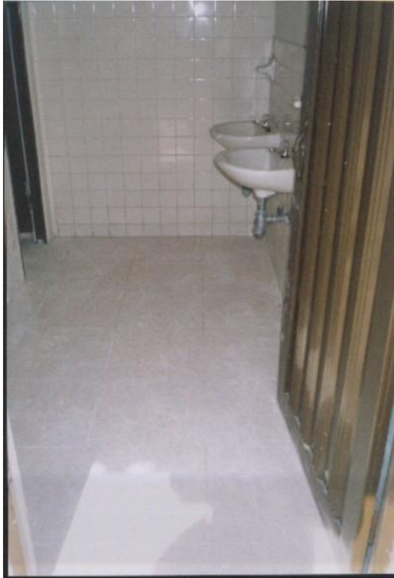
Figura 34. Batería sanitaria terminada
