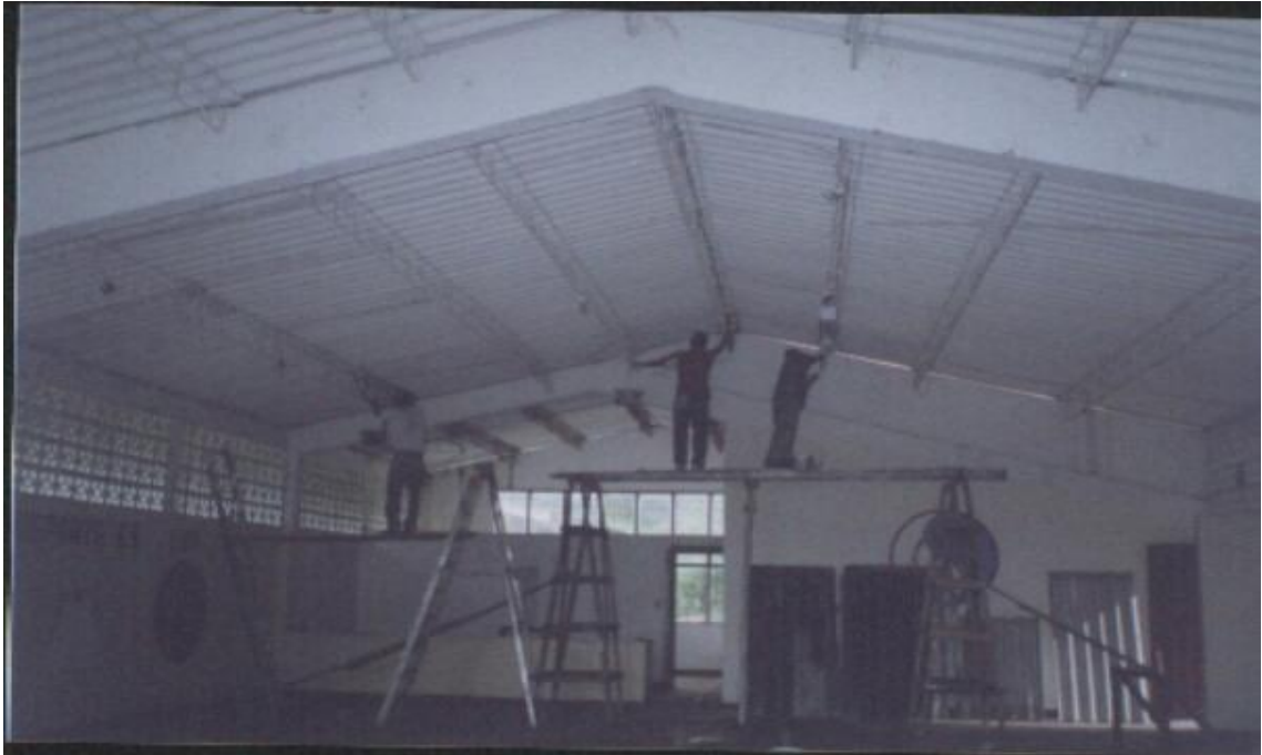
Figura 12. Cubierta Aula Múltiple pintura interior tejas y cerchas
