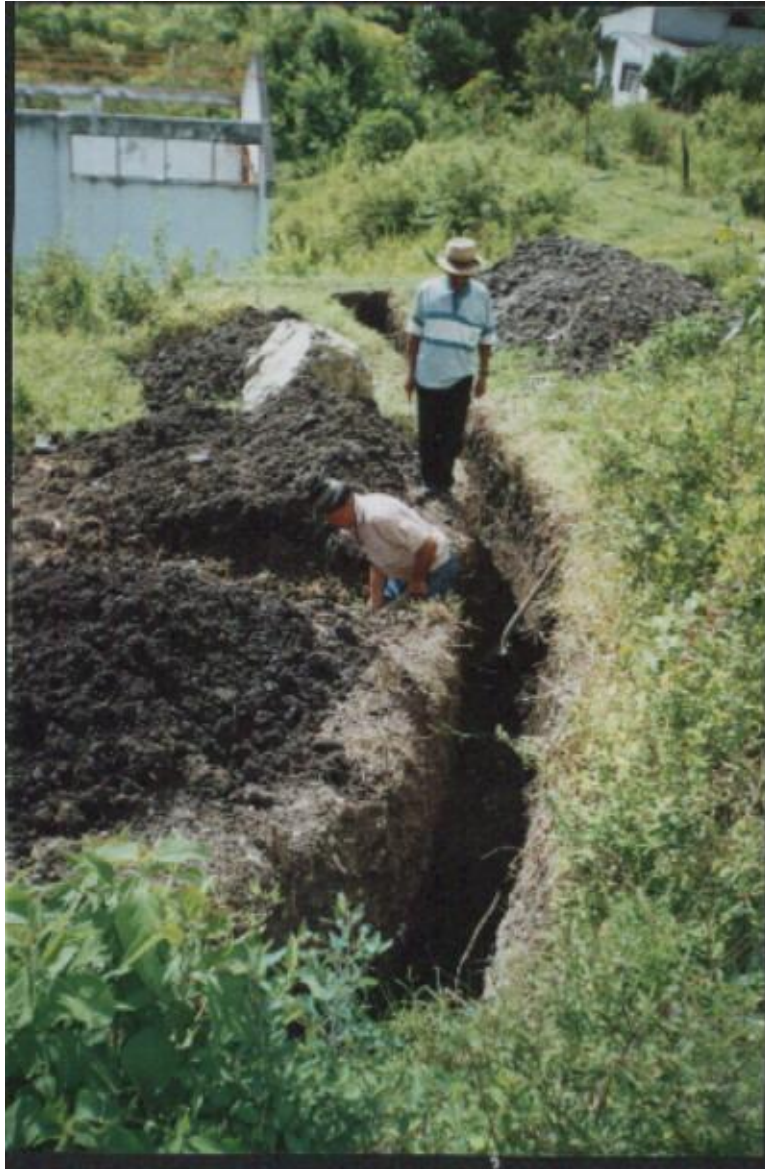
Figura 21. Búsqueda de tubería principal de \phi 2"
