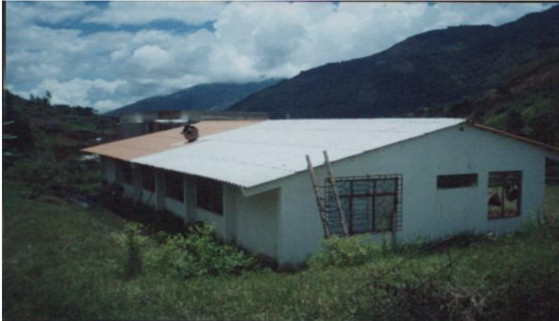
Figura 4. Cubierta Bloque Administrativo en proceso de pintura
