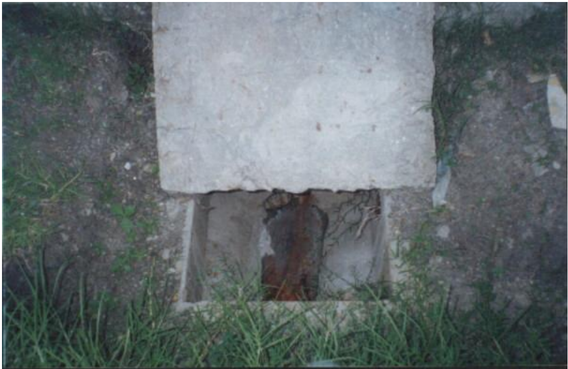
Figura 17. Caja de inspección antes del sondeo
