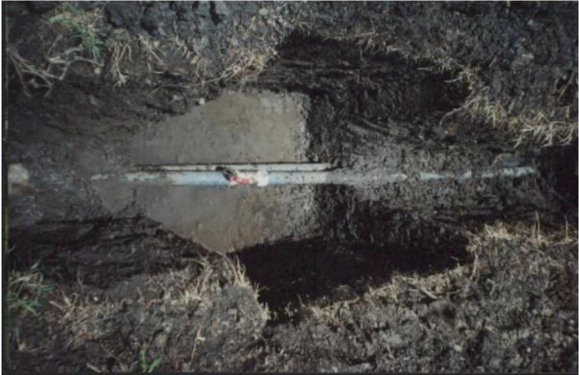
Figura 22. Instalación de llave de paso \phi 2" Acometida principal
