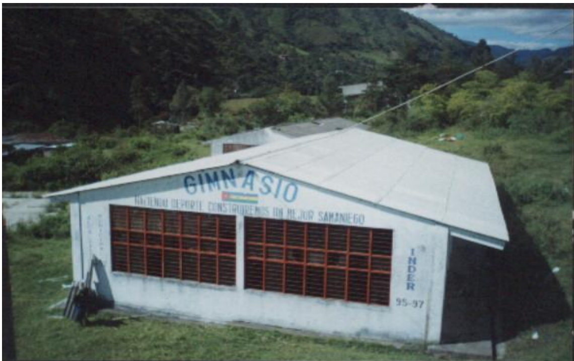
Figura 11. Cubierta Aula Múltiple reparada y limpia
