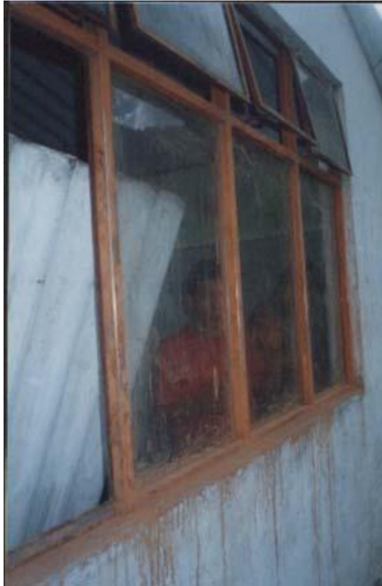
Figura 23. Lijado de marcos de ventanas Bloque Administrativo
