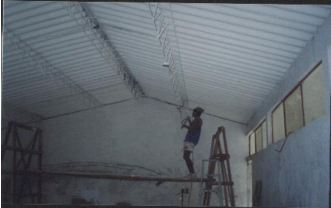
Figura 8. Pintura interior, cerchas y cielo raso
