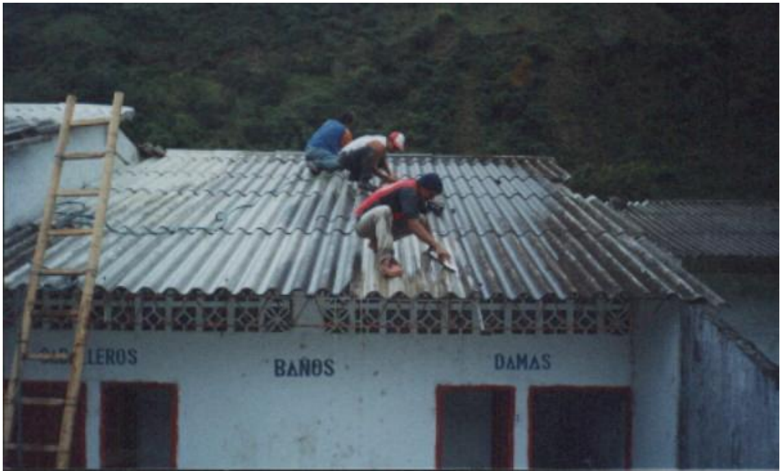
Figura 2. Limpieza de tejas con agua, detergente y cepillo plástico
