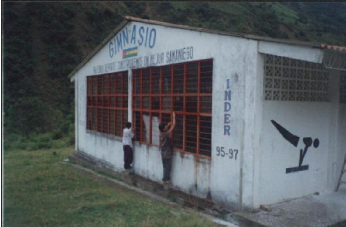
Figura 24. Lijado de marcos de ventanas y retiro de vidrios
