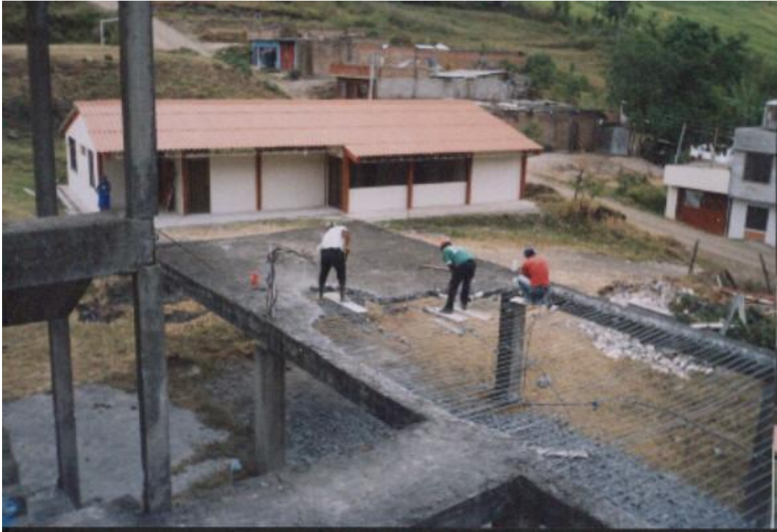
Figura 43. Demolición placa maciza edificio de un piso
