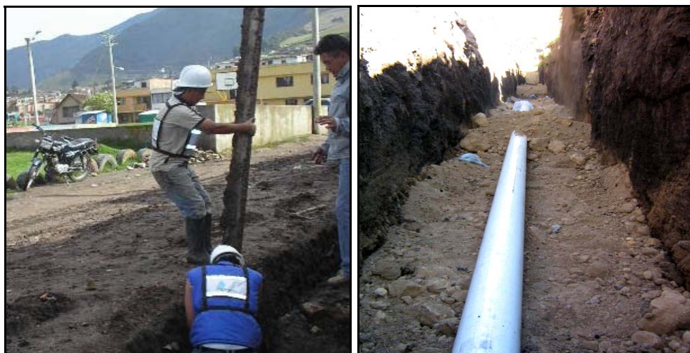
FIGURA 49.- Retiro de tubería existente en Asbesto Cemento e instalación de PVC D=3"
