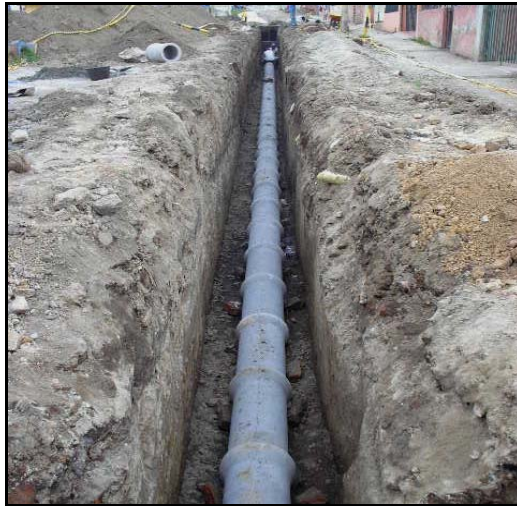
FIGURA 42.- Instalación de tubería de concreto D=10'' clase I
