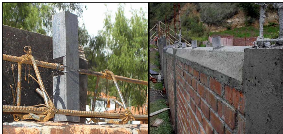
FIGURA 30.- Detalle de refuerzo de viga dintel y viga terminada
