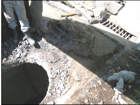
FIGURA 1.-Demolición de box coulvert y muro en concreto reforzado
