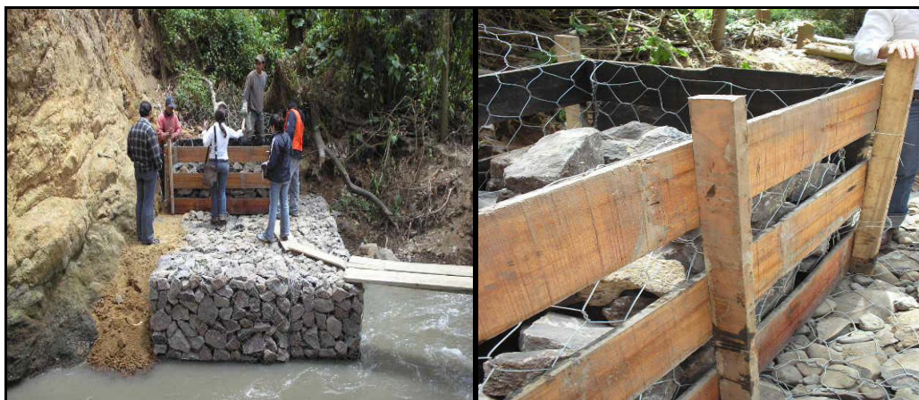
FIGURA 19.- Localización de gaviones y formaleta.
