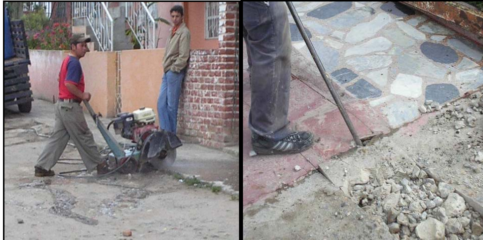
FIGURA.47.-Corte de Andén en concreto rígido y demolición para acometidas domiciliarias
