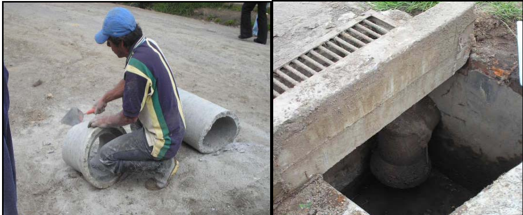
FIGURA 84.- Preparación de codo y codo terminado.
