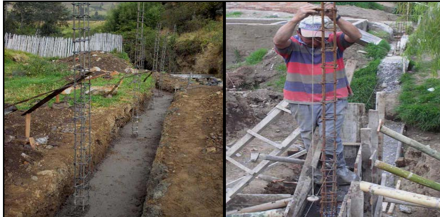
FIGURA 27.-Parado de columnas y aplome de las mismas.
