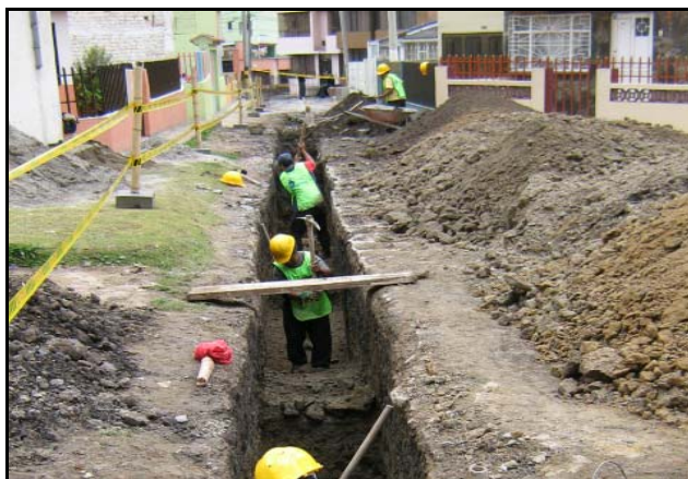
FIGURA 55 .-Excavación en material común sin entibado
