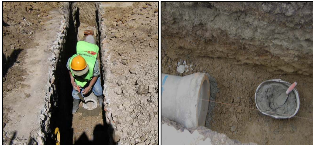
FIGURA 57.-Revoque e instalación de tubería
