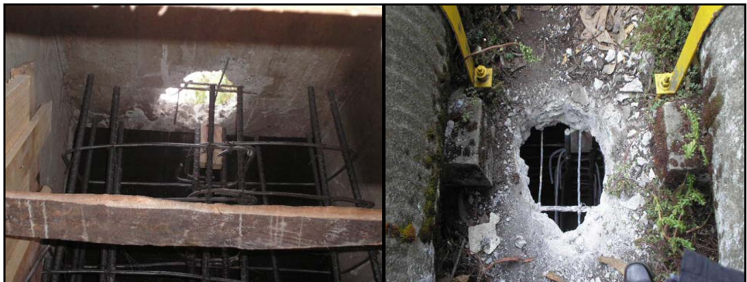
FIGURA 17.- Vista inferior y superior de boquete para fundición de pantalla.
