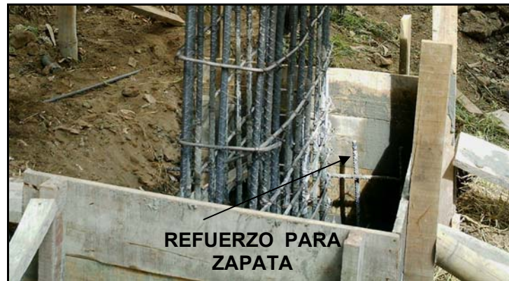
FIGURA 14.- Formaleta y armado de refuerzo para fundición de Zapata.
