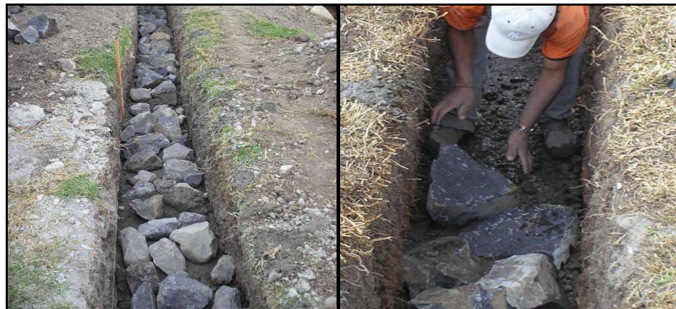
FIGURA 26.-Colocación de Rajón para concreto ciclópeo.
