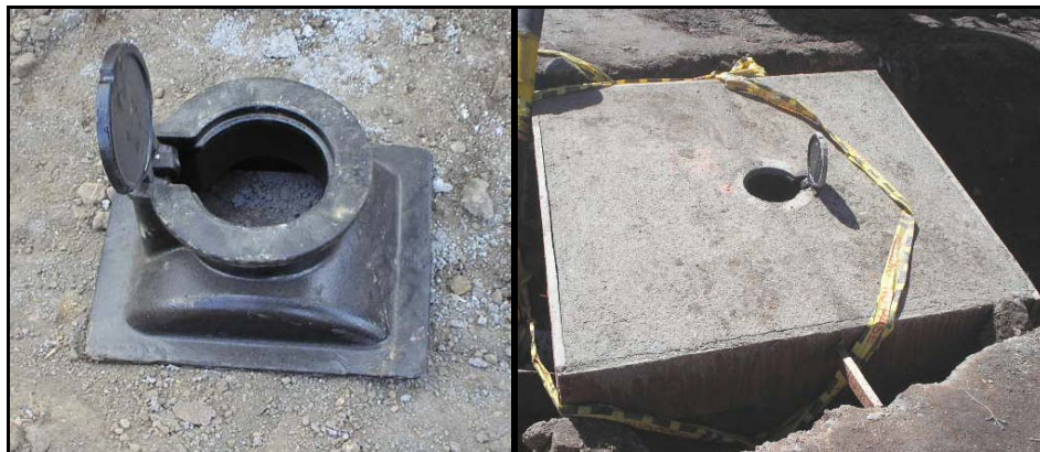
FIGURA 53.-Tapa tipo chorote Aya Trafico pesado y caja válvula con chorote instalada
