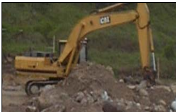
FIGURA 40.- Excavación en material común con Retroexcavadora sobre orugas
