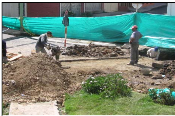
FIGURA 6.- Aislamiento perimetral con Aligflex
