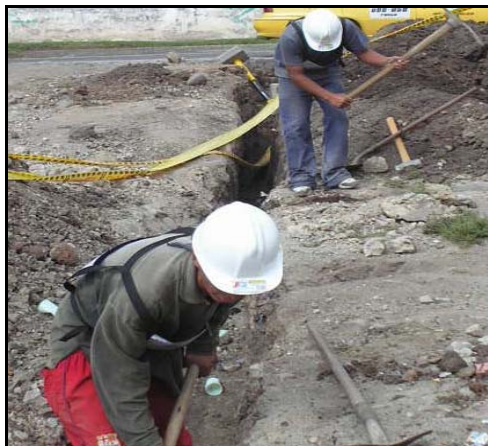
FIGURA 48.-Excavación en material común
