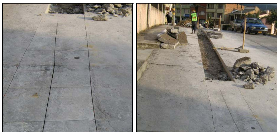
FIGURA 64.- Corte de pavimento rígido en varias secciones y demolición a mano
