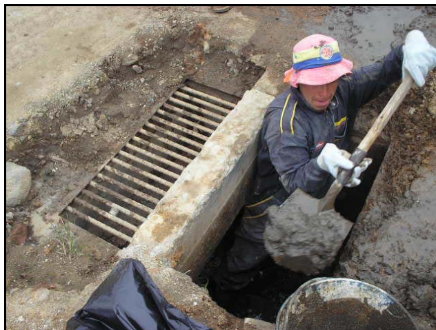
FIGURA 81.- Limpieza de Sumideros
