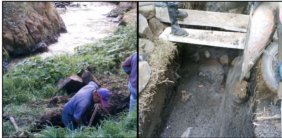
FIGURA 13.- Excavación y fundición de plinto en concreto ciclópeo
