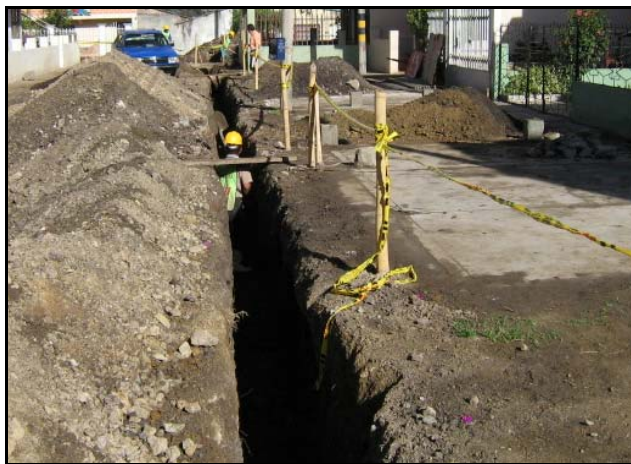
FIGURA 70.-Excavaciones para tubería de acueducto en ramal tres.
