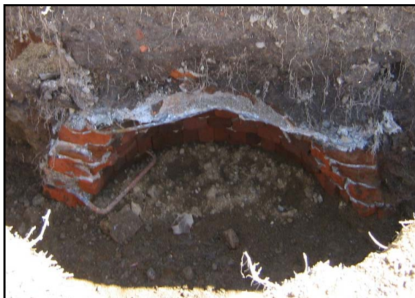
FIGURA 56 .-Demolición de camara existente.
