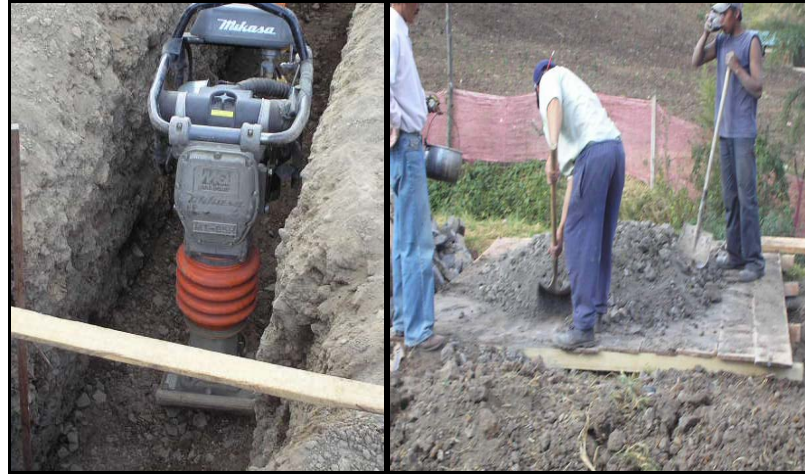
FIGURA 25.-Mejoramiento de piso y compactación con apisonador de impacto
