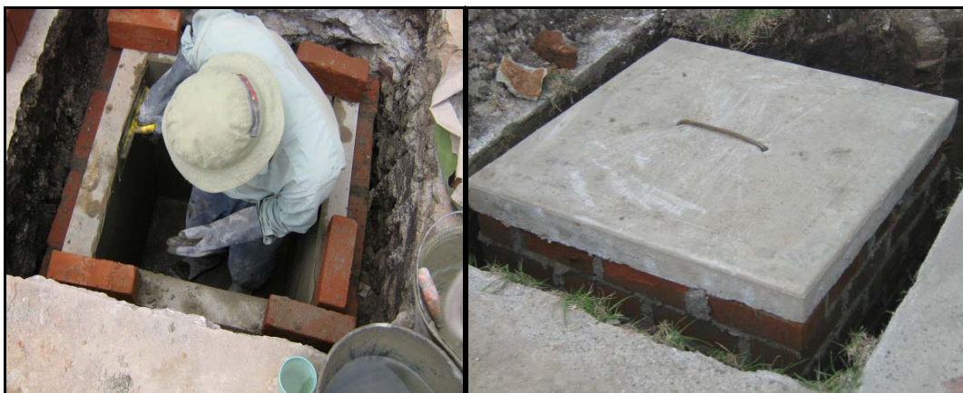
FIGURA 59. -Construcción de cajilla de inspección y cajilla terminada con tapa en concreto de 3000 psi.
