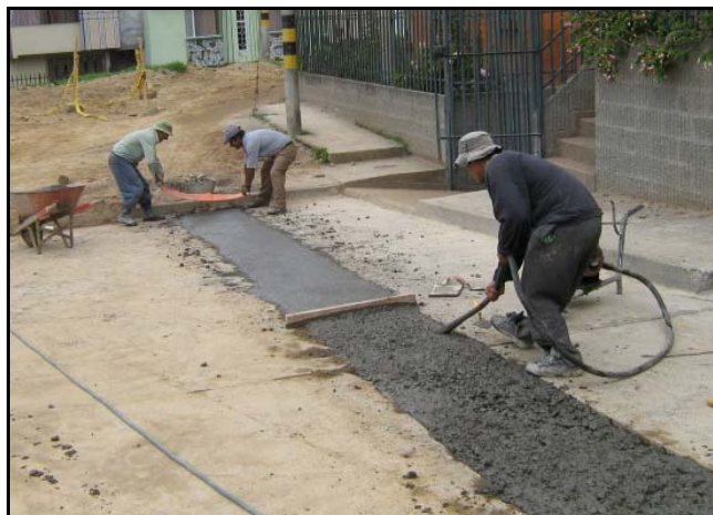
FIGURA 66.-Fundición y vibrado de pavimento.
