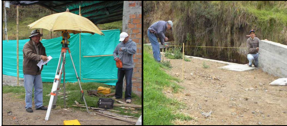
FIGURA 21.- Localización y replanteo
