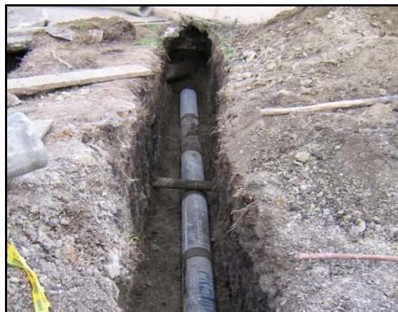
FIGURA 58.-Instalación de tubería domiciliar D=3"
