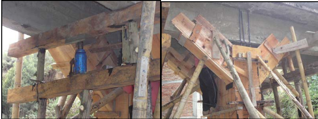
FIGURA 18.- Alza prima de recuperación Vista inferior y superior de boquete para fundición de pantalla.
