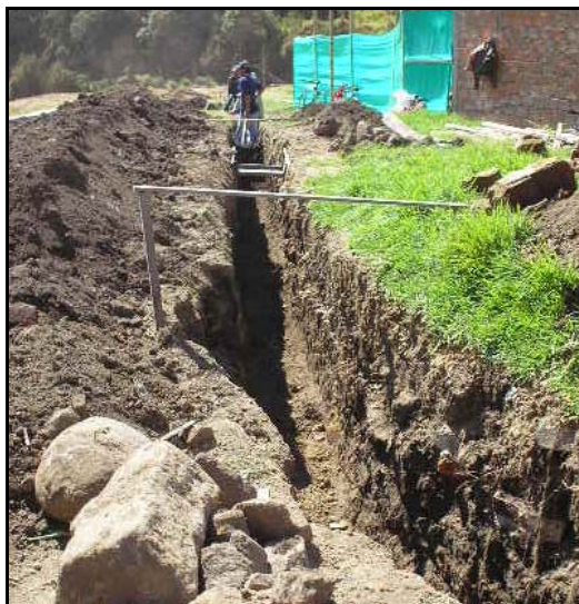
FIGURA 24.-Excavación en material común con h promedio de 1.60 m
