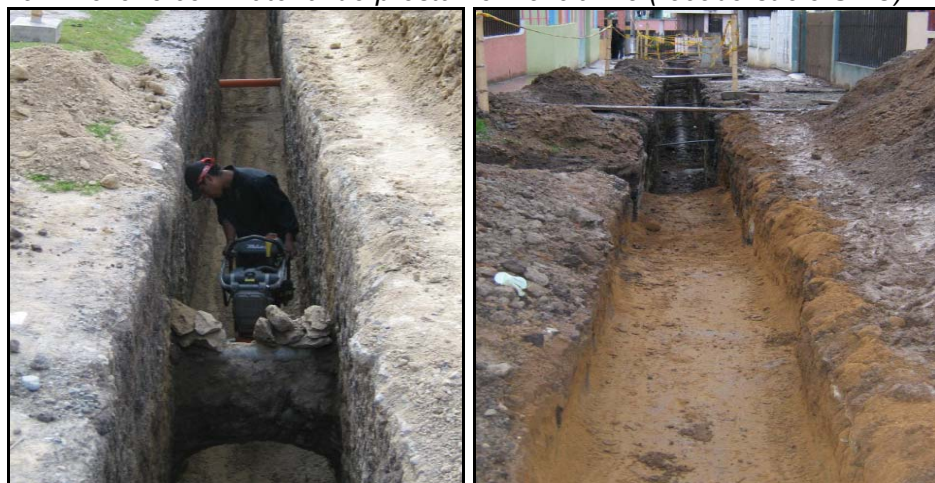
FIGURA 62.-Relleno con material de préstamo mezcla 1:5 (recebo-suelo SMC)
