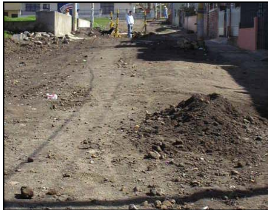
FIGURA 46. Alcantarillado terminado y señalización únicamente en cámaras
