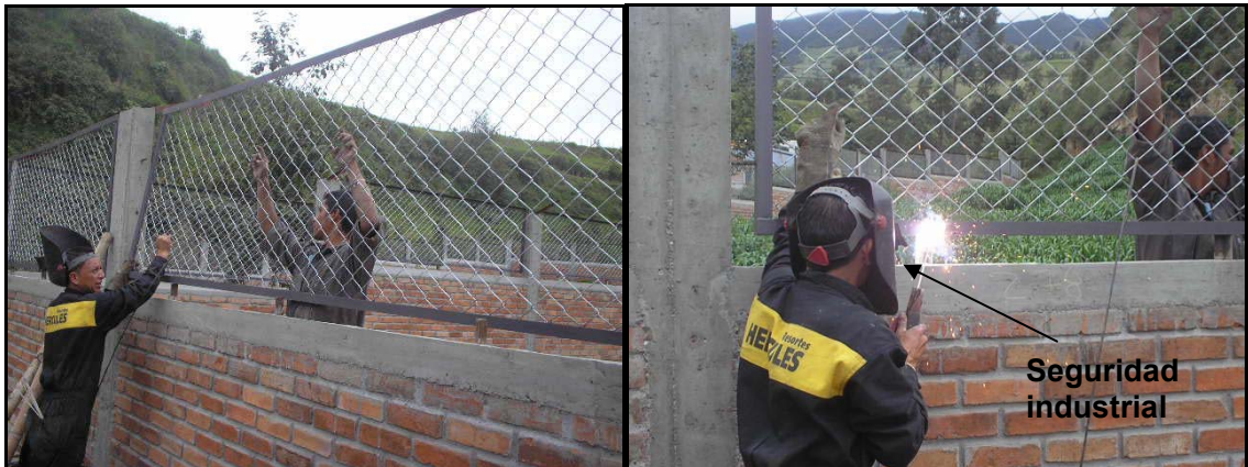
FIGURA 33.-Instalación y soldadura de malla eslabonada
