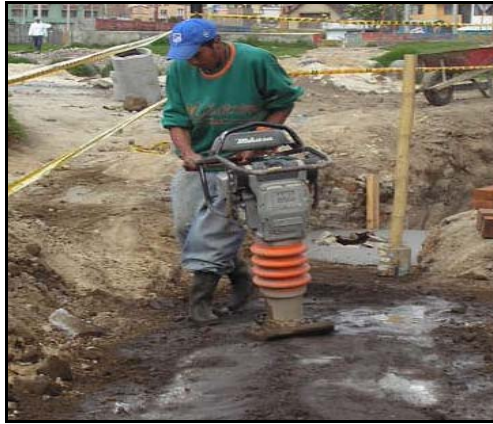
FIGURA 45.-Compactación mecánica
