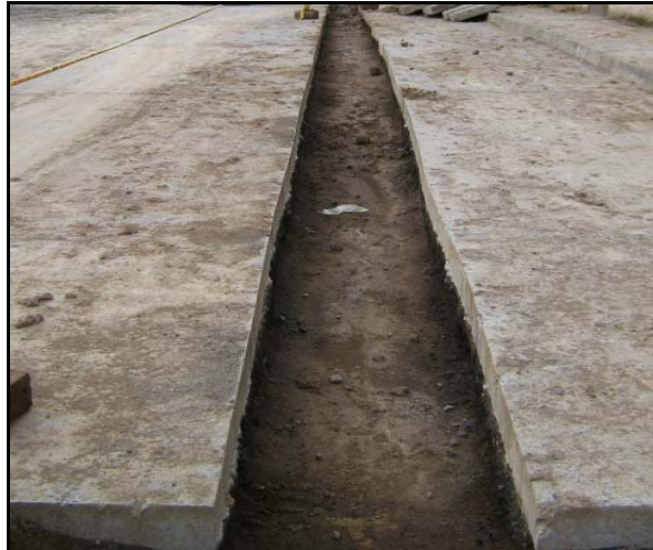
FIGURA 65.-Colocación de 25 cm de base para pavimento.
