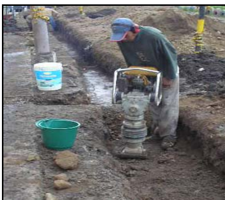
FIGURA 54.-Relleno con recebo compactado mecánicamente.
