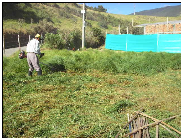
FIGURA 22.- Desmonte y Limpieza
