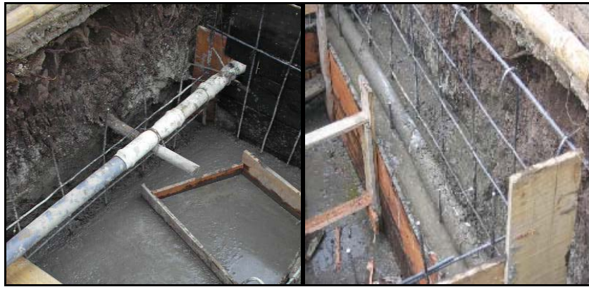
FIGURA 7.- Red de acueducto por andén y dentro de sumidero antes y después de la protección.
