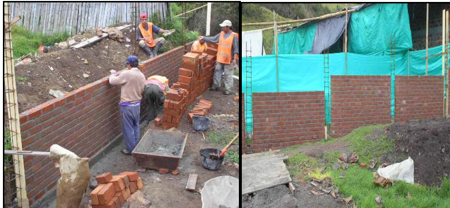
FIGURA 29- Levantamiento de muro y mampostería terminada con h=1.42m .
