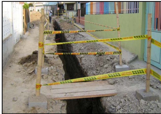
FIGURA 61.-Señalización con cinta preventiva y colombinas en guadua
