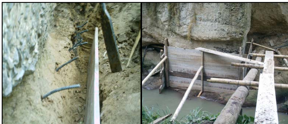
FIGURA 11.- Instalación de Anclaje y formaleta para recalce
