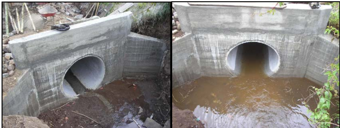
FIGURA 36.-Cabezales y aleta terminados
