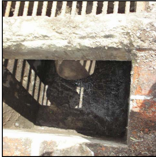
FIGURA 82.- Sumidero completamente limpio
