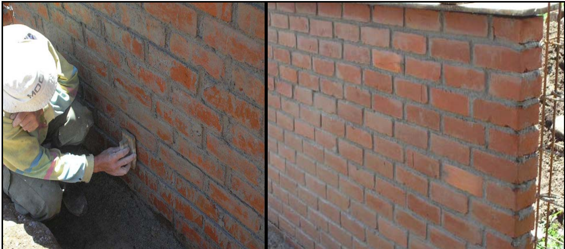
FIGURA 31.- Acabado de muro y muro a la vista
