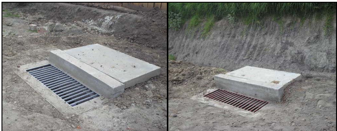
FIGURA 87.- Sumideros completamente terminados y alineados con rasante de futuro pavimento.
