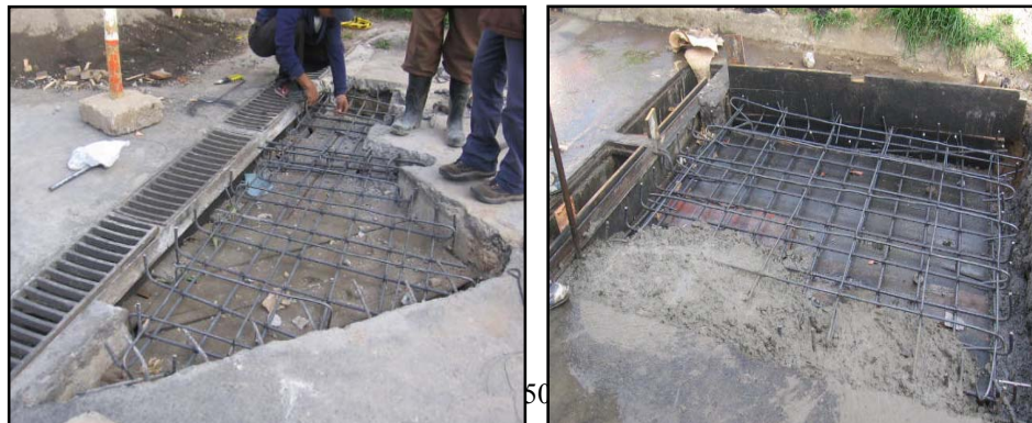
FIGURA 8.- Reposición de placa de concreto reforzado en empalme a cámara de sumidero transversal y conexión a box culvert.
