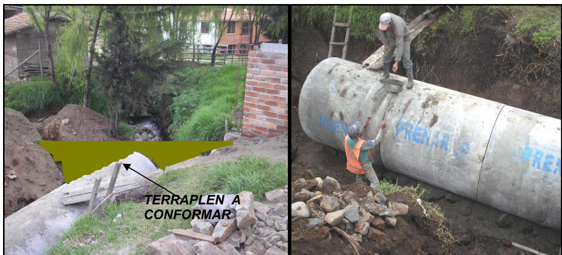
FIGURA 34.-Instalación de tubería de 60" para canalización de quebrada
