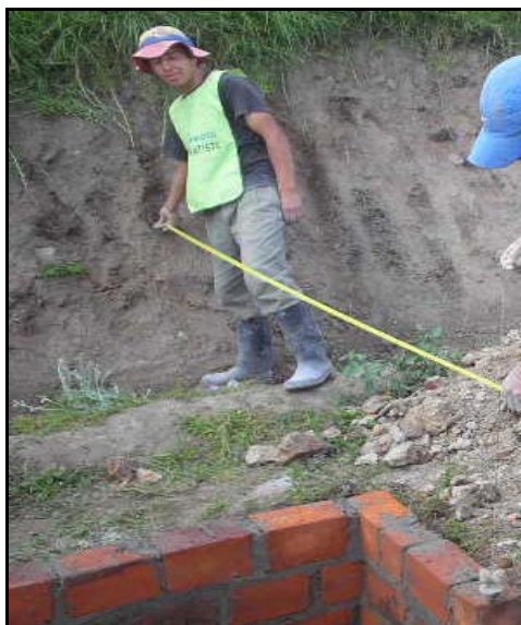
FIGURA 85-Verificación de localización de sumideros
