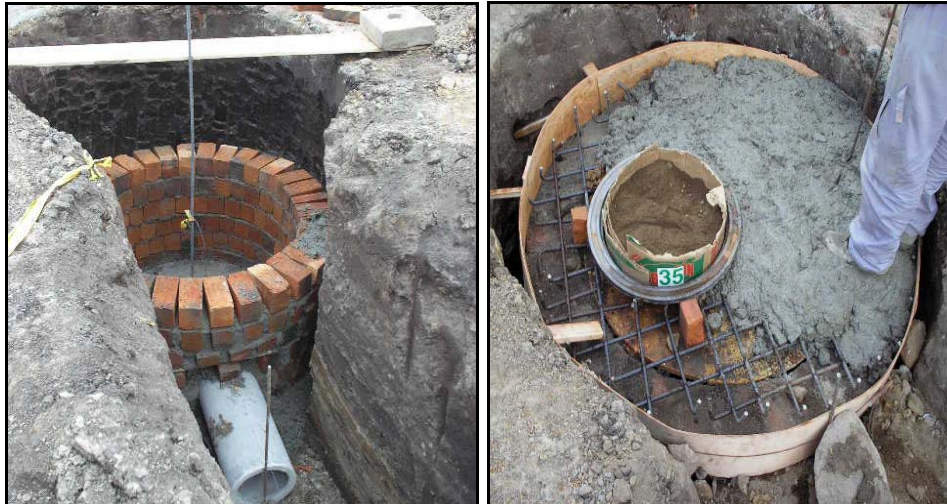
FIGURA 44- Construcción camara de inspección cilíndrica y construcción de tapa.
