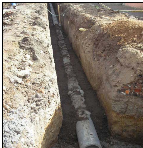
FIGURA 43.- Cimentación, atraque de la tubería y compactación con pison de mano.
