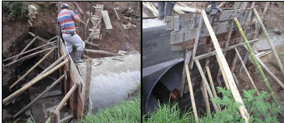
FIGURA 35.-Formaleta para cabezales y aletas.
