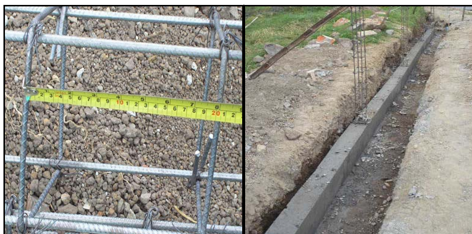
FIGURA 28-Verificación de distancia entre flejes y viga terminada
