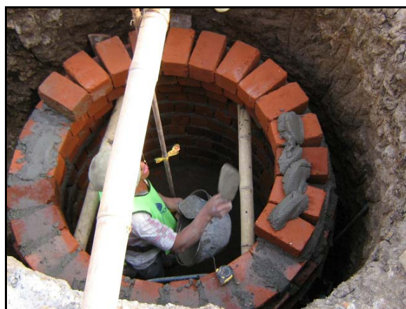
FIGURA 60. -Construcción cámara de inspección tipo cilíndrica.
