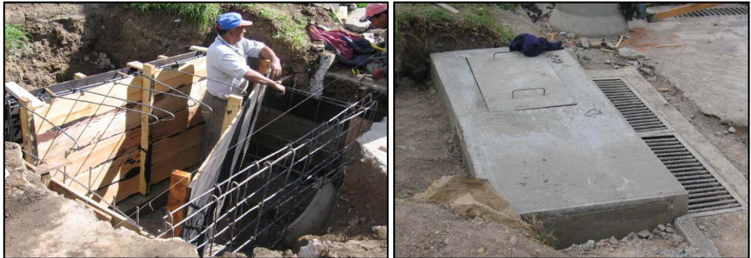
FIGURA 5.- Etapa constructiva del sumidero y sumidero terminado
