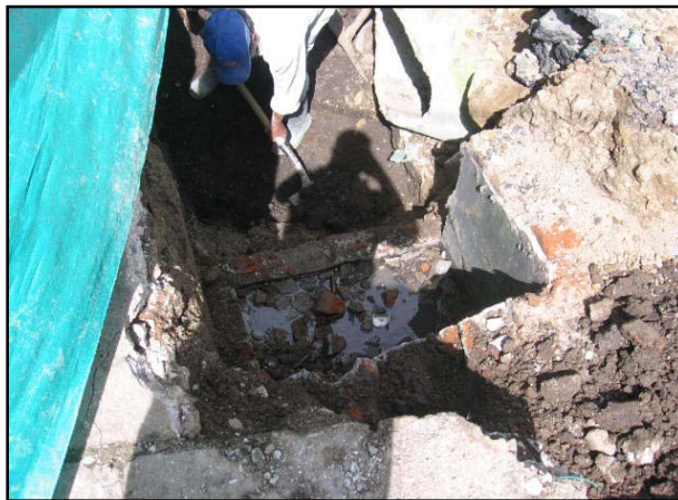
FIGURA 2.-Demolición de sumidero existente debido a baja capacidad de captación.
