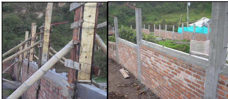
FIGURA 32.- Formaleta y vista general de viga dintel, mampostería y columnas
