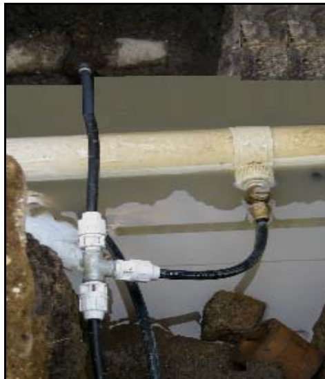
FIGURA 72.-Llenado de Tubería nueva con acometida de tubería existente en AC
